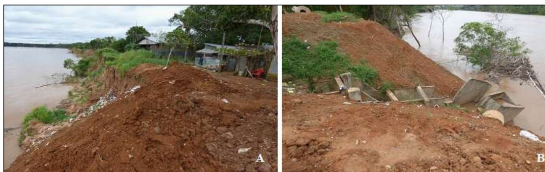
Figura 7.4 Vistas de la erosión fluvial en la margen izquierda del río Tambopata, en una extensión de 1100 m. Como se observa: (A) las viviendas se encuentran de 8 a 35 m de distancia hacia el borde del río; (B) debido a la constante erosión y a la intervención del hombre, colapsó un colector construido para evacuar el drenaje de precipitaciones que además fue usado por los pobladores de la zona como desagüe, que aceleró el proceso de erosión.
