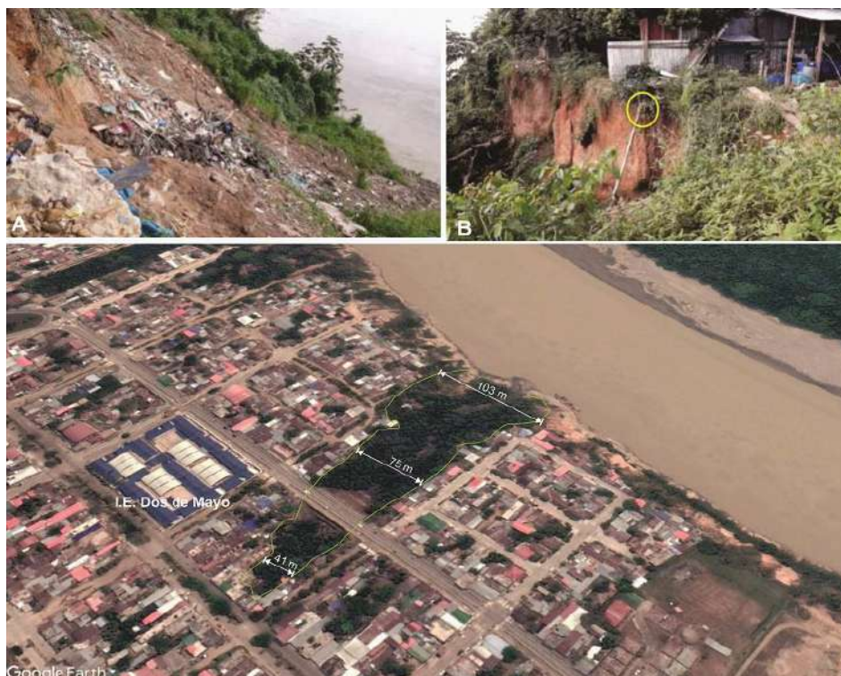
Figura 7.5 A) Erosión fluvial en la margen derecha del río Madre de Dios. B) Formación de pequeños surcos generados por la escorrentía superficial y la filtración de agua de las tuberías que se encuentran en pésimas condiciones. C) Dimensiones de la cárcava El Balcón.
