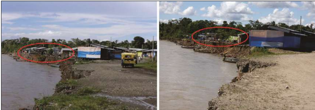
Figura 7.14 Vistas del sector Sarayacu, como producto de la erosión fluvial-inundación colapsaron 27 viviendas. La inundación llegó hasta el sector Virgen de la Candelaria, km 338 de la carretera Interoceánica.
