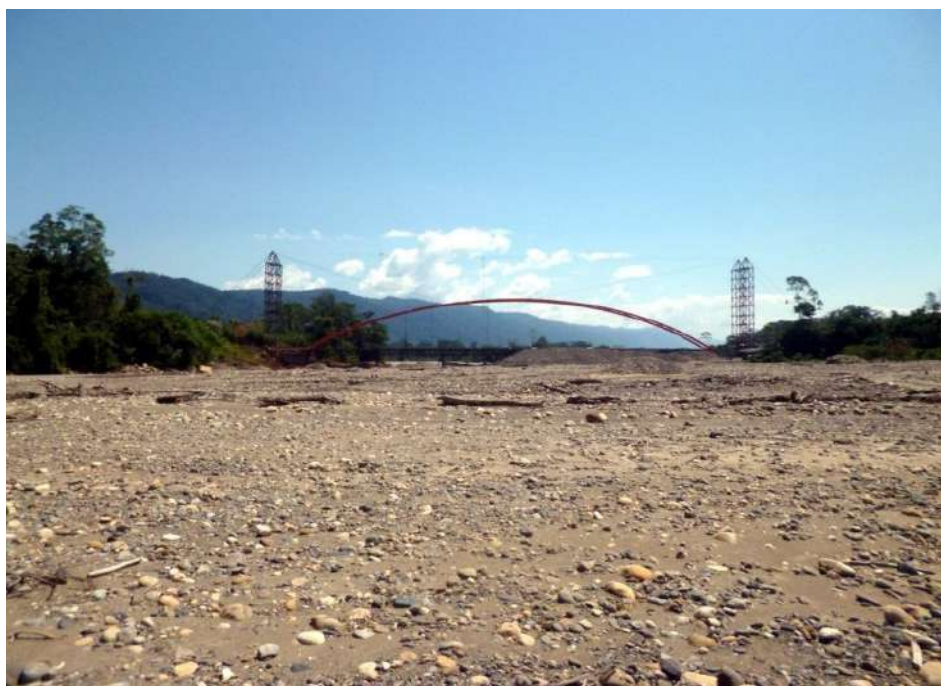
Fotografía 7.3 Vista aguas abajo del río Carbón. Se puede observar el nuevo puente vehicular que se está construyendo. Este debe contar con buenas defensas ribereñas en los estribos del puente, los cuales deben estar muy bien cimentados para que resistan los caudales que discurren por el río.
