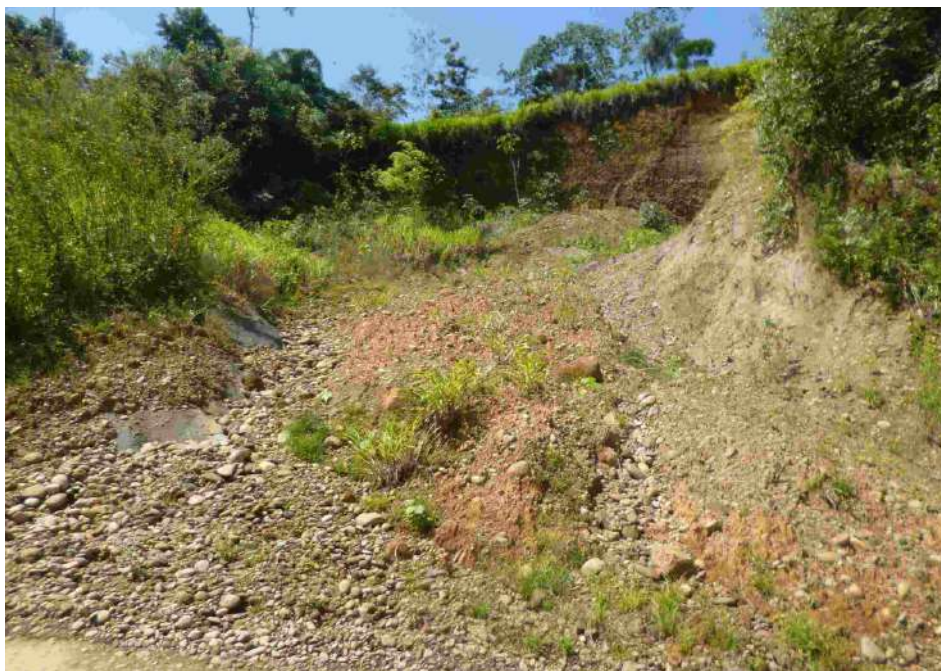
Fotografía 6.2 Derrumbe carretera Shintuyo, distrito Manu (coordenadas UTM 8598008 N- 245241 E)
