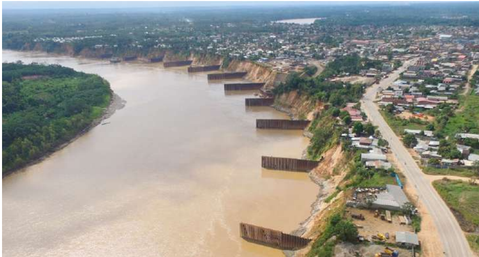
Fotografía 4.9 Defensa ribereña en base a espigones metálicos en la margen derecha de río Madre de Dios, sector La Pastora-Puerto Maldonado
