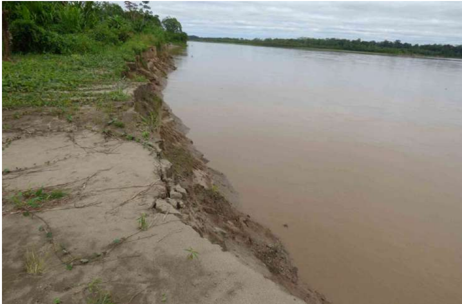
Fotografía 6.13 Erosión fluvial, margen derecha del río Madre de Dios confluencia con el río de Las Piedras, sector Boca Piedras (coordenadas UTM: 861797 N – 476709 E)
