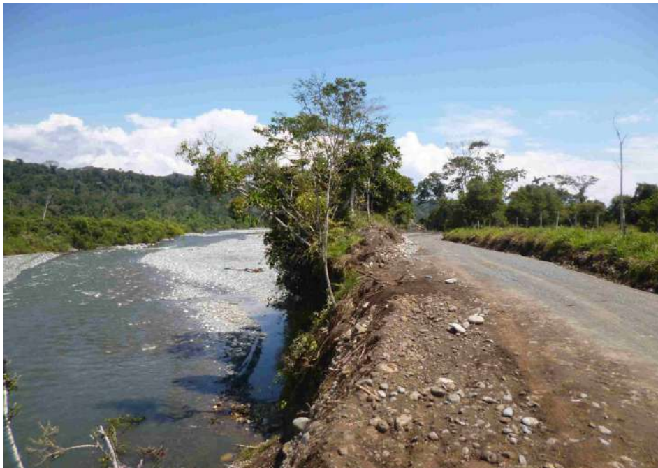
Fotografía 6.10 Erosión fluvial, margen derecha del río Queros, produce pérdida de plataforma de carretera afectando 300 m de longitud.
