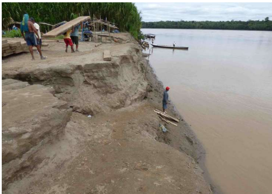
Fotografía 6.12 Erosión fluvial, margen izquierda del río Madre de Dios, sector puerto Arturo (8618687 N - 476850 E)
