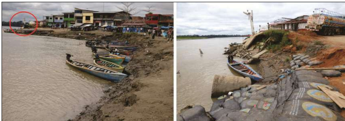
Figura 7.13 Vistas del Puerto Laberinto debido a la erosión fluvial de 200 m de longitud. Colapsó un grifo, se colocó costales de arena a fin de mitigar dicho proceso.
