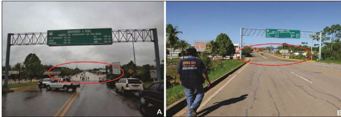
Figura 7.19 A) Inundación del año 2012, Av. León Velarde afectada (tomada por Indeci). B) Vista del desnivel de la carretera Interoceánica, parte del casco urbano de la ciudad de Iñapari, próxima al puente Internacional (Av. León Velarde). Se encuentra por debajo del área que ocupa el meandro del río Acre, lo cual favorece el embalsamiento en la época de lluvias intensas.
