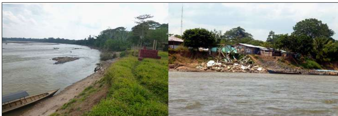
Figura 7.24 Proceso erosivo en la margen izquierda del río Madre de Dios en el distrito de Boca Manu, produjo la pérdida de terrenos en la plaza principal y la destrucción de la comisaría del distrito.
