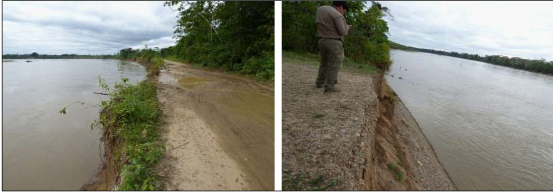
Figura 7.6 Erosión fluvial en la margen derecha del río Madre de Dios, sector Otilia. Se llevó tramo de carretera Cachuela Otilia-Puerto Arturo.
