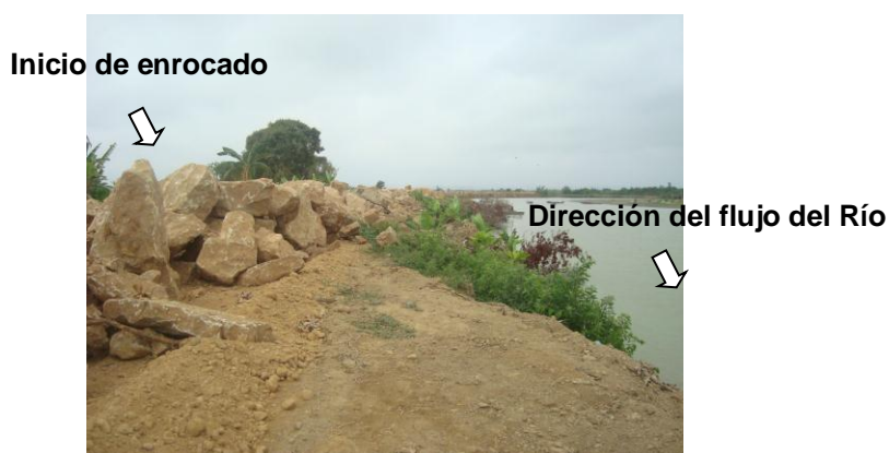
Foto N° 05.- Defensa en el sector Aguas Arriba del Progreso
