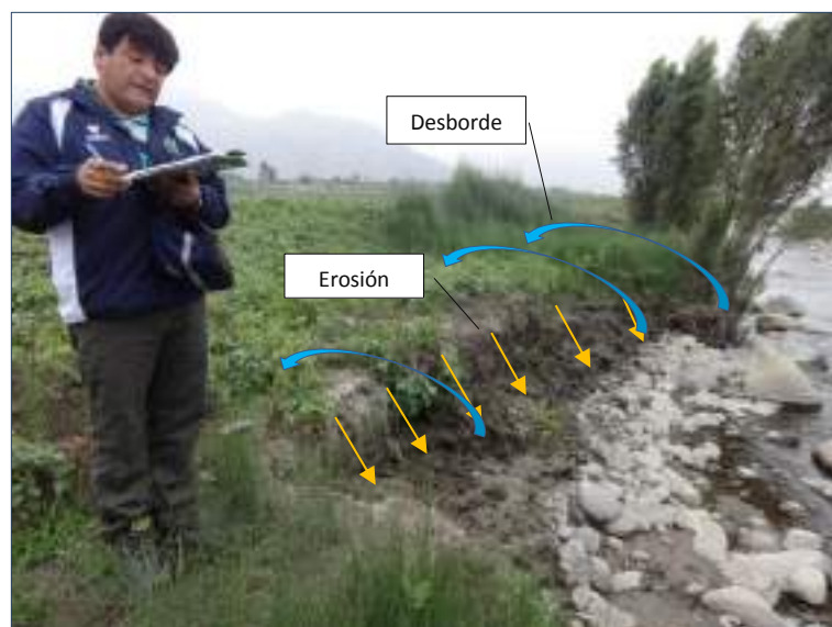
Figura 18, Punto crítico 19, sector las Huertas
