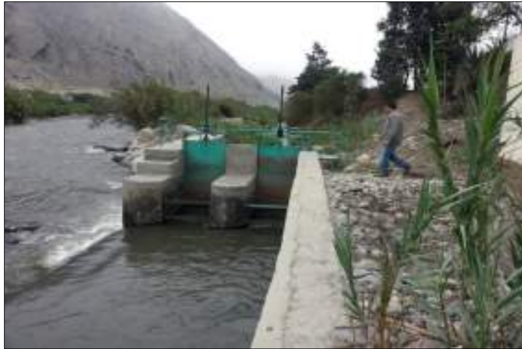
Figura 12. Estructura de captación
