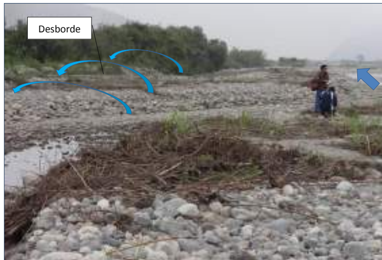
Figura 15. Punto crítico 16, sector Fundo Rosales
