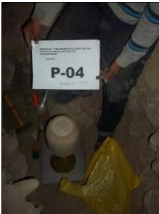
Figura 6. Excavación Exploratoria P-4 en el Sector Las Alpas, los materiales granulares corresponden a Gravas mal gradadas de clasificación SUCS GP
