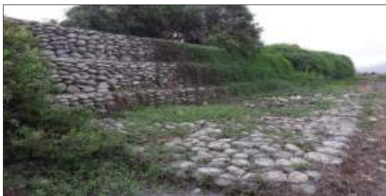
Figura 9. Dique longitudinal de gaviones
