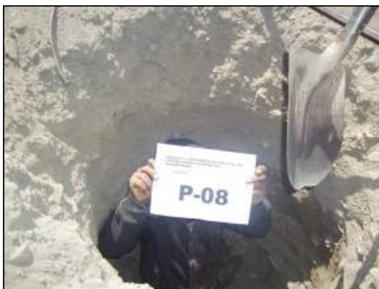
Figura 10. Excavación Exploratoria P-8 en el Sector Tres Cruces, los materiales granulares corresponden a Gravas arcillosas de clasificación SUCS GC
