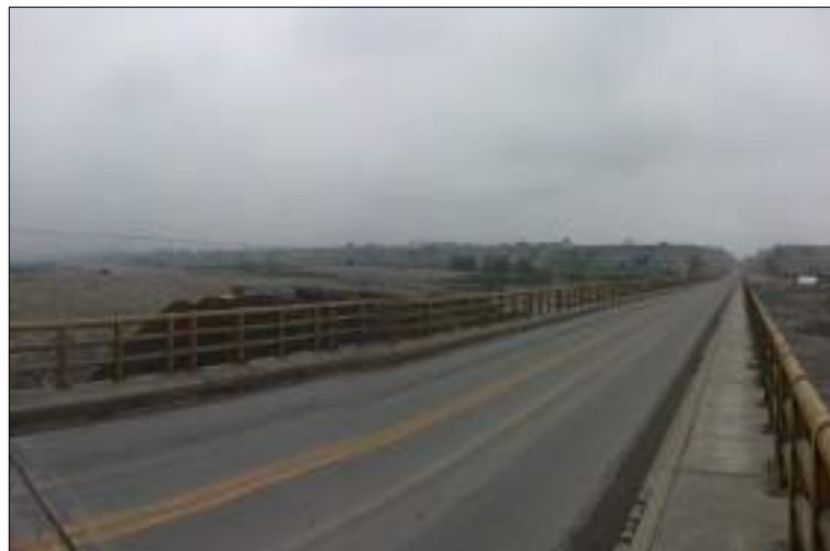
Figura 14. Puente vehicular sobre el río Pativilca
