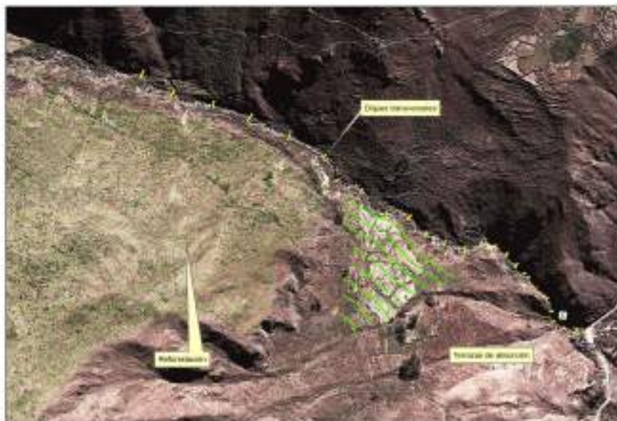
Figura 8. Obras de control y conservación de suelos
