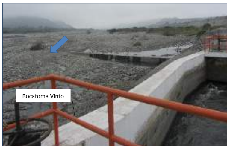
Figura 19. Punto crítico 20, sector Vinto
