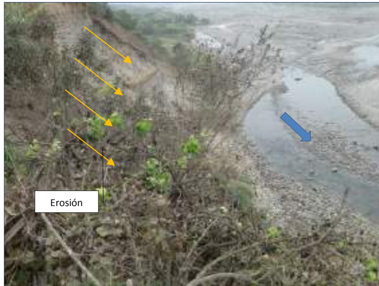
Figura 6. Punto crítico 06, sector Carretería
