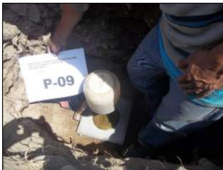
Figura 11. Excavación Exploratoria P-9 en el Sector Torrecilla Alta, los materiales granulares corresponden a Gravas arcillosas de clasificación SUCS GM, se observa el ensayo de densidad in situ
