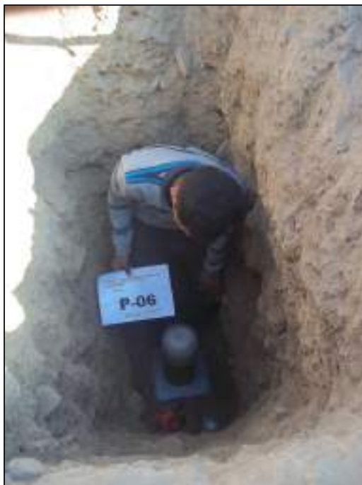
Figura 8. Excavación Exploratoria P-6 en el Sector San Telmo, los materiales granulares corresponden a Gravas limosas y arcillosas de clasificación SUCS GM-GC
