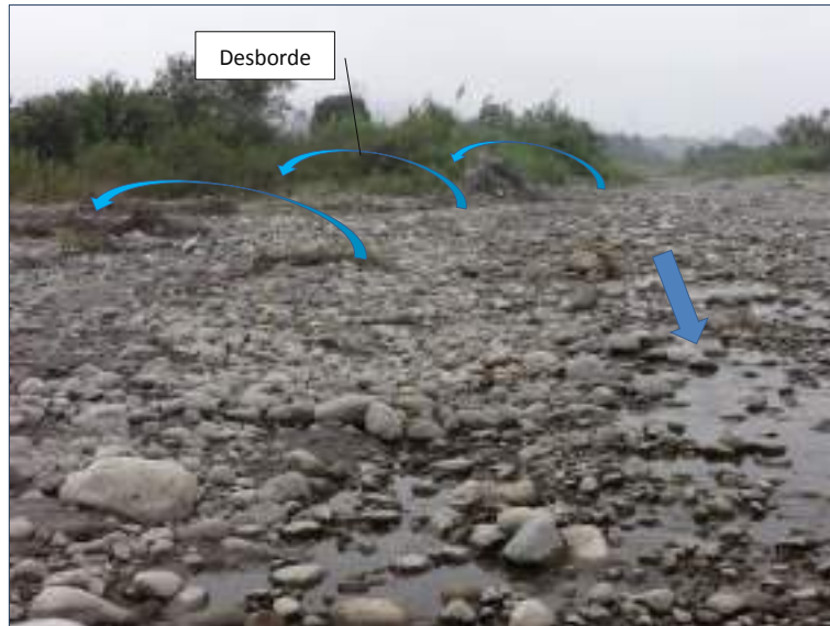
Figura 8. Punto crítico 08, sector Torrencia Baja
