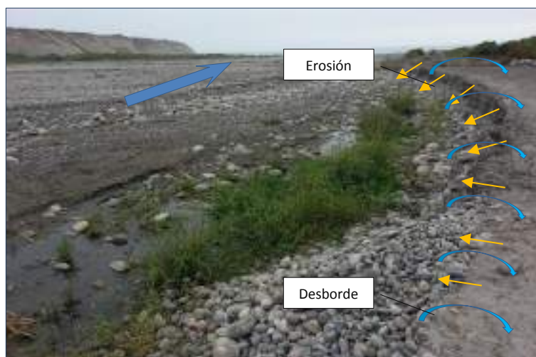
Figura 1. Punto crítico 01, riesgo de inundación y erosión
