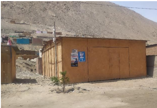
Figura 16. Viviendas de madera en estado de conservación regular del Sector 04.
