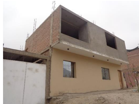
Figura 13. Vivienda de dos niveles del Sector 03.
