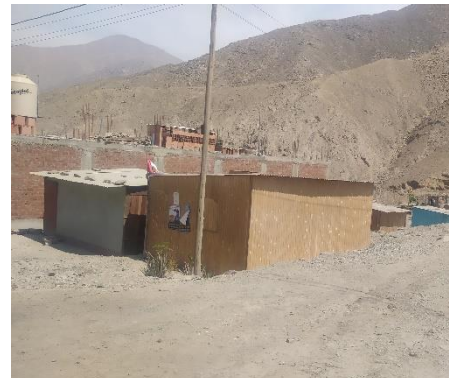
Figura 17. Viviendas de madera en estado de conservación malo del Sector 04.
