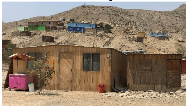
Figura 7. Vivienda de entramados de madera de un nivel del Sector 01.
