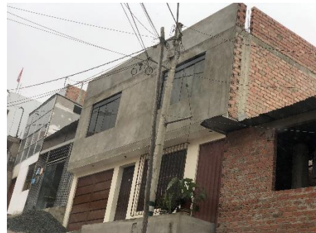
Figura 6. Vivienda de dos niveles del Sector 01.
