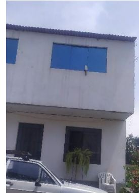
Figura 15. Vivienda de dos niveles del Sector 04.
