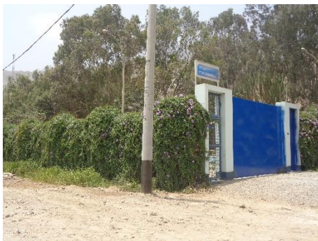
Figura 46. Planta de tratamiento de aguas residuales
