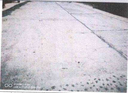
Fisuras y agrietamiento en el pavimento de la calle 28 de Julio.
