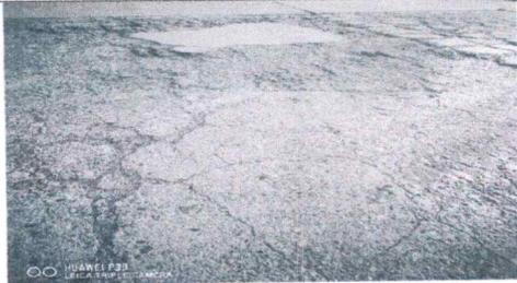
Colapso de concreto por el pase de vehículos pesados .
