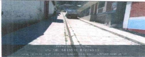
Colapso de concreto por lado de cunetas y juntas asfálticas producto de las aguas pluviales.
