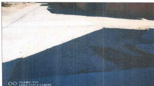
Paño de pavimento completamente colapsado, solo presenta material de base.
