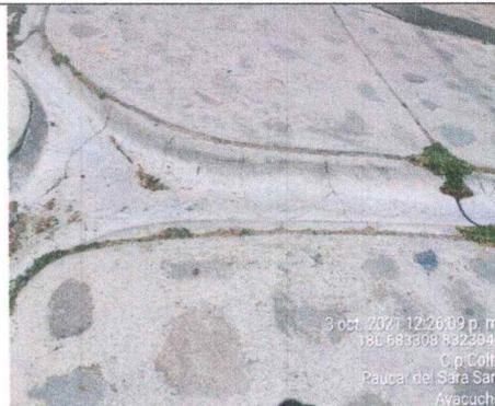
Colapso de losa de concreto por el paso de vehículos pesados y concreto de baja resistencia.
