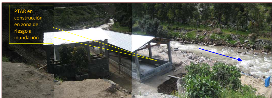
Figura 3. Planta de Tratamiento de Aguas Residuales construido en la ribera del río Rímac, por la municipalidad de Chicla
