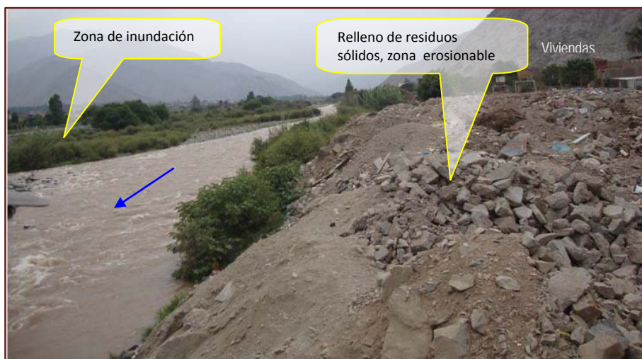
Figura 31. Riesgo de erosión en la margen izquierda
