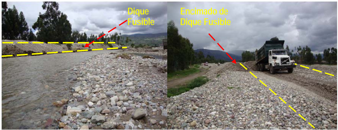
Figura 10. Conformación de dique fusible
