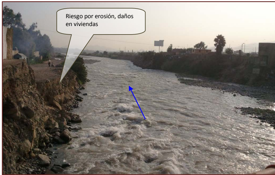
Figura 36. Daños en ambas márgenes por erosión
