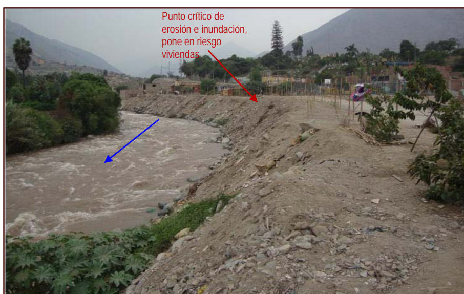
Figura 19. Margen izquierda del cauce es erosionable, suelo inestable
