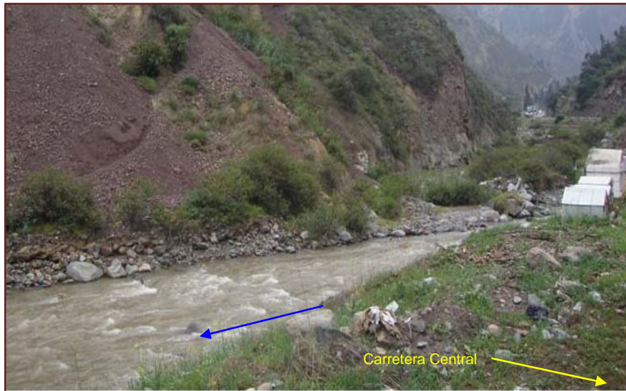
Figura 6. Riesgo de erosión e inundación de la Carretera Central
