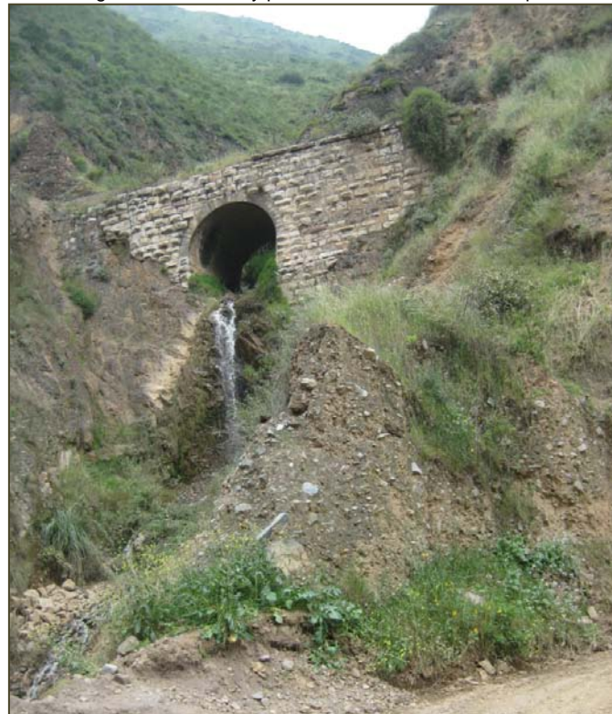
Figura 6. Vista de la quebrada Huallatupe
