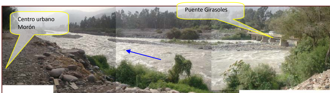
Figura 29. Riesgo de erosión e inundación de viviendas y puente
