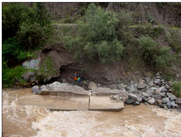
Figura 8. Excavación exploratoria C-3, se observan gravas arcillosas y limosas con arenas
