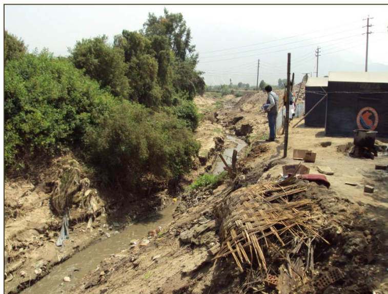
Figura 13. Vista de la quebrada Huaycoloro
