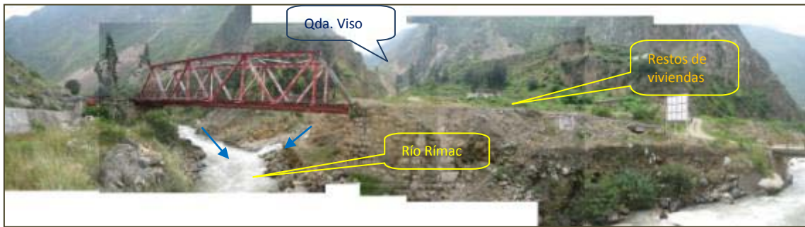
Figura 4. Vista de la quebrada Viso y río Rímac
