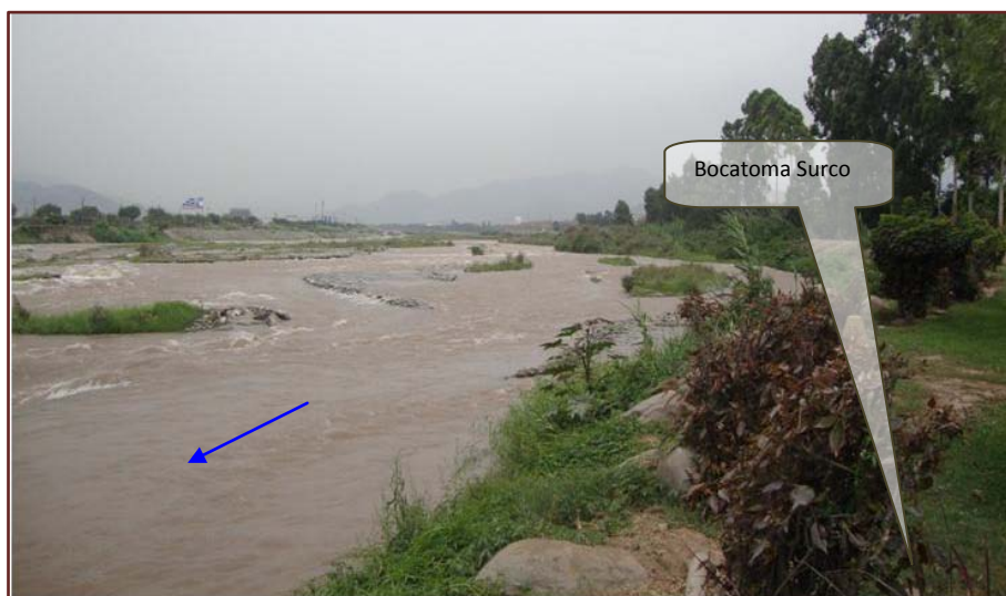
Figura 38. Riesgo de erosión e inundación de la bocatoma Surco
