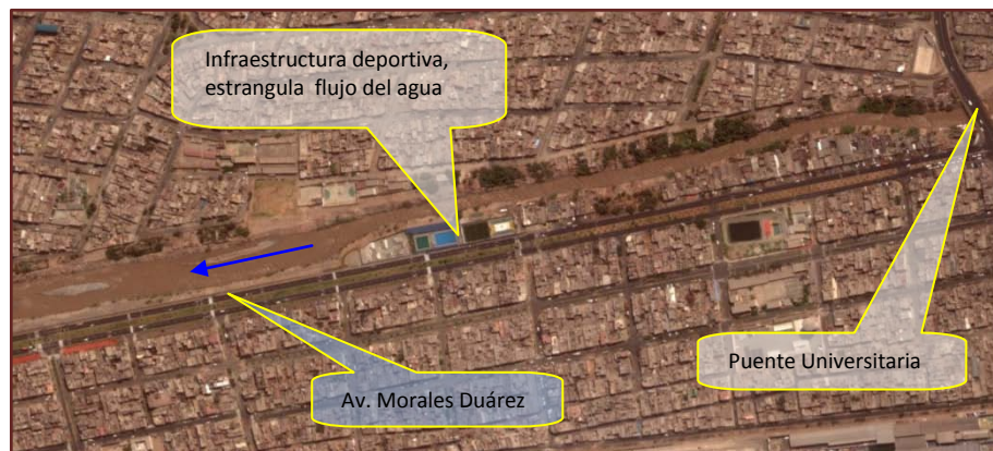
Figura 43. Infraestructura de servicio estrangula el flujo del agua
