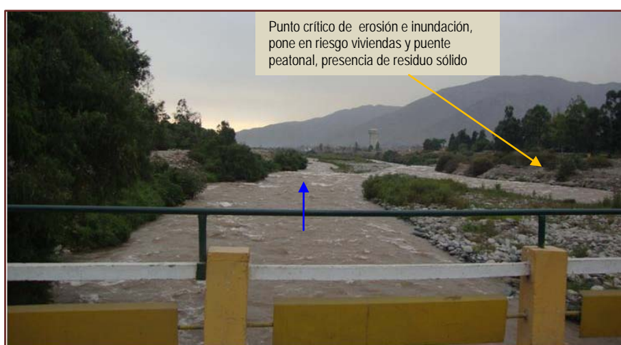
Figura 28. Material colmatado en el cauce del río, sector Huampaní
