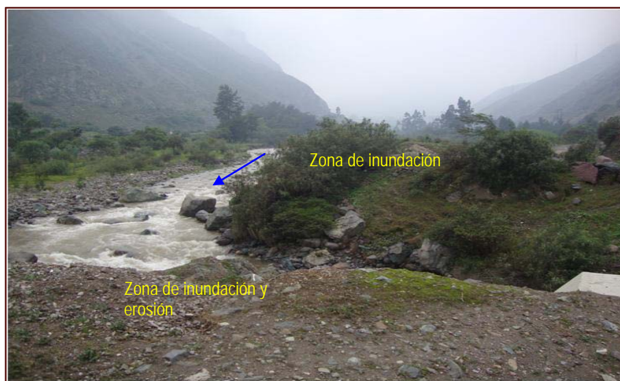
Figura 8. Riesgo por erosión e inundación de la carretera de Matucana a Surco y del puente Huariquiña
