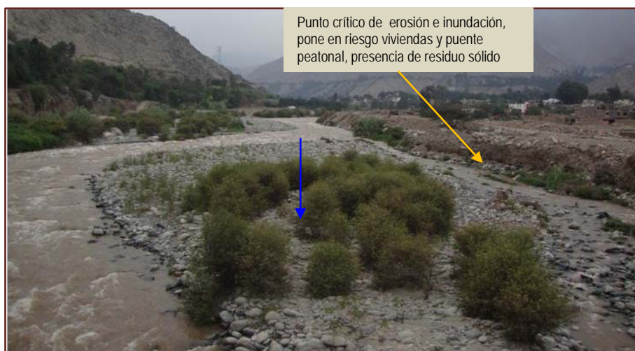
Figura 27. Se aprecia material colmatado en el cauce
