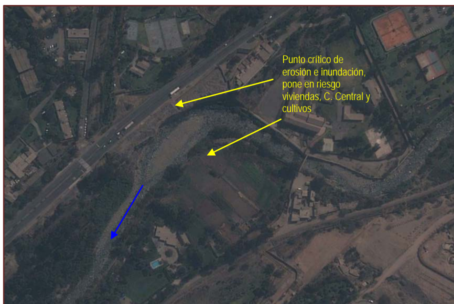
Figura 20. Riesgo por erosión margen derecha e inundación margen izquierda
