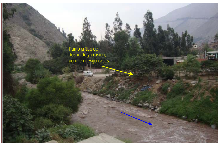
Figura 14. Viviendas expuestas a erosión e inundación
