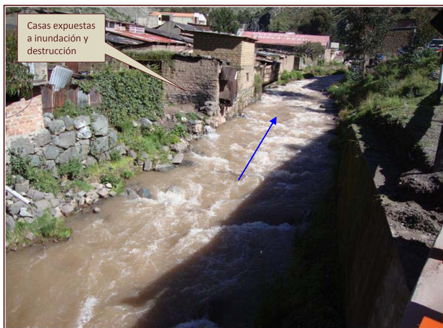
Figura 2. Casas en riesgo a inundación y destrucción
