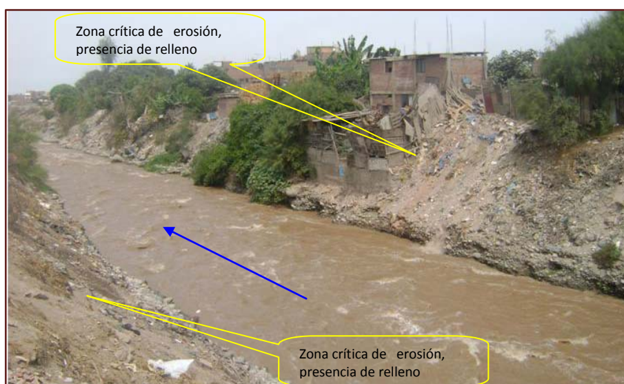
Figura 45. Aguas abajo del puente Universitaria
