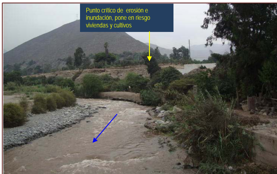
Figura 21. Riesgo por erosión e inundación, ambas márgenes
