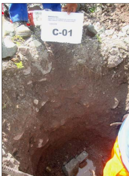
Figura 6. Excavación exploratoria C-1, se observan gravas con arenas y limos.
