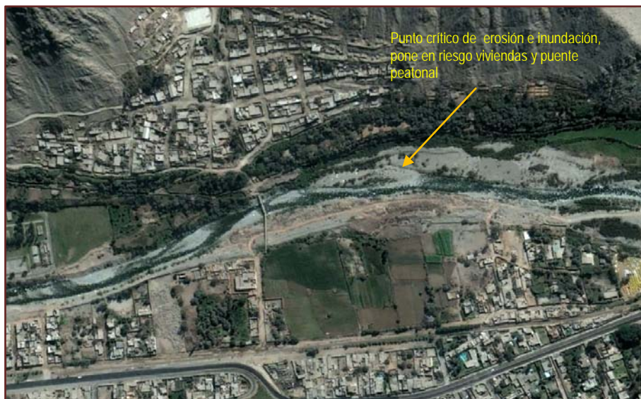
Figura 26. Riesgo de erosión margen derecha, inundación margen izquierda
