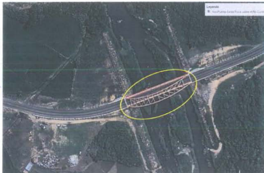
Figura 21. Existencia de estructuras de cruce (puente)
