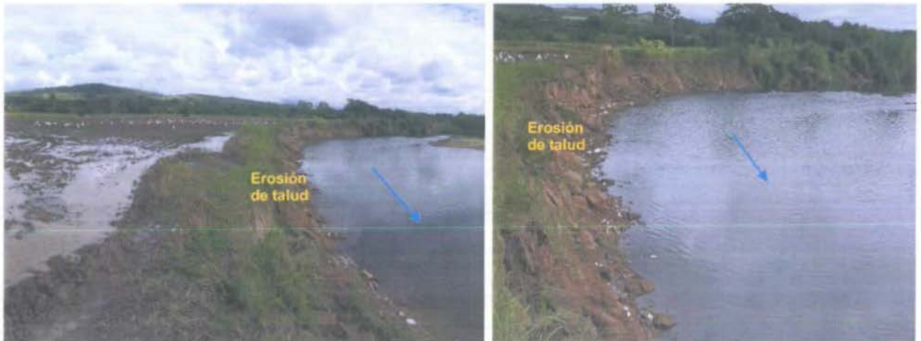
Figura 8. Erosión de ladera, pone en riesgo zona agrícola
