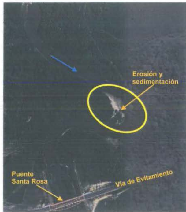
Figura 7. Inundación pone en riesgo área agrícola y vía de Evitamiento.
