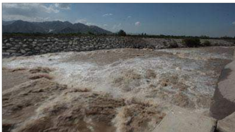
Figura 2. Desbordes del río Pativilca 2014
