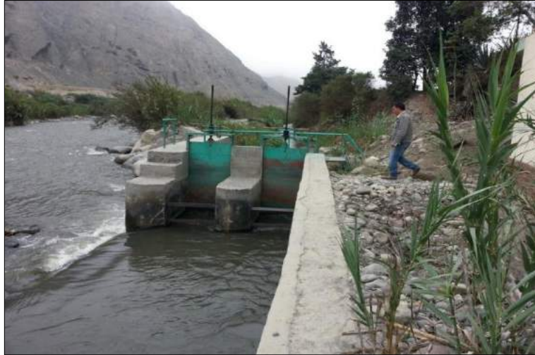
Figura 12. Estructura de captación
