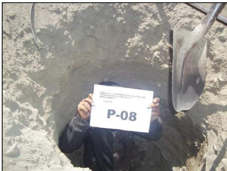
Figura 10. Excavación Exploratoria P-8 en el Sector Tres Cruces, los materiales granulares corresponden a Gravas arcillosas de clasificación SUCS GC
