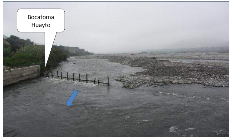
Figura 10. Punto crítico 10 y 11, sector bocatoma Huayto
