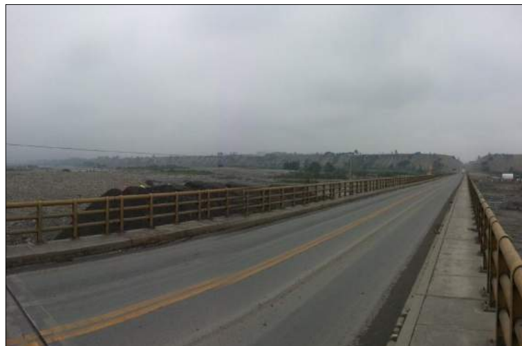
Figura 14. Puente vehicular sobre el río Pativilca
