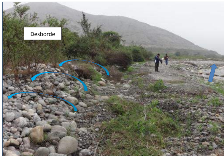
Figura 14. Punto crítico 15, sector Fundo Rosales
