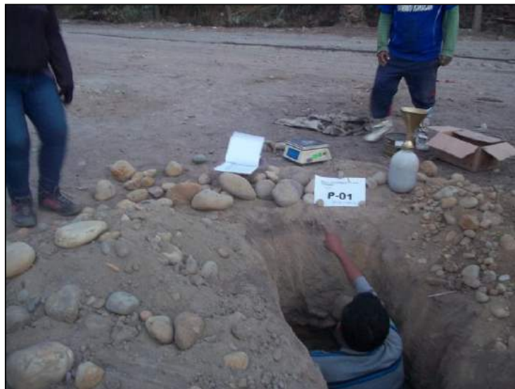
Figura 3. Excavación Exploratoria P-1 en el Sector Vinto, los materiales granulares corresponden a Gravas bien gradadas de clasificación SUCS GW
