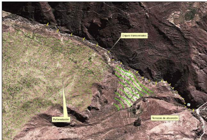
Figura 8. Obras de control y conservación de suelos
