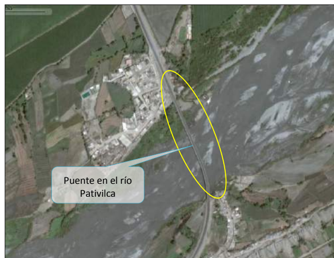
Figura 7. Existencia de estructuras de cruce (puente), condicionan la delimitación del eje
