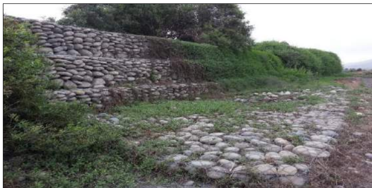
Figura 9. Dique longitudinal de gaviones
