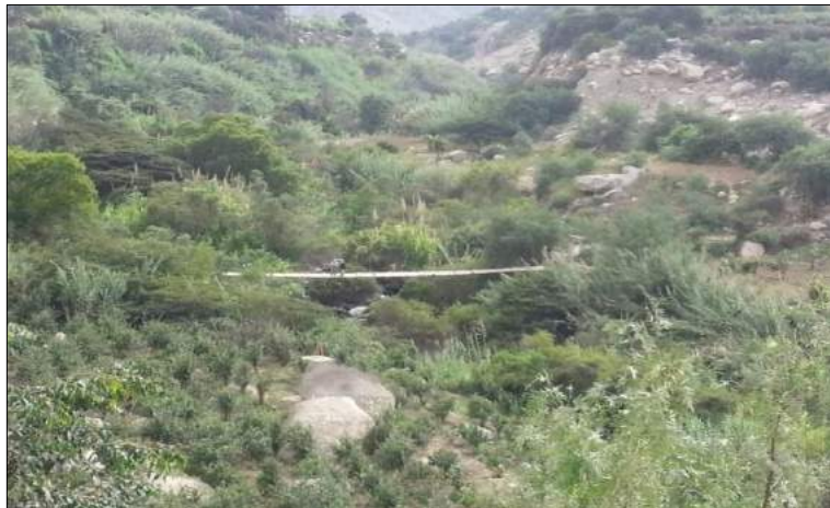
Figura 13. Puente colgante sobre el río Ocos
