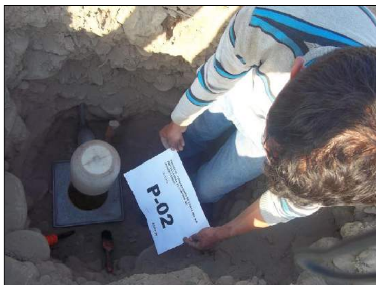
Figura 4. Excavación Exploratoria P-2 en el Sector Potao, los materiales granulares corresponden a Arenas Limosas de clasificación SUCS SM
