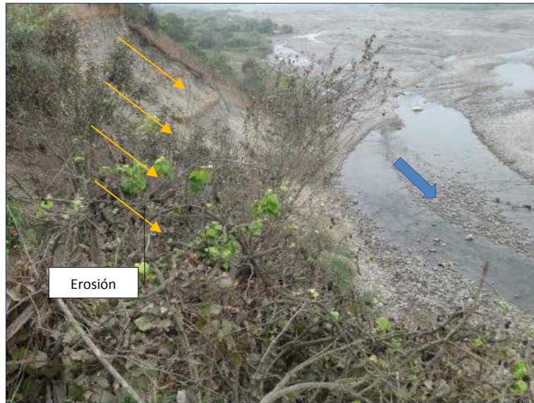
Figura 6. Punto crítico 06, sector Carretería
