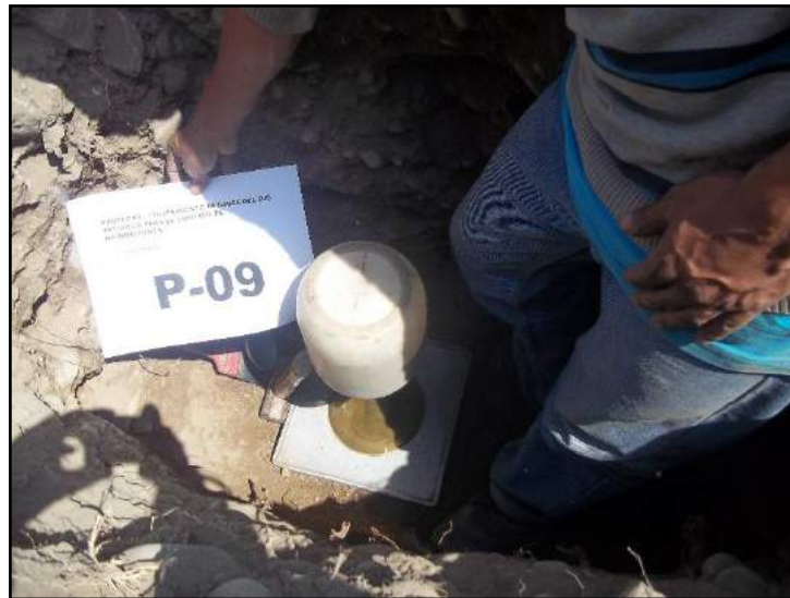
Figura 11. Excavación Exploratoria P-9 en el Sector Torrecilla Alta, los materiales granulares corresponden a Gravas arcillosas de clasificación SUCS GM, se observa el ensayo de densidad in situ
