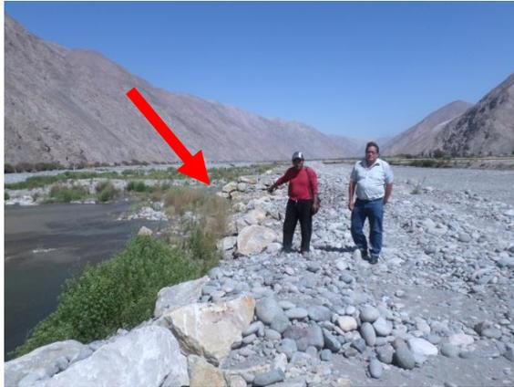
En la vista fotográfica se puede ver los espigones cortos contruidos de roca ciclópea y perpendiculares al eje del río, estos espigones no cuentan con uña antisocavantes se han sido colocados encima del material sedimentado.
