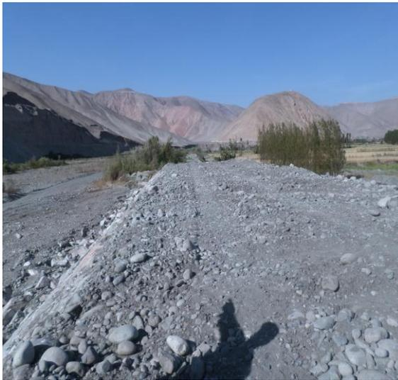
guardan un alineamiento acorde a la forma del cauce, no conservan el ancho estable del río, el talud, enrocado y uña de socavación no conservan una inclinación adecuada, el enrocado ha sido colocado al volteo y en la mayor longitud de los diques en la cara húmeda cuenta sin roca y la altura de socavación no se ha diseñado acorde al caudal máximo y en la mayor de los casos no cuentan con roca. Como se puede visualizar en la presente imagen.
