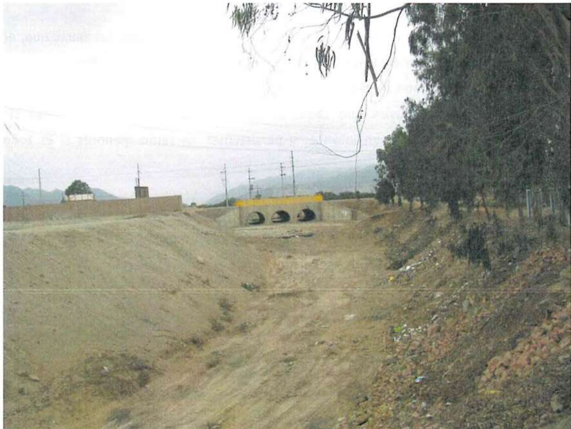
Fot.2.04. Cruce, con un puente alcantarilla, del cauce norte – Pucusana con la Autopista Panamericana Sur.
