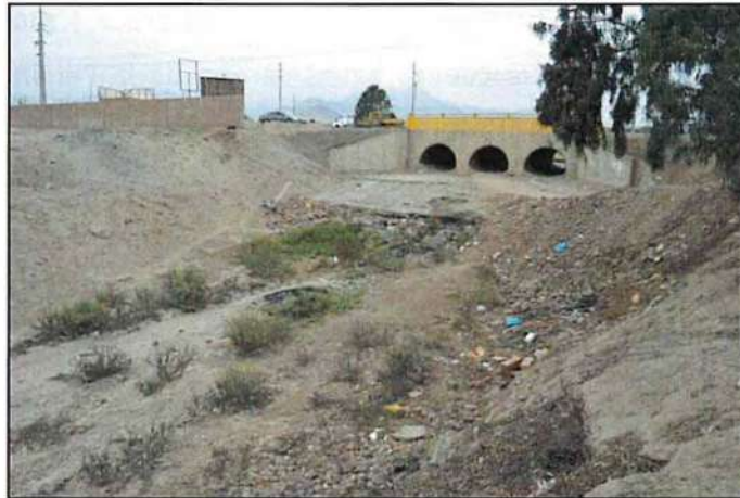
F-3.07. Alcantarillas de carriles que van de Norte a Sur.
