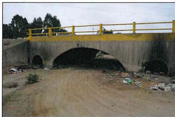
F-3.06. Alcantarillas de cruce en los carriles que van de S a N.
