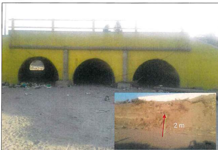
Fotografía N° 1: Características de la Alcantarilla del rio Chilca en el Ramal Sur.
