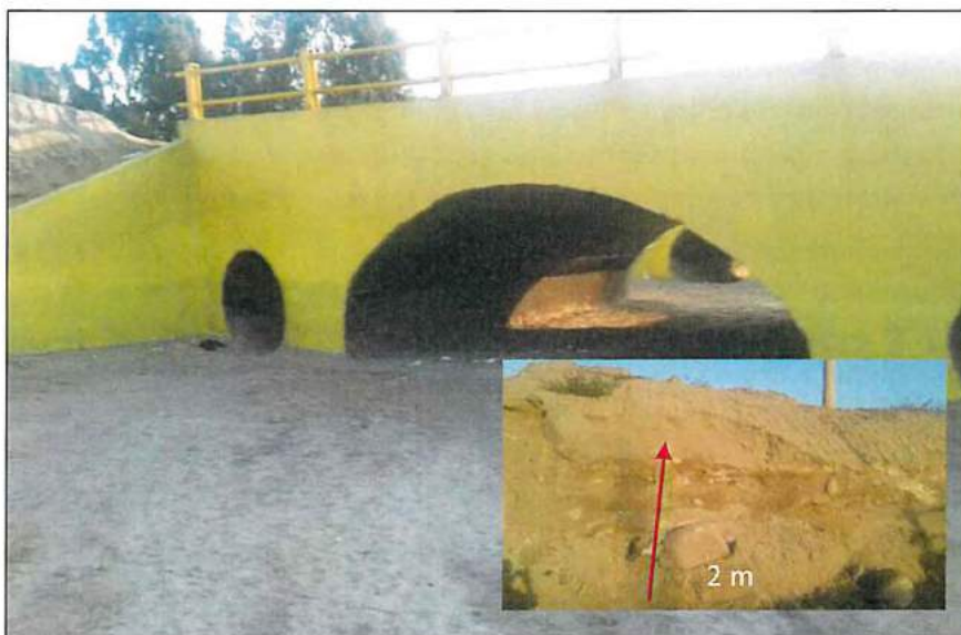
Fotografía N° 2: Características de la Alcantarilla del rio Chilca en el Ramal Norte.
