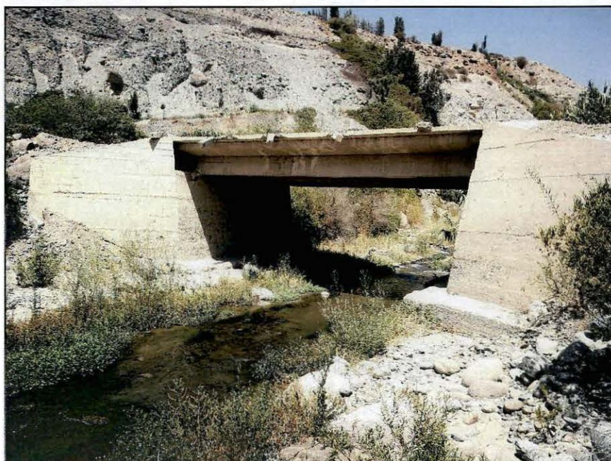
IMAGEN 4.4.1.2 PROGRESIVA: 0+518.22; COORDENADAS E= 770043.993, N= 8229414.299
