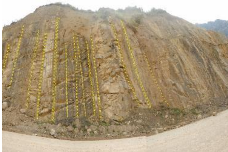
Figura 5. Vista donde se observa un intercalación de areniscas con limoarcillitas, ubicado entre las coordenadas UTM 8818839 N,308081 E, altitud de 3624 m s.n.m.
