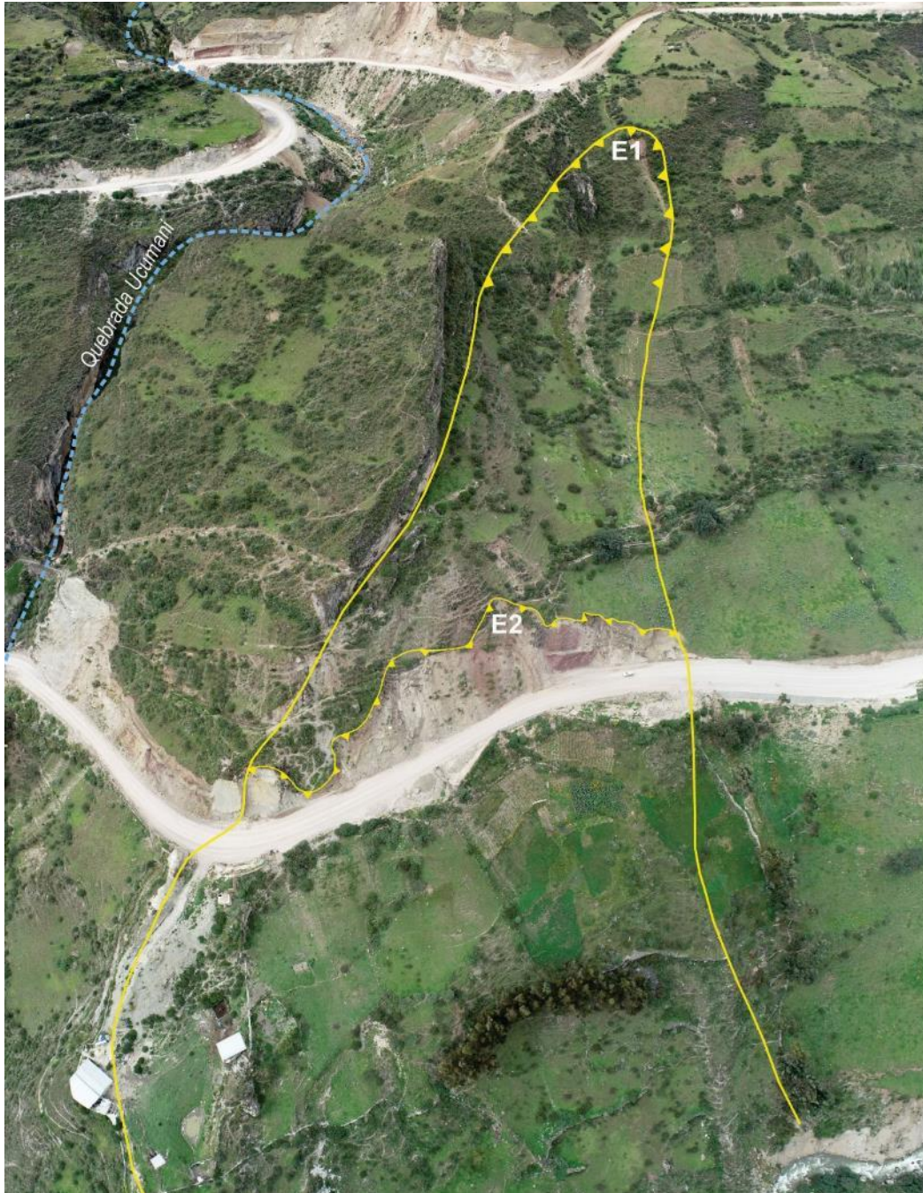
Figura 15. Vista del deslizamiento de Pucallpa, con escarpas sucesivas: E1 y E2.
