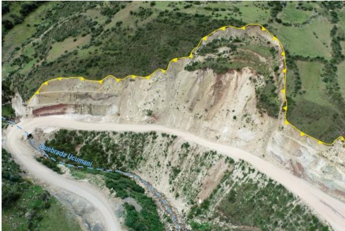
Figura 19. Vista del deslizamiento rotacional (E3) (delimitado con línea amarilla), margen izquierda de la quebrada Ucumani, en ladera de pendiente muy fuerte (25° a 45°).
