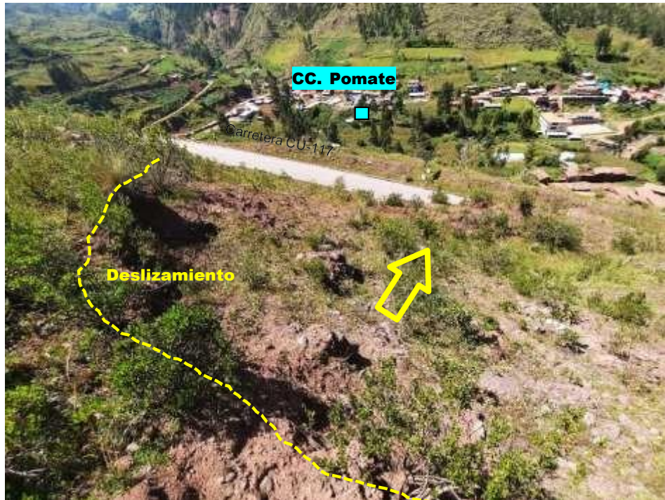
Fotografía 3: Depósitos coluviales formados por la activación de deslizamientos después del corte de carretera departamental, parte alta de la comunidad de Pomate.
