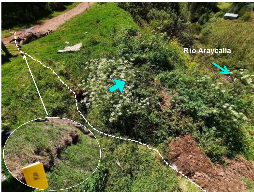
Fotografía 11. Saltos de 20 cm en el flanco derecho del derrumbe reactivado (lado derecho del deslizamiento reactivado).
