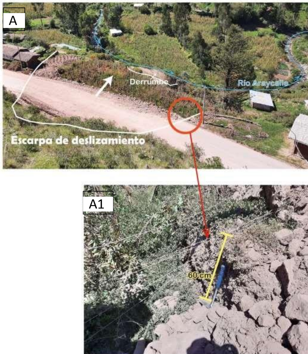
Figura 7. A. Vista de la parte alta de la escarpa principal de un deslizamiento en proceso de activación y daños en la infraestructura. B. Sectores cercanos a la carretera CU-117, donde no se colocó material de relleno muestran santos hasta de 60 cm.
