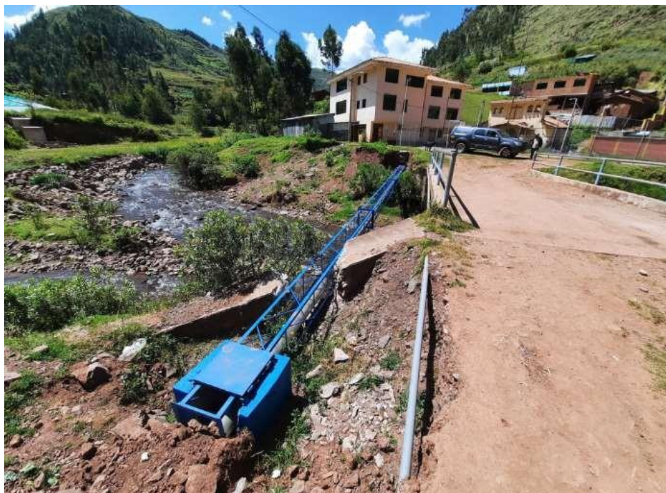
Fotografía 5. Depósitos aluviales a ambos flancos del río Araycalla..
