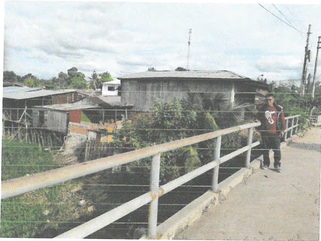
Foto N.º 9, casas de madera de 1 piso con techos de calaminas.
