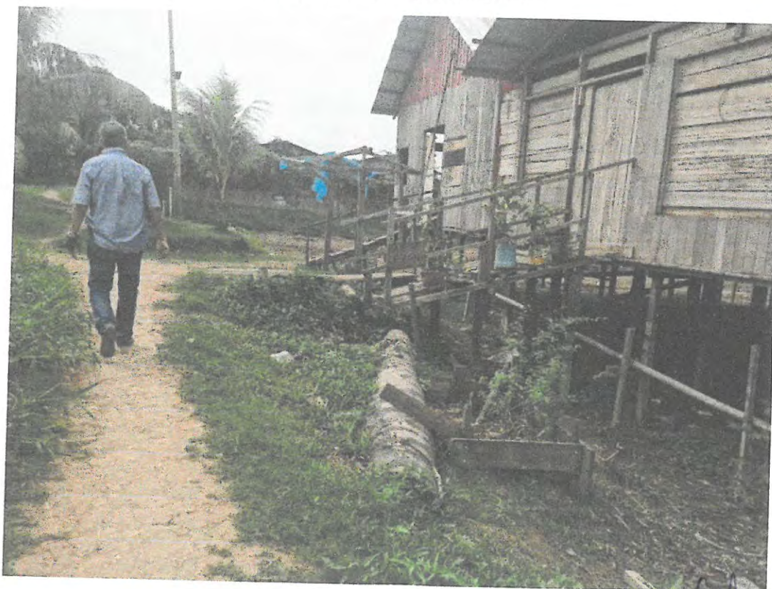
Foto N.º 32, casas de madera de 1 piso con techos de calaminas.
