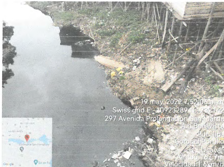
Foto N.º 64, casas de madera de 1 piso con techo de calaminas y residuos orgánicos e inorgánicos alrededor de la quebrada.
