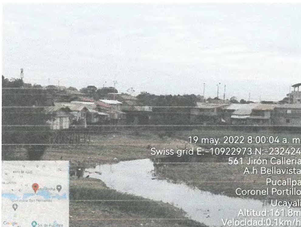
Foto N.º 66, casas de madera de 1 piso con techo de calaminas y residuos orgánicos e inorgánicos alrededor de la quebrada.
