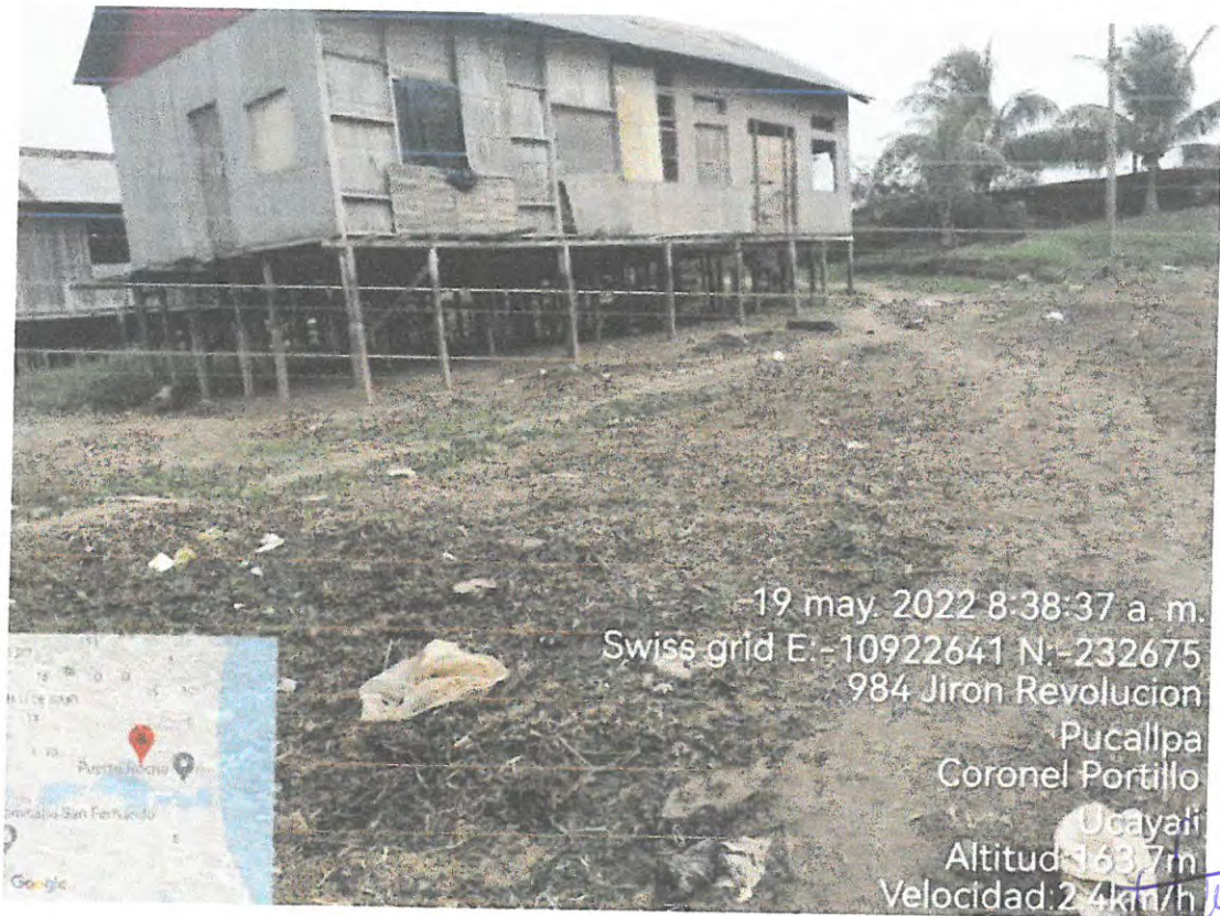
Foto N.° 54, casas de madera de 1 piso con techo de calaminas.
