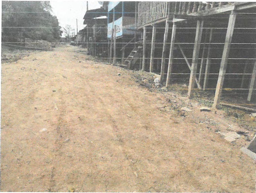
Foto N.º 33, casas de madera de 1 piso con techos de calaminas.
