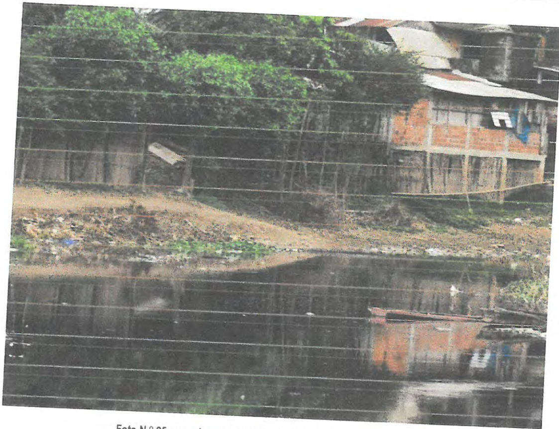
Foto N.º 25, casa de material noble de 1 piso con techo de calamina.
