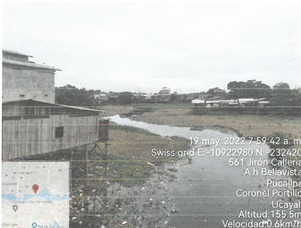
Foto N.º 65, casas de madera de 1 piso con techo de calaminas y residuos orgánicos e inorgánicos alrededor de la quebrada.
