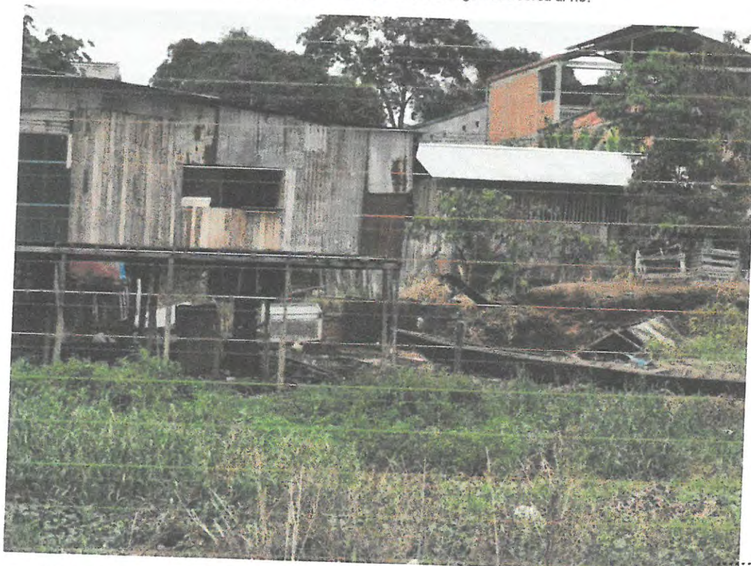
Foto N.º 24, casa de madera de 1 piso con techos de calaminas y una casa de 2 pisos de material noble.
