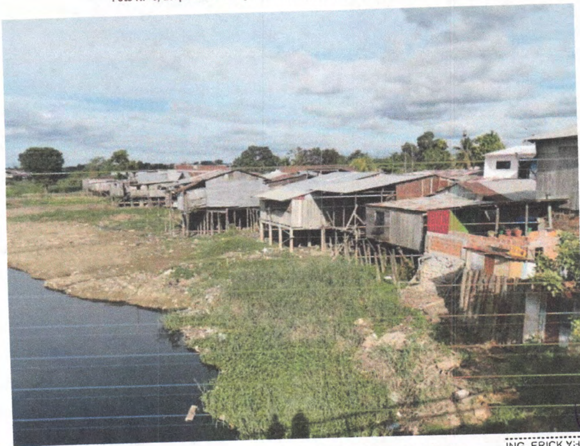
Foto N.º 6, casas de madera y casas de material noble con techos de calaminas.
