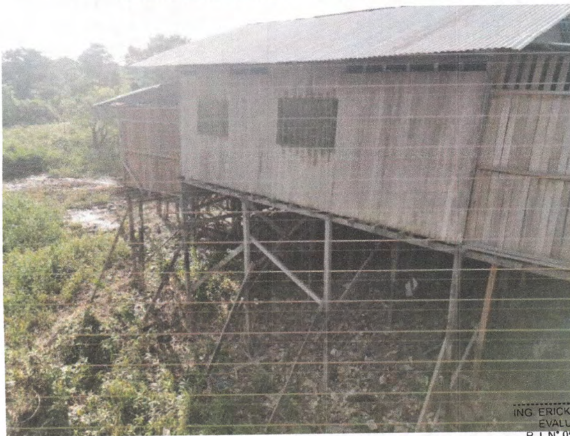
Foto N.º 4, casa de madera de un piso con techo de calamina.
