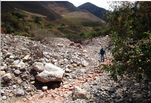
En esta columna de fotografías se muestran las evidencias de la afectación del cauce de la Qda La Lucma y sus bienes asociados a causa de la acumulación de material que ha sido arrastrado de la parte alta en el periodo de lluvias; cauce totalmente colmatado de material, puente carrozable colapsado y carretera C.P El Limón - La Lucma bloqueada.
