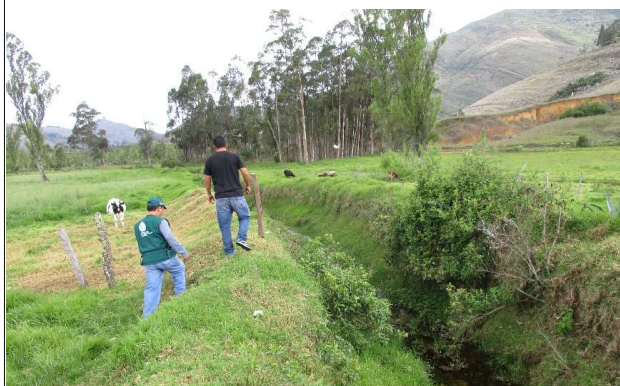
En esta columna de fotografías se aprecian los diferentes tramos del lecho del río Chaquíl - Sucre colmatados por la acumulación de material arrastrado de la parte alta, esto ocurre cada periodo lluvioso. Es necesario realizar la descolmatación del río en toda su longitud ya que constituye un peligro de inundación de las zonas circundantes.
