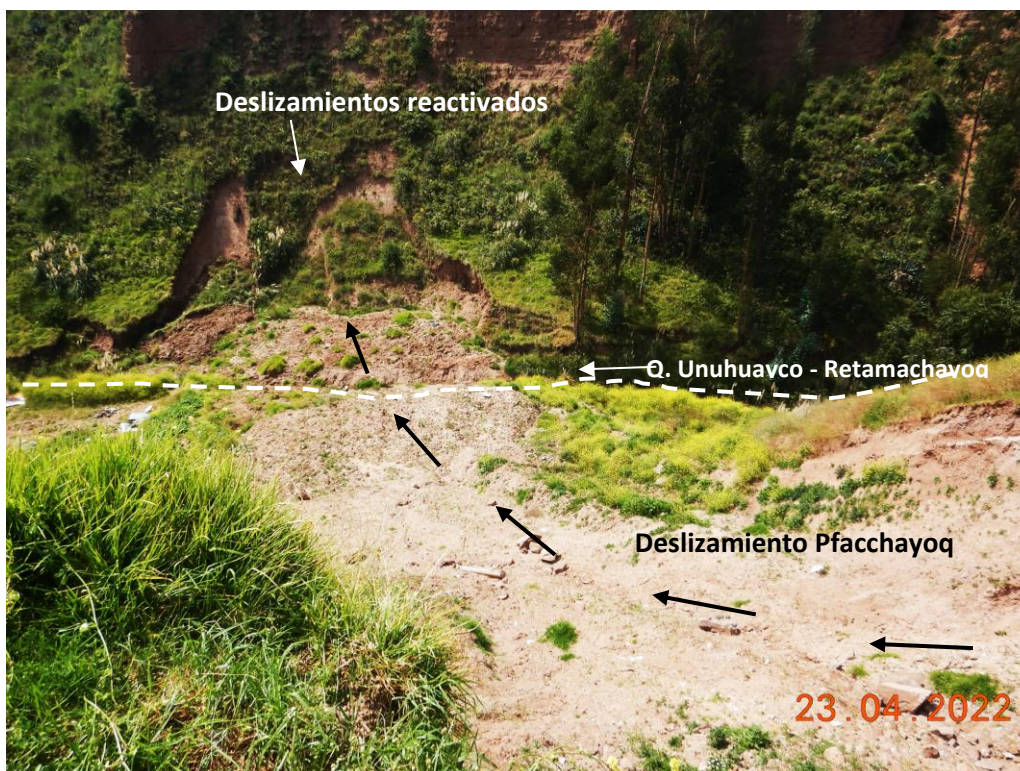
Fotografía 8: La masa desplazada del deslizamiento Pfacchayoq llegó a la margen derecha de la quebrada Unuhuayco – Retamachayoq, cubriendo su cauce y reactivando deslizamientos.
