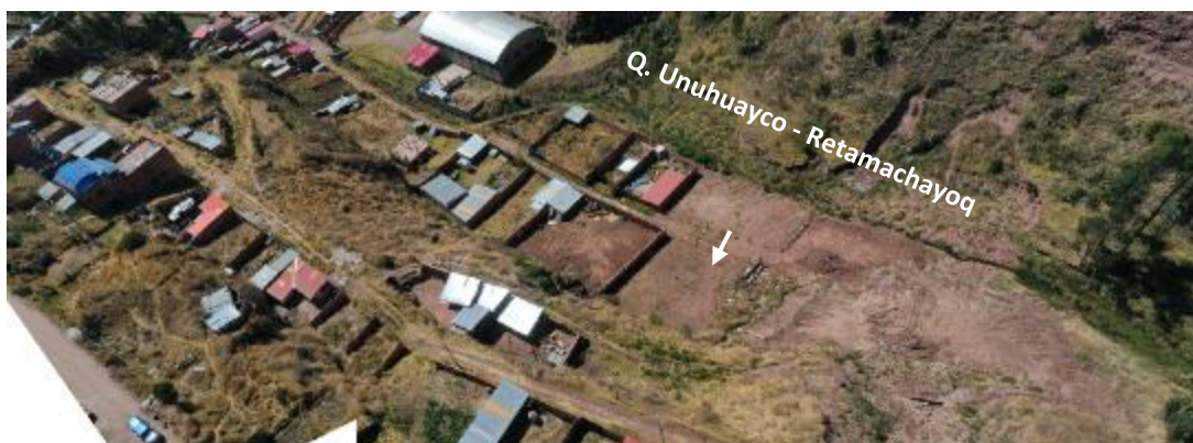
Fotografía 10: Viviendas ubicadas en el cauce de la quebrada Unhuayco – Retamachayoq
