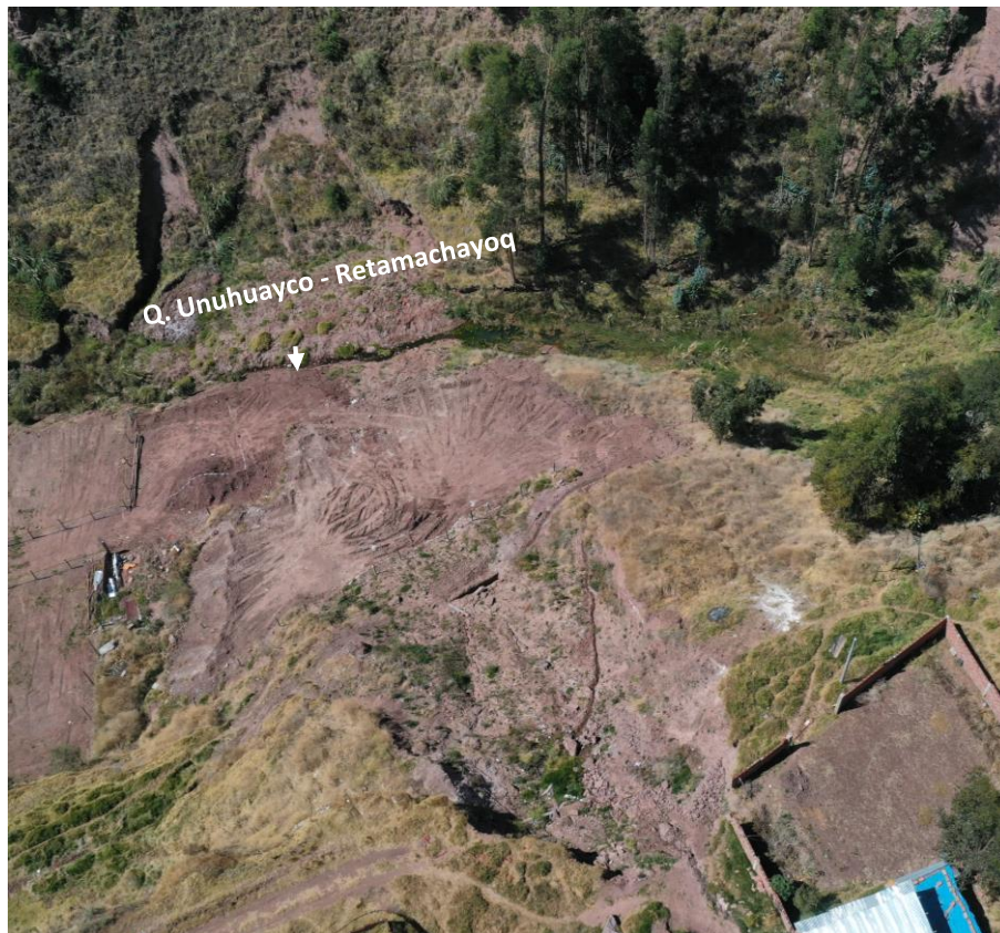
Fotografía 9: Trabajos de limpieza de la masa desplazada del deslizamiento Pfacchayoq, al pie del talud
