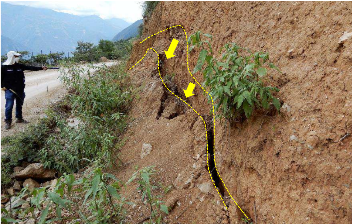
Figura 8. En talud superior de carretera se observa el desplazamiento vertical del deslizamiento en proceso de formación.
