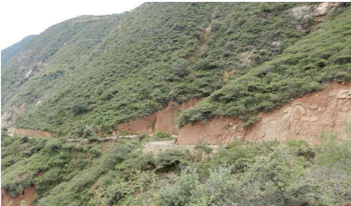
Fotografía 2. Vista panorámica del depósito coluvideluvial cubriendo el macizo rocoso sedimentario del área de evaluación
