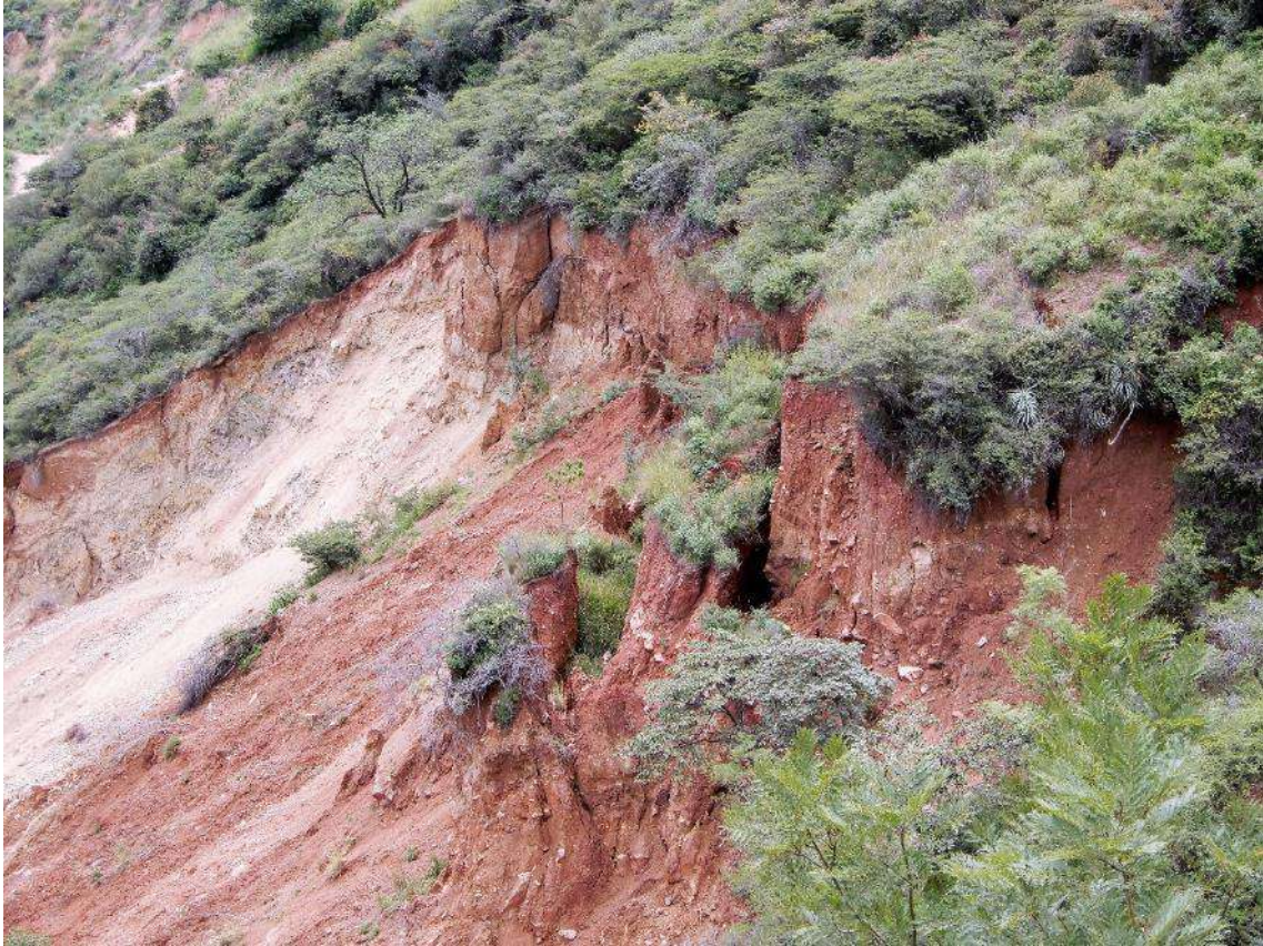
Fotografía 7. Escarpa principal de derrumbe en proceso retrogresivo ubicado en el talud inferior de la carretera del área de evaluación. Coordenadas UTM: 211319.73 / 9134591.89, zona 18.
