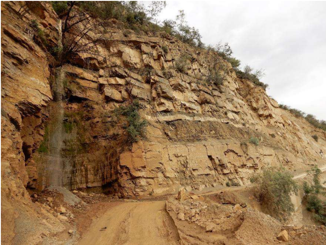
Fotografía 5. Talud rocoso sedimentario con estructura fracturada, vista rumbo a Pataz. Coordenadas UTM: 211239.76/ 9134919.61, zona 18.
