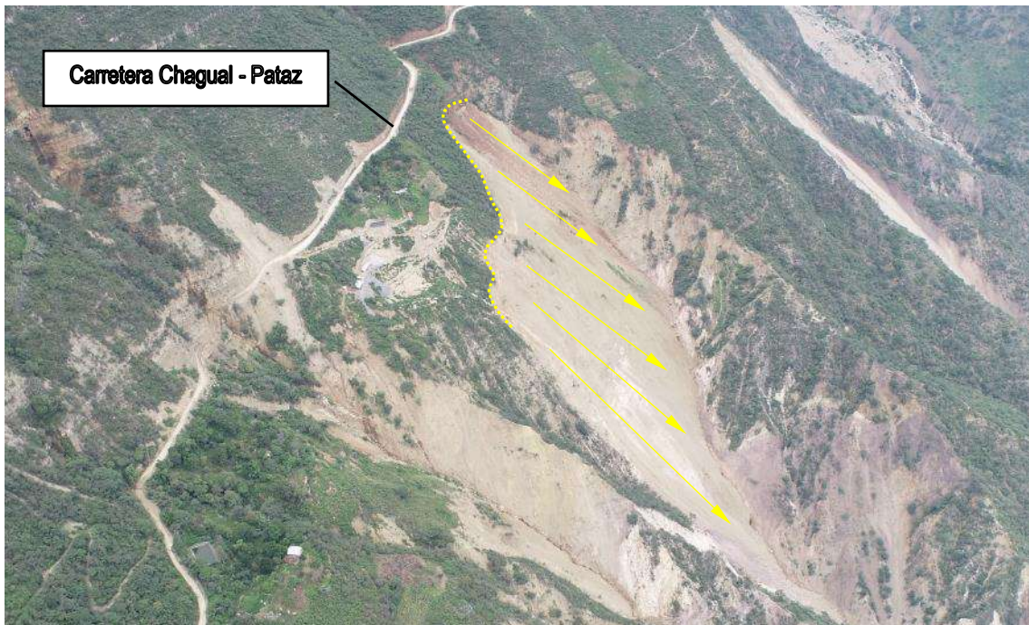
Figura 6. Vista panorámica del derrumbe principal ubicado en el talud inferior de la carretera del área de evaluación.
