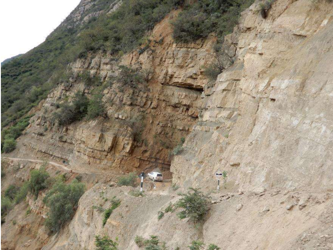
Fotografía 6. Talud rocoso sedimentario con estructura fracturada, vista rumbo a Chagual. Coordenadas UTM: 211239.76/ 9134919.61, zona 18.
