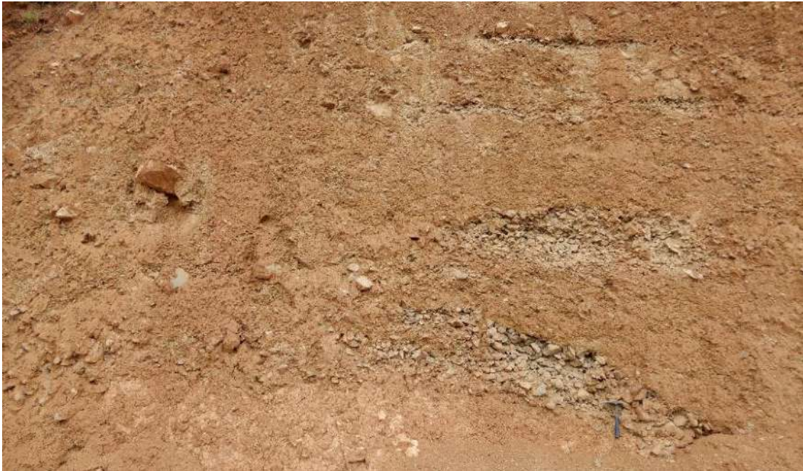
Fotografía 1. Vista del material coluvideluvial en talud superior de la carretera del área de evaluación. Coordenadas UTM: 211472.20/9134491.34, zona 18.
