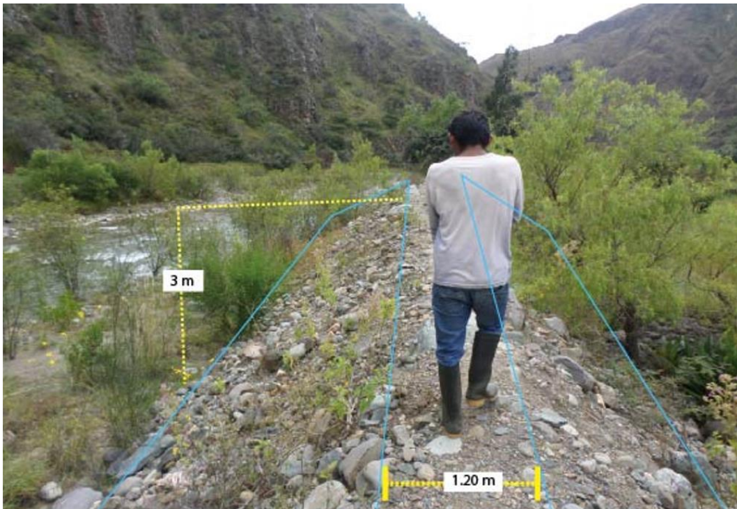
Figura 16. Muro (Arrimado del material), ubicado en la margen derecha del río Huertas, tiene una altura de 3 m, ancho de 1.20 m y 200 m de longitud.
