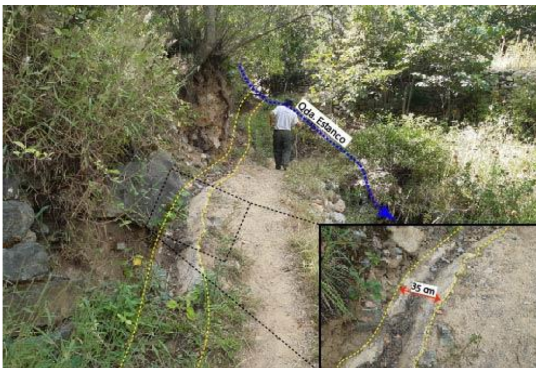
Figura 19. Vista de un canal de regadío con ancho de 35 cm, donde desvían el agua proveniente de quebrada, para el riego de los terrenos de cultivos de árboles flutales.
