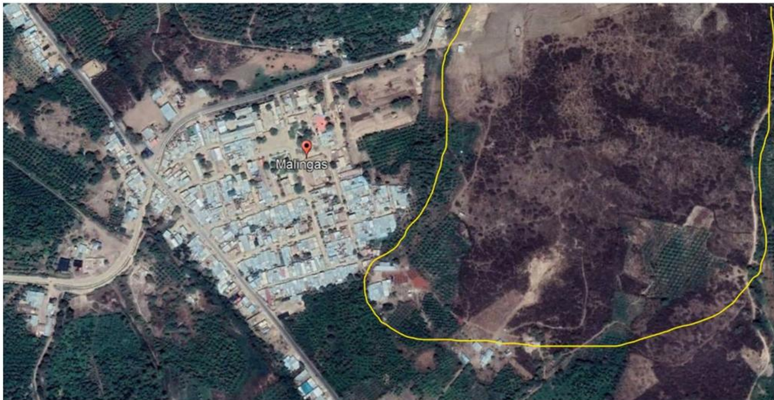
Figura 13.- Colina (polígono amarillo) ubicada en el extremo sureste de la plaza del C.P. Malingas
