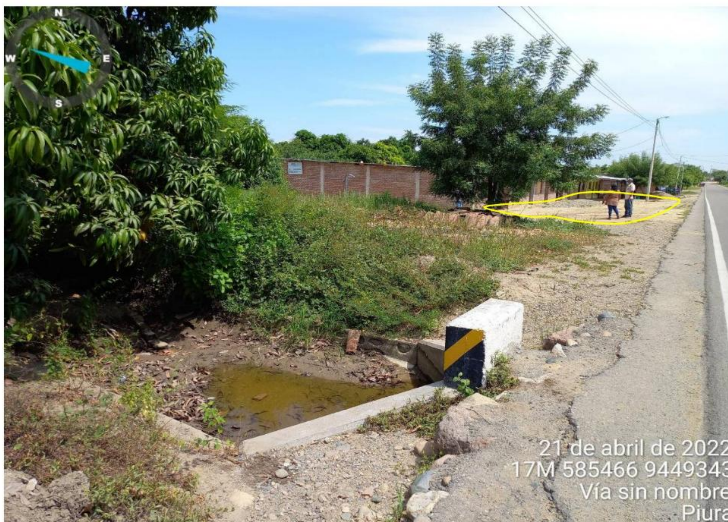
Figura 24.- Áreas susceptibles (polígono amarillo) a inundaciones pluviales debido que las viviendas se encuentran en un desnivel topográfico inferior a la carretera Malingas – Chulucanas, durante el periodo de lluvias (enero – marzo)
