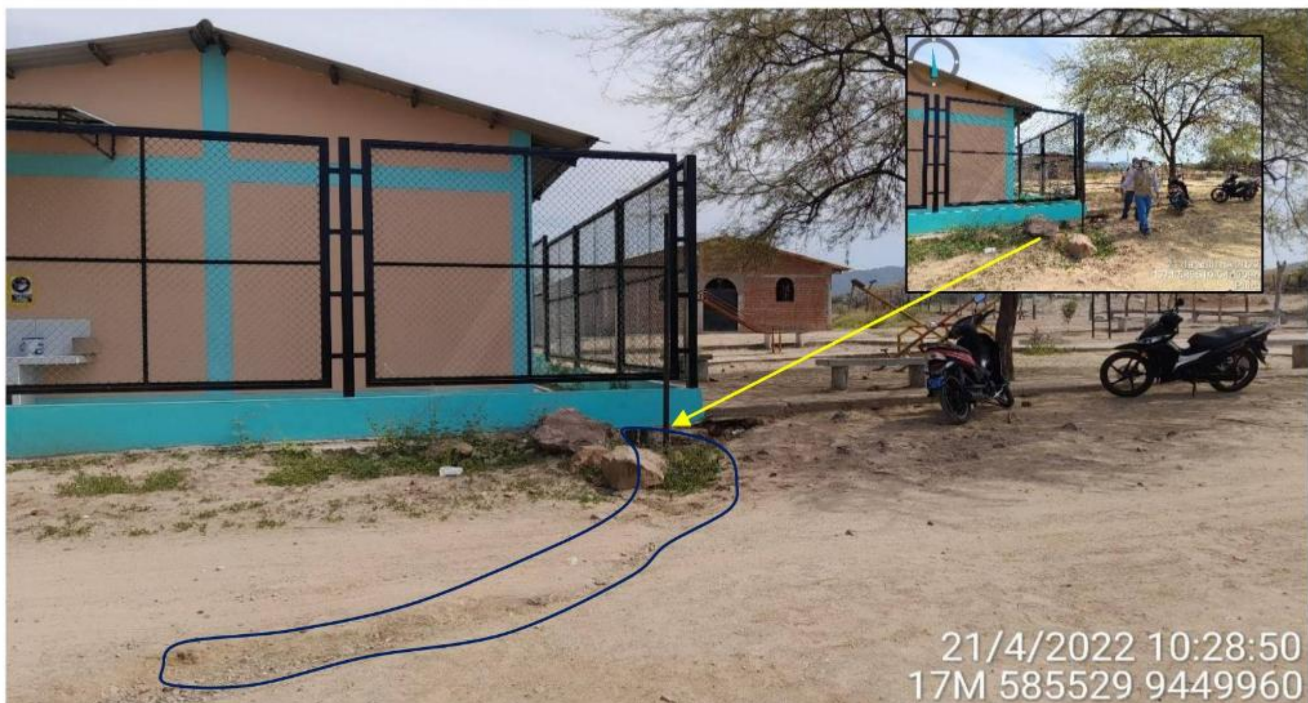
Figura 23.- Áreas afectadas (polígono azul) por inundaciones pluviales debido a la evacuación de las aguas pluviales hacia la calle que podría afectar la vía y viviendas contiguas
