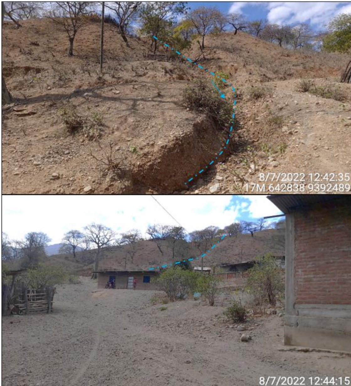
Figura 17.- Ante la ocurrencia de lluvias intensas, las quebradas situadas en el extremo oriental de las instituciones educativas podrían activarse, generando flujos de lodos que podrían afectar viviendas ubicadas aguas abajo. En la imagen superior se muestra cauce de quebrada y la imagen inferior una vivienda contigua a su cauce
