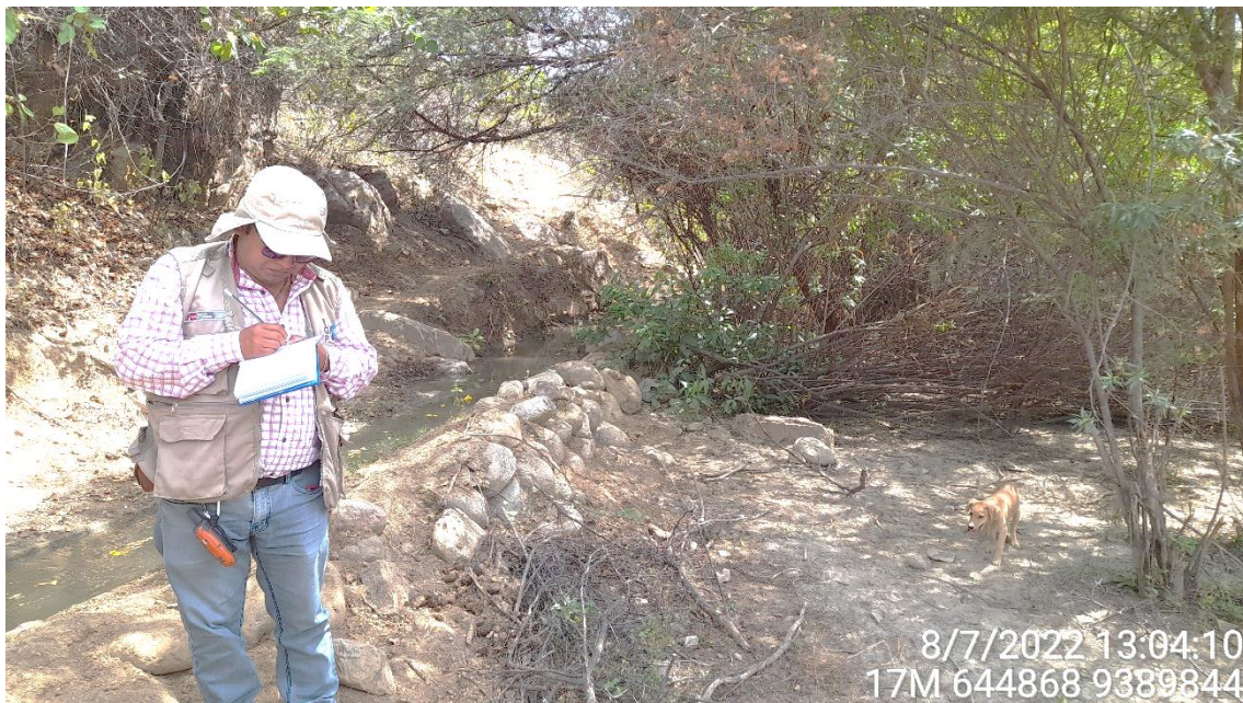
Figura 24.- Canal de irrigación Hualcas ubicado en la cota 319 m.s.n.m que tiene aproximadamente 3 km de longitud y cuya bocatoma es afectada ante el incremento del caudal del río Huarmaca
