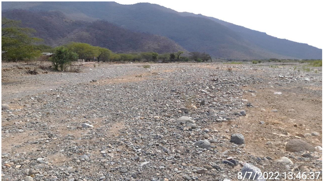
Figura 11.- Cauce o lecho fluvial del río Huarmaca en cuyo margen izquierdo se ubica el caserío Hualcas, el desnivel topográfico entre el río y la zona urbana es de aproximadamente 1 – 2 m
