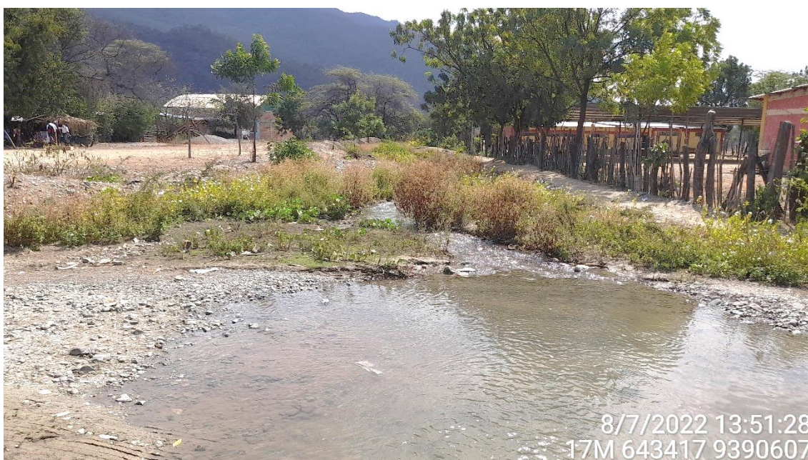
Figura 26.- Canal de irrigación ubicado en el extremo norte de la Institución Educativa José María Eguren que en época de máximas avenidas incrementa su caudal y se desborda en las inmediaciones de a cota 303 m.s.n.m
