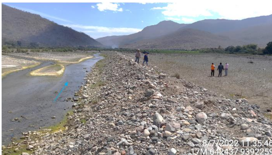
Figura 4.- Lecho fluvial del río Huarmaca y dique precario (materiales conformados) en el margen derecho como medida de protección ante inundaciones. De acuerdo a la estación hidrométrica Malacasi (ubicada a 24 km al norte del caserío Mamayaco) durante el periodo 1972 – 1992 se registró un caudal máximo de lluvias de 214 m 3 /s, mientras que, el caudal promedio de la imagen se estima en 2m 3 /s.
