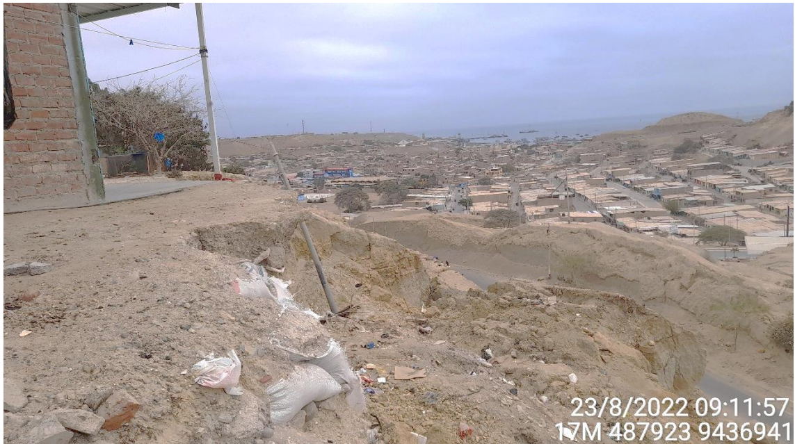
Figura 16.- Vivienda y poste de energía eléctrica ubicados en la parte alta de la ladera que han sido afectados por ocurrencia de la caída de rocas en el A.H. Vista al Mar
