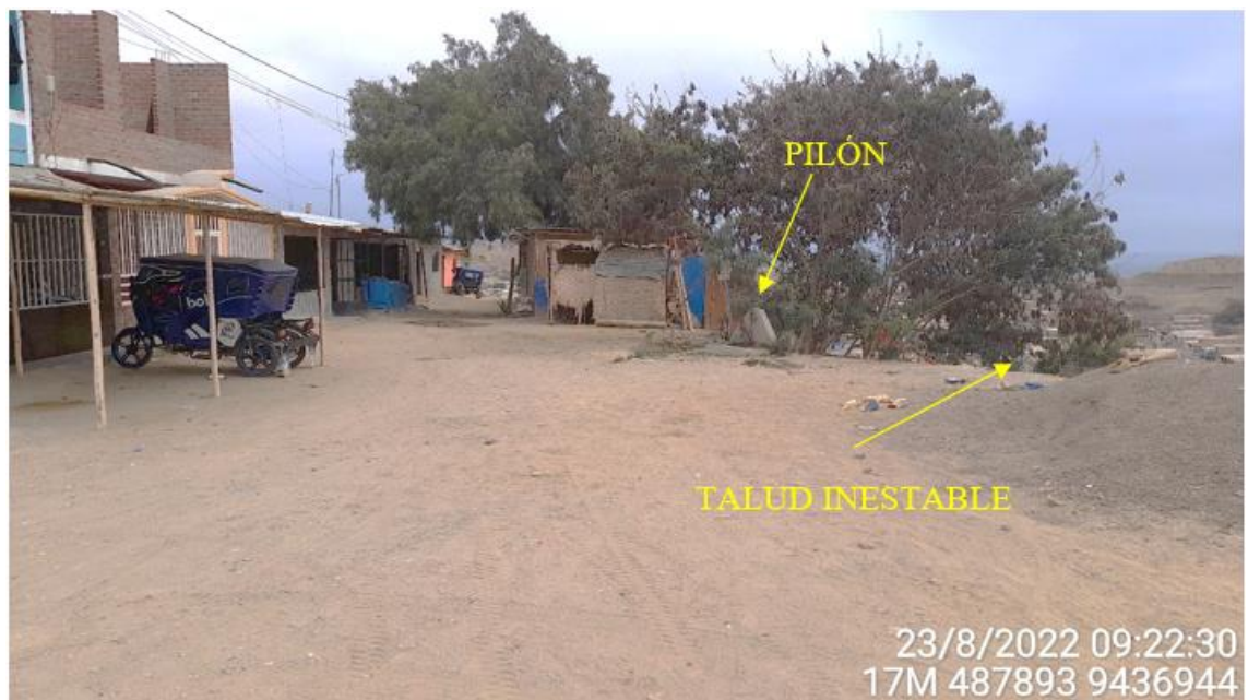
Figura 17.- Ubicación de pilón de agua para consumo humano en el A.H. Vista al mar en el borde del talud que contribuye con la infiltración del agua hacia el subsuelo y generación
