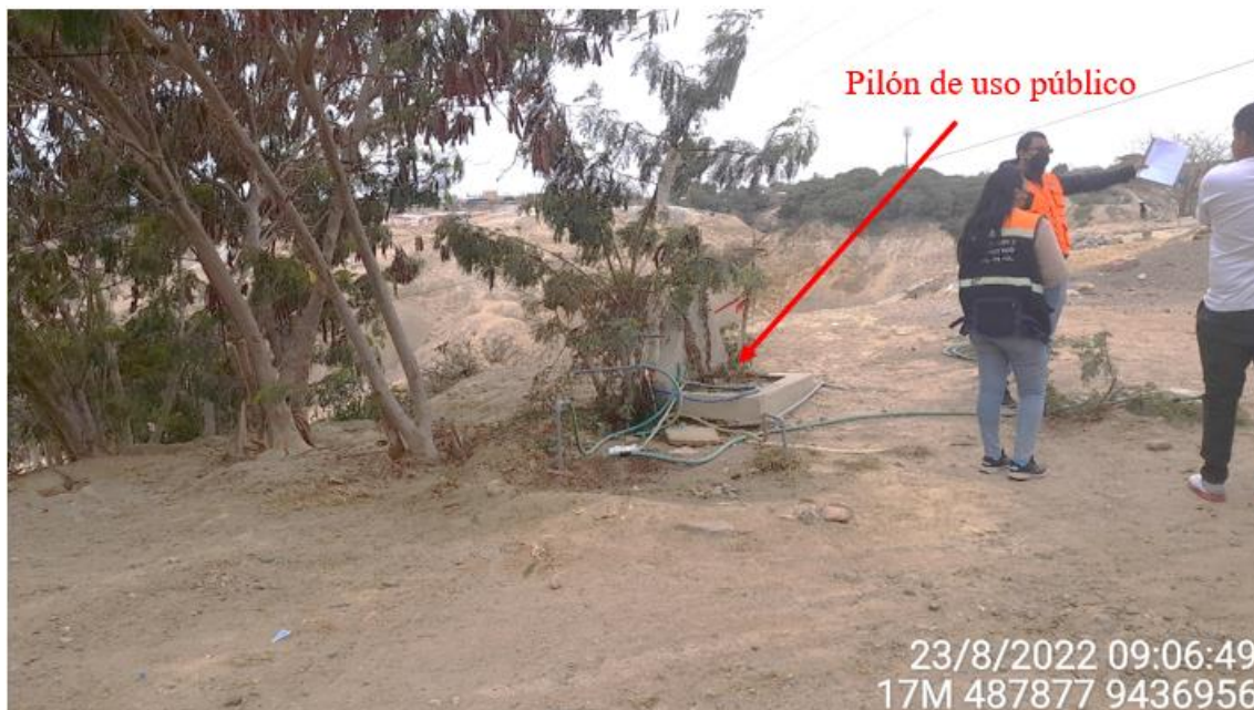
Figura 18.- Pílon empleado para el abastecimiento de agua que cuenta con mangueras e instalaciones que permiten la fuga del agua, contribuyendo a la saturación del suelo ubicado en la parte alta de la ladera afectada por el fenómeno caída de rocas
