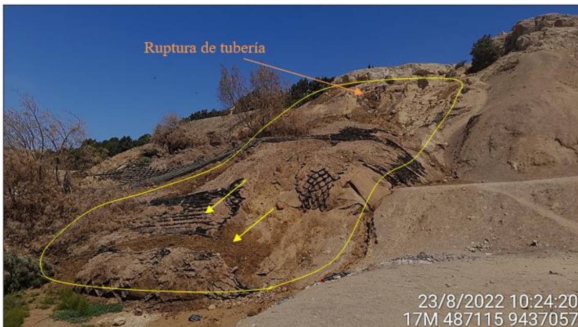
Figura 21.- Deslizamiento (polígono amarillo) generado en el cerro Llorón producto del colapso de tubería y buzón que evacuaban agua hacia red de saneamiento principal del distrito de Paíta
