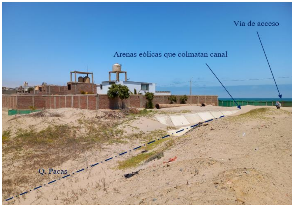
Figura 27.- Recorrido de la quebrada Pacas que en las inmediaciones de la zona urbana del balneario Los Cangrejos ha sido encauzado mediante la conformación de un canal con lozas de concreto. La desembocadura de dicho canal ha sido obstruida durante la conformación de la vía de acceso a Playa Cangrejos y se encuentra colmatada con arenas eólicas
