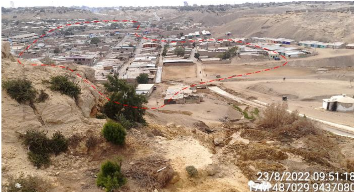
Figura 5.- Terraza marina (polígono rojo) sobre la que se asienta la zona urbana de Paita baja
