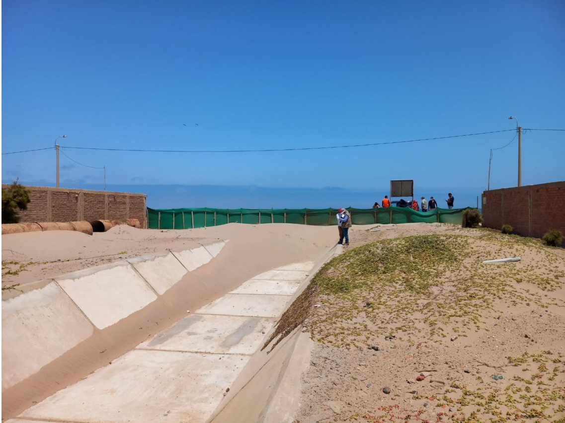
Figura 29.- Arenas eólicas que invaden canal de drenaje que conduce aguas pluviales hacia el mar
