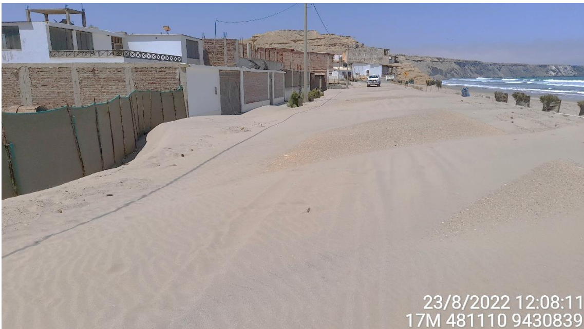
Figura 30.- Arenas eólicas sobre la vía afirmada de acceso a Playa Cangrejos
