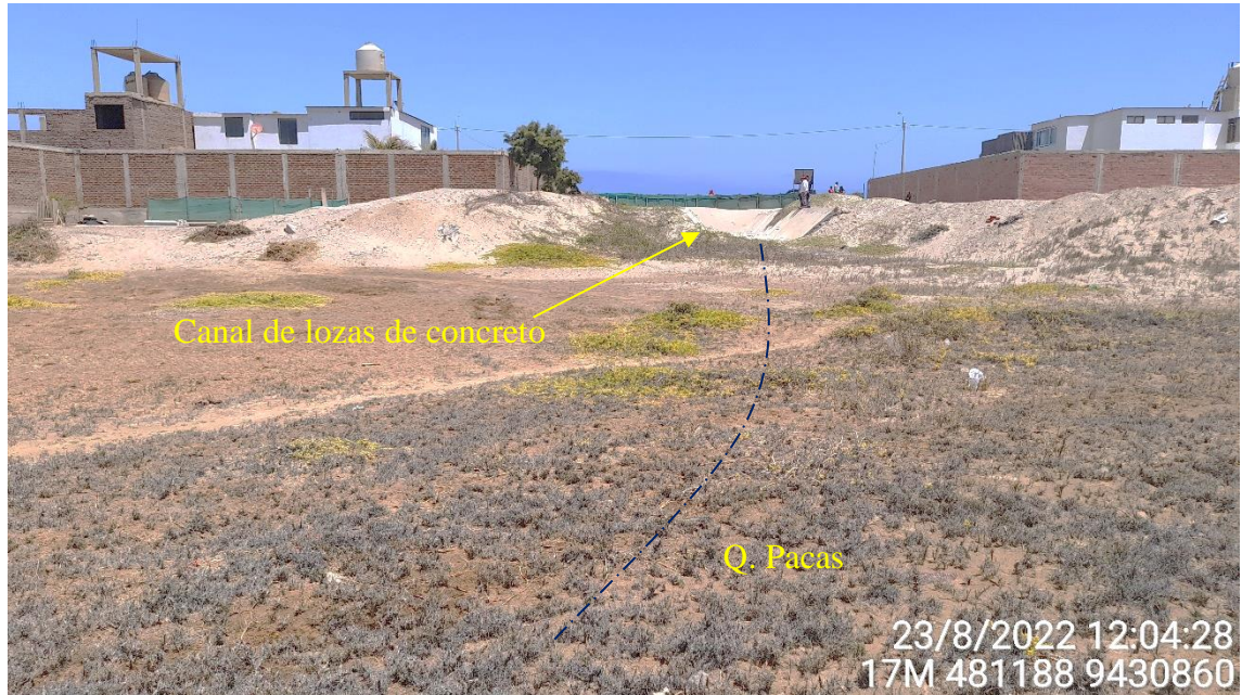
Figura 26.- Recorrido de la quebrada Pacas en las inmediaciones de Playa Cangrejos que discurre hacia canal conformado con lozas de concreto y posteriormente al mar, sin embargo, dicho canal se encuentra colmatado por arenas eólicas
