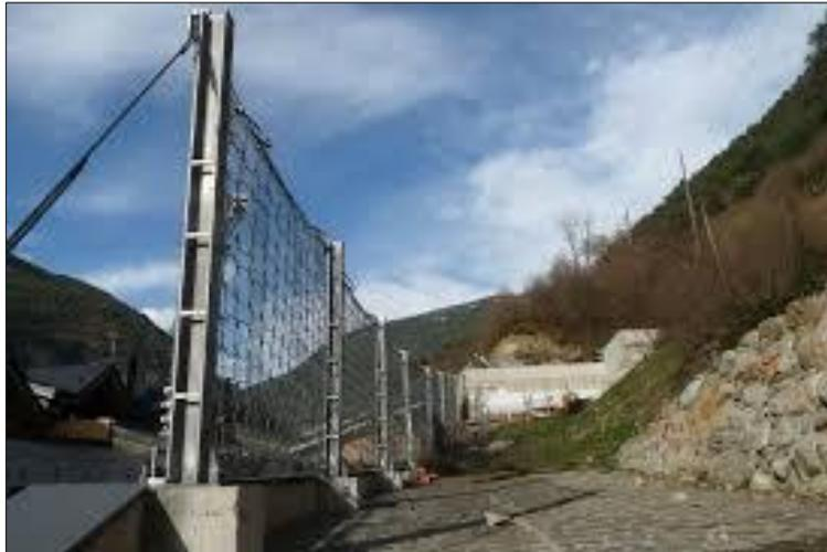
**Figura 95.** Ejemplo de barrera estática construida para protección de caída de rocas
