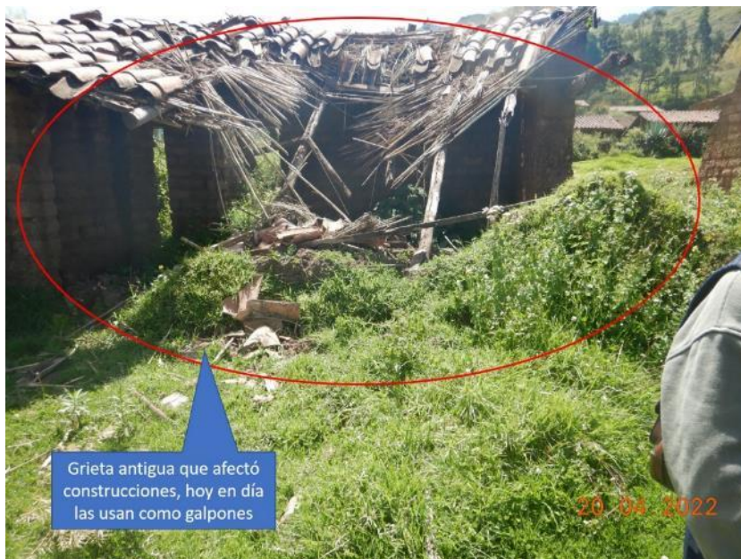
Figura 10: En años anteriores se construyeron bloques de viviendas en la zona, las cuales fueron afectadas por reactivaciones antiguas del deslizamiento.
