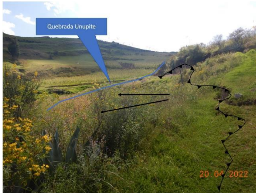
Figura 11: se aprecia la escarpa del deslizamiento que traslada sus materiales a la quebrada Unupite.
