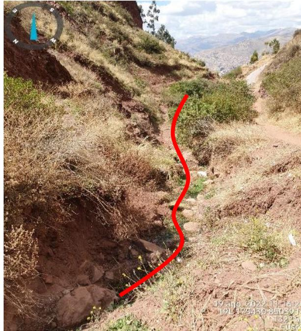
**Materia excedente (desmontes y escombros):** Conformado por material de desmontes, escombros, que fueron depositados producto de la nivelación de terrenos en la parte central de la ladera, donde por antecedentes se identifica que hubo la presencia de una cárcava, hacia la parte baja de la quebrada en la margen izquierda.
