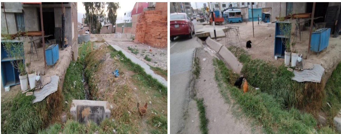
Punto 12 se registra aumento de agua del canal donde registra deslizamiento de la defensa rivereña.
