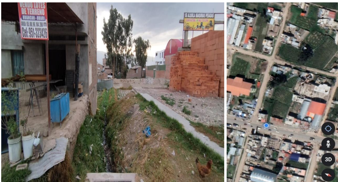
Punto 13 se registra inundación dentro y fuera de las viviendas por el aumento de agua pluvial en temporadas de lluvias fuertes.
