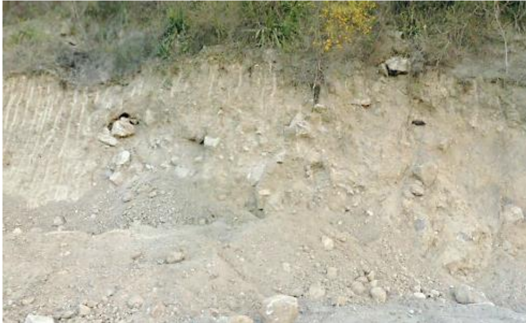
Fotografía 2. Se observa un depósito coluvio – deluvial, compuesto por bloques y gravas de origen calcáreo, en matriz limo arcillosa.
