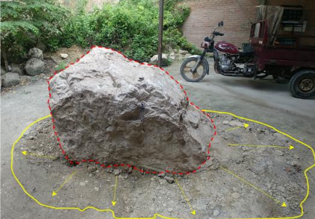
Figura 15. Debido al impacto del bloque caído en el patio de una vivienda, se aprecia el deterioro del suelo.
