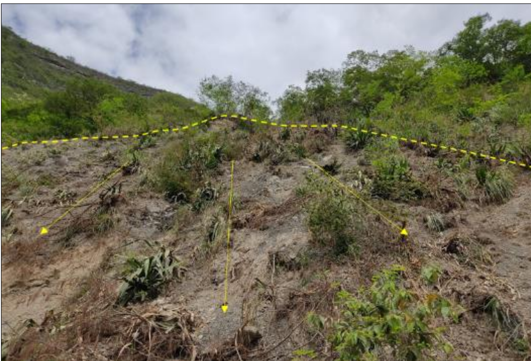
Figura 14. Se observa el deterioro y pérdida de la cobertura vegetal, originada por el trayecto de los bloques desprendidos de la parte alta (caída de rocas).
