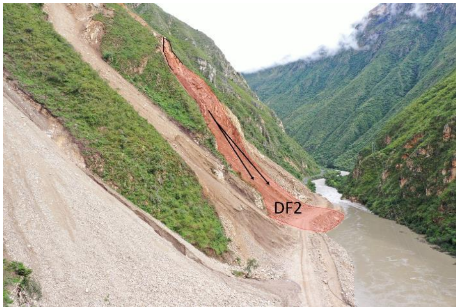
Figura 7. En coordenada UTM: 714495E; 8422222N, se aprecia el derrumbe flujo DF2 con la dirección N93° que toma.
