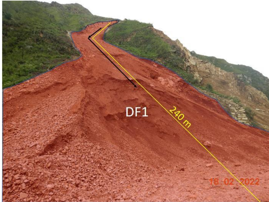
Figura 6. En coordenada UTM: 714508E; 8422170N, se aprecia el derrumbe flujo DF1 con la dirección que toma luego de 130 m de recorrido.
