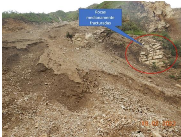
Figura 2. Se aprecia un afloramiento de tonalitas medianamente fracturadas, factor principal para la ocurrencia de derrumbes.
