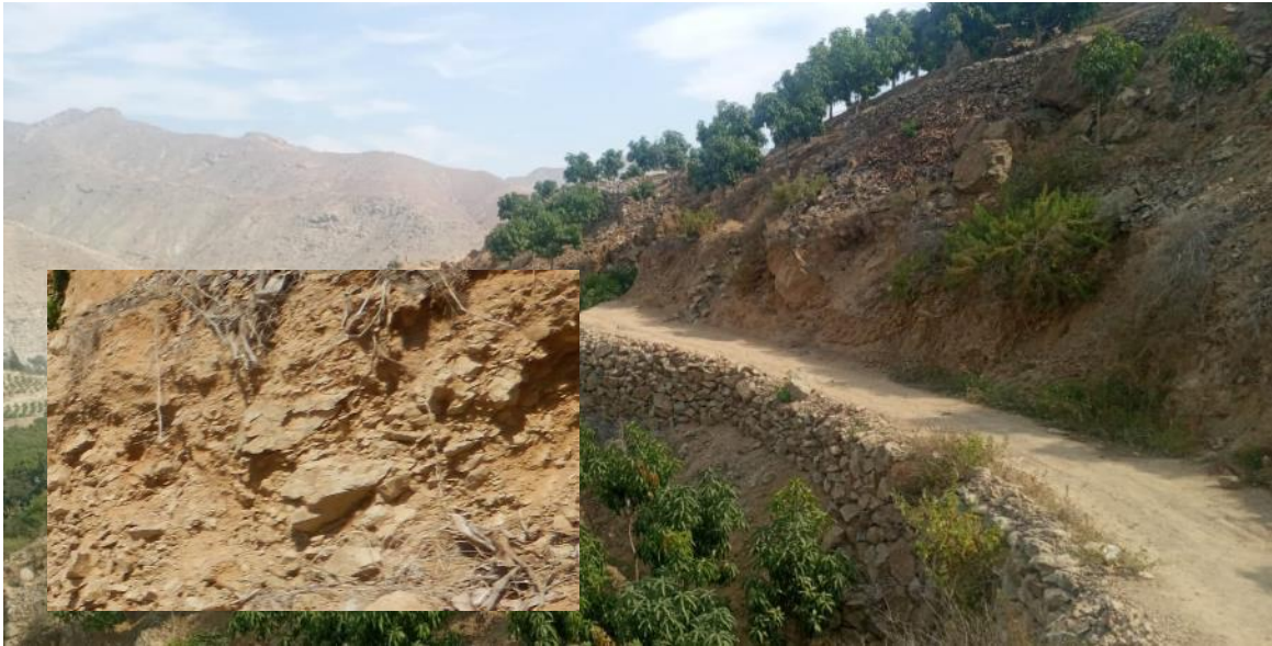
Fotografía 3. Vista de los depósitos coluvio deluviales en la ladera afectada por el deslizamiento.
