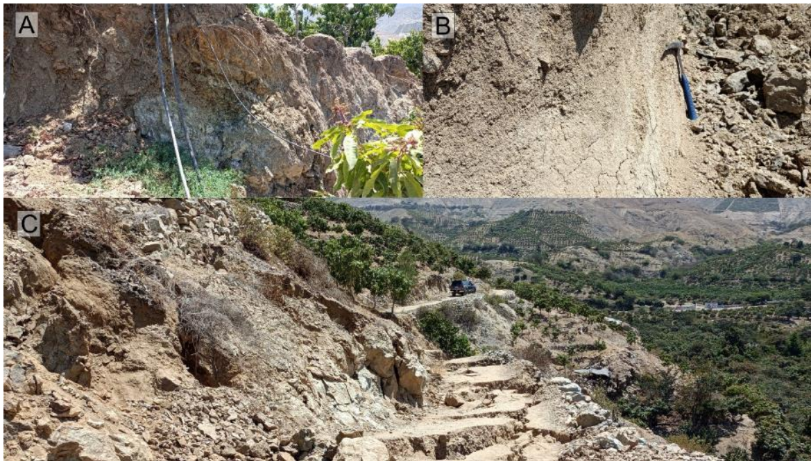
Figura 16. A. Rocas fuertemente fracturadas. B. Estrías de desplazamiento. C. Trocha carrozable afectada ubicada en el cuerpo del deslizamiento.
