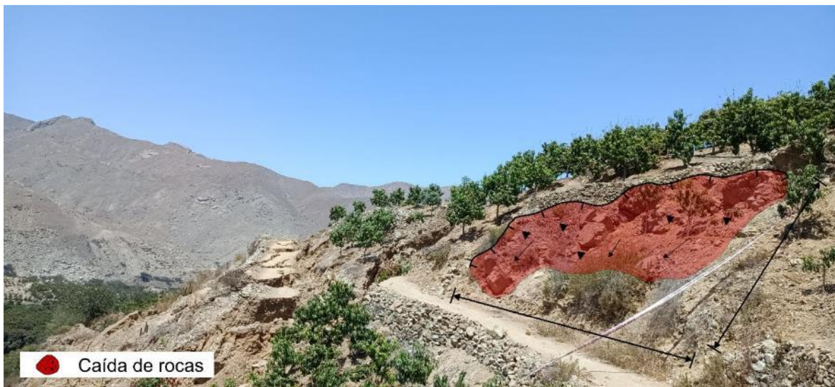
Figura 17. Caída de rocas en el flanco izquierdo del deslizamiento Mishiruri.
