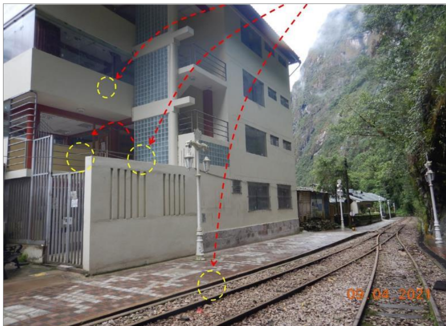
Figura 6. Vista tomada en coordenadas E 768107; N 8544511. Se aprecia el Poder Judicial que fue afectado por caída de rocas, proveniente del cerro Putucusi.
