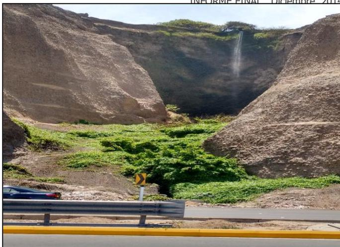
La descarga del canal Lateral San Isidro, actualmente se encuentra en mejoramiento por EMAPE, quienes están realizando trabajos en la Costanera. Dicho canal será entubado con tubería de HDPE, por lo que los peligros por erosión serán controlados.
