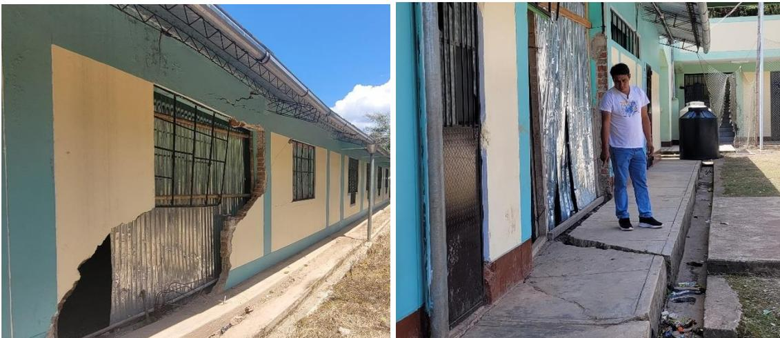
**Fotografía 3.** Agrietamiento y colapso de muros en la I. E. 16433. **Ubicación:** E: 763098; N: 9316653; Z: 1621.
