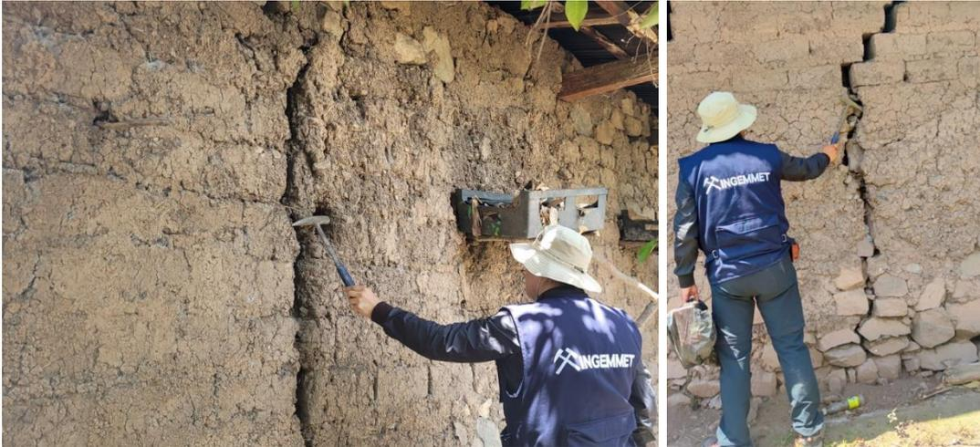
**Fotografía 6.** Agrietamientos en una vivienda de la parte baja del caserío Musungate. **Ubicación:** E: 762405; N: 9316706; Z: 1375.
