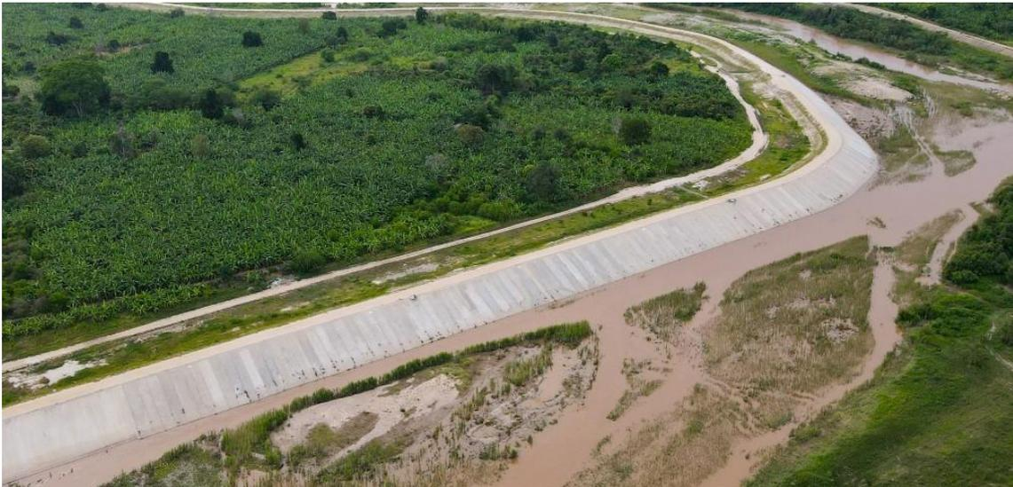
**Fotografía 4.** Ejemplo de una defensa ribereña con un muro de concreto.
