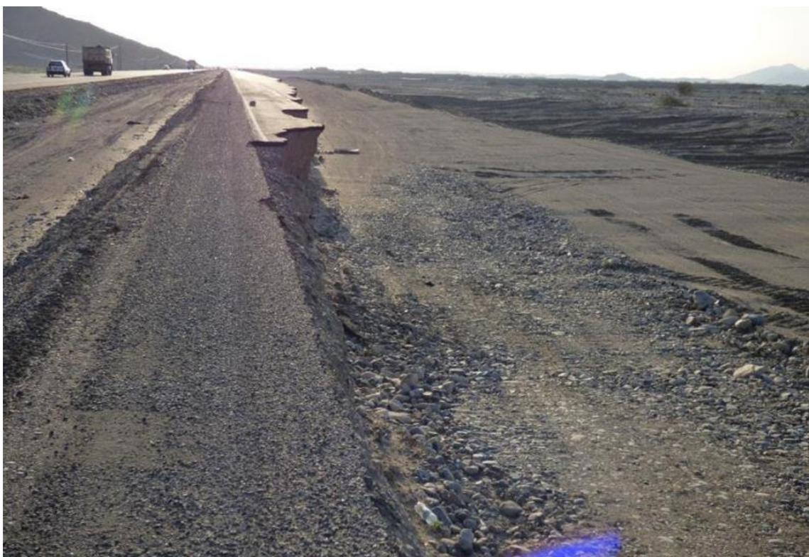
**Figura 8.** Evaluación de los daños en la vía PE-1N debido al desborde la Quebrada Cupisnique. **Fuente:** Medina Allcca et al., 2017.
