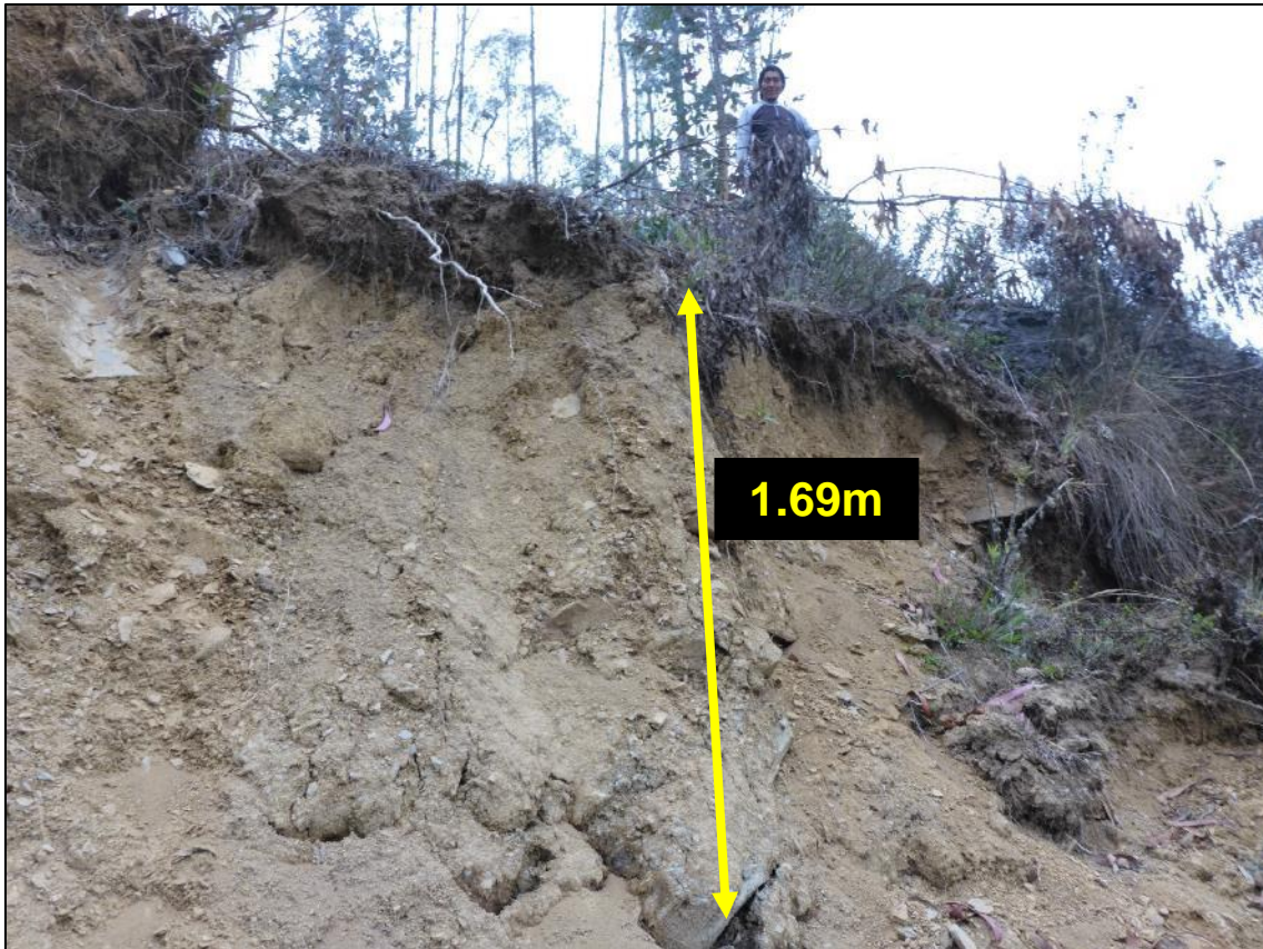
Figura 7. Escarpe secundario 1 en la parte superior del deslizamiento antiguo sector de Suara (coordenadas UTM E: 450472, N: 8413375).
