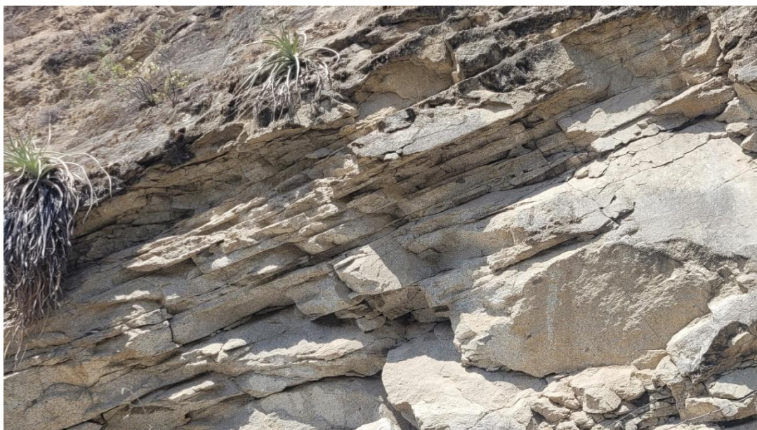
Fotografía 1: Talud donde se observa el macizo del intrusivo diorita – granodiorita Balsas, muy fracturado y ligeramente meteorizado. Coordenada UTM WGS-84, 18S: E: 169483; N: 9241394; altitud:1156 m s.n.m.
