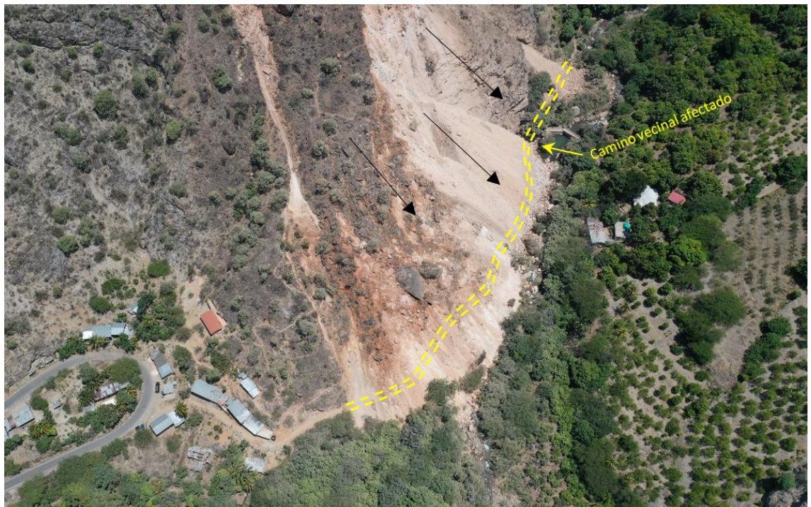
Figura 12. Camino vecinal afectado por el deslizamiento (líneas amarillas punteadas).
