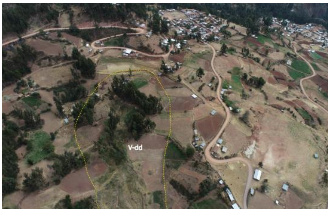
Figura 9. Vista de la subunidad de vertiente con depósito de deslizamiento (V-dd) ubicado en la Comunidad de Accho Capillapata, originado por procesos de movimientos en masa de tipo deslizamientos antiguos y actuales.
