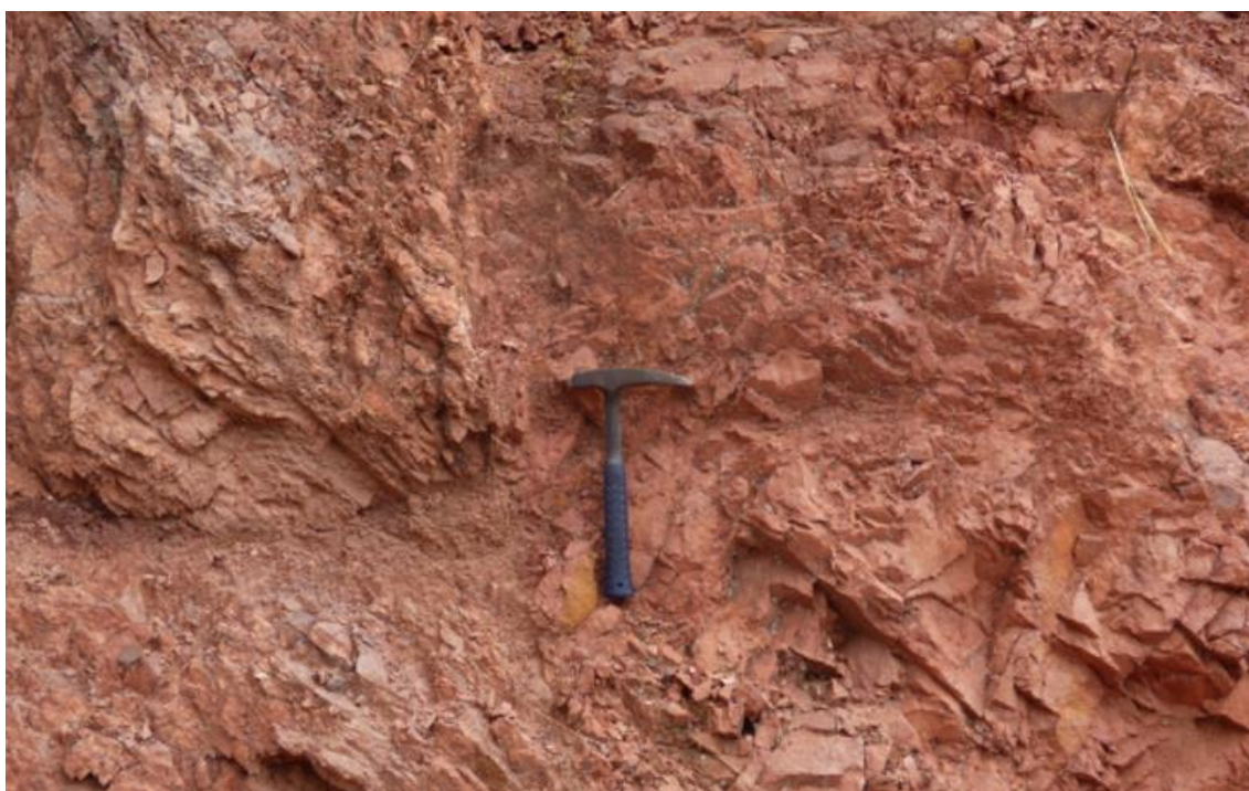
Fotografía 2. Detalle de las secuencias de areniscas y limolitas rojas intercalada con capas delgadas de calizas y arenisca las cuales se encuentran muy fracturado con espaciamentos próximos a medianamente separadas entre sí (0.05-0.25 m), algo abiertas (0.5-1.0 mm). Superficialmente se encuentran meteorizadas.
