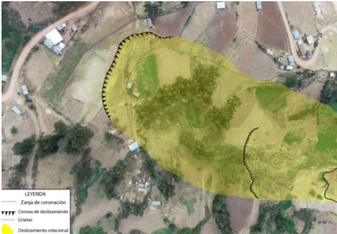
Figura 10. Vista panorámica del deslizamiento de tipo rotacional ocurrido el 22 de julio del 2022 Fuente: Fotografía tomada con dron, agosto-2022
