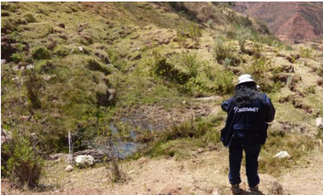
Fotografía 6. Vista de una de las surgencias de aguas subterráneas, ubicada en el cuerpo del deslizamiento.
