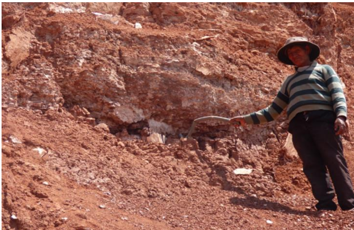
Fotografía 1. Detalle de los conglomerados intercalados con areniscas rojas y contenidos esporádicos de niveles de yeso las cuales se encuentran muy fracturado con espaciamentos próximos a medianamente separadas entre sí (0.05-0.25 m), algo abiertas (0.5-1.0 mm), Superficialmente se encuentran meteorizadas.
