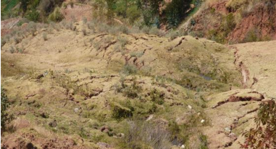
Fotografía 5. Vista de la superficie del terreno bastante agrietada, con longitudes variables de 5 a 20 m y aperturas de hasta 20 cm.
