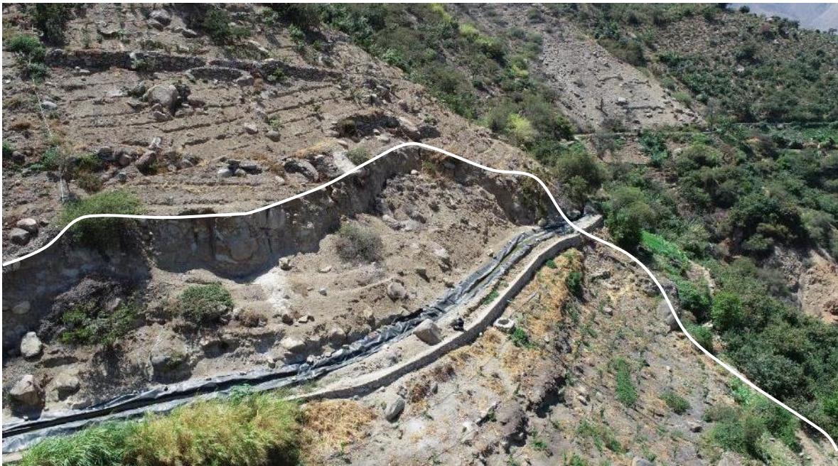
Figura 11. Vista aérea del deslizamiento (DRA) en el sector Minas Pampa.
