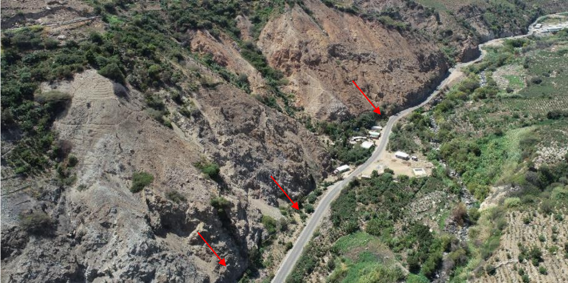
Figura 17. Vista de rocas en la parte inferior del deslizamiento DRA.
