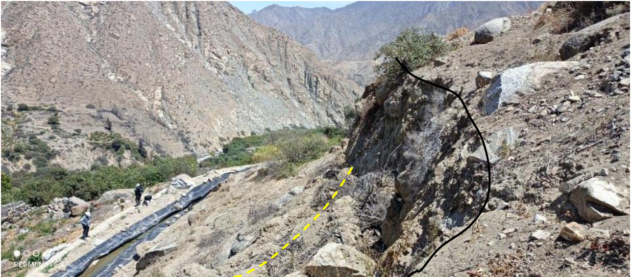
Figura 12. Escarpe visto desde el flanco izquierdo del deslizamiento.
