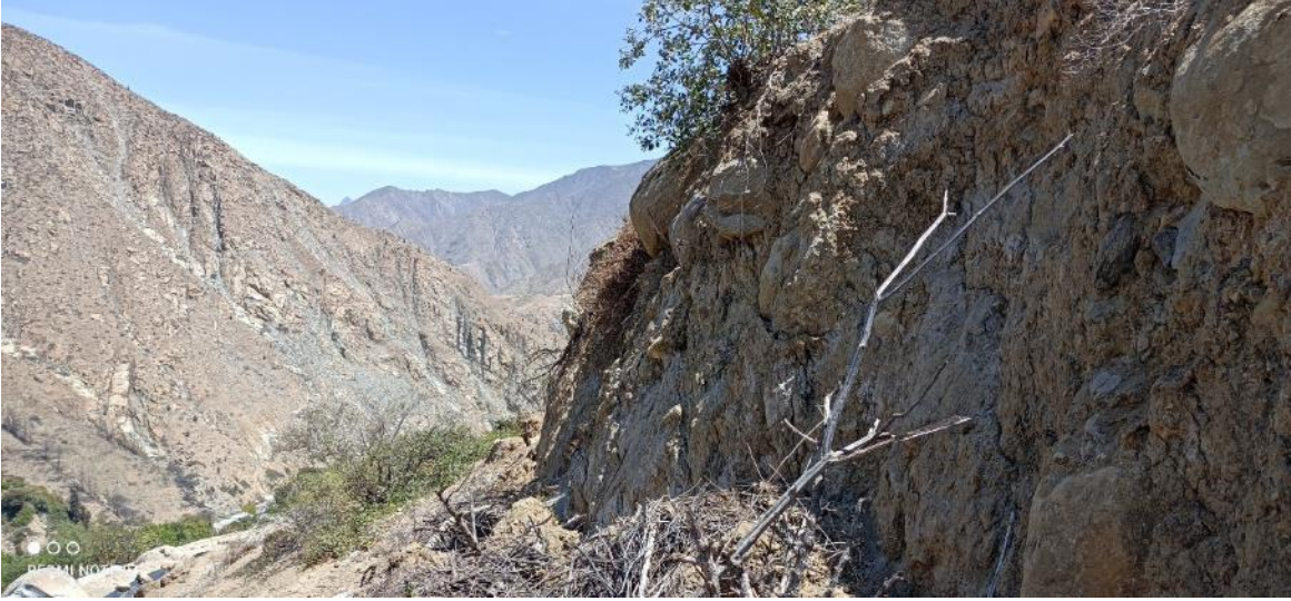
Fotografía 2. Granitos muy fracturados e intensamente meteorizados que aflora en las inmediaciones del deslizamiento.
