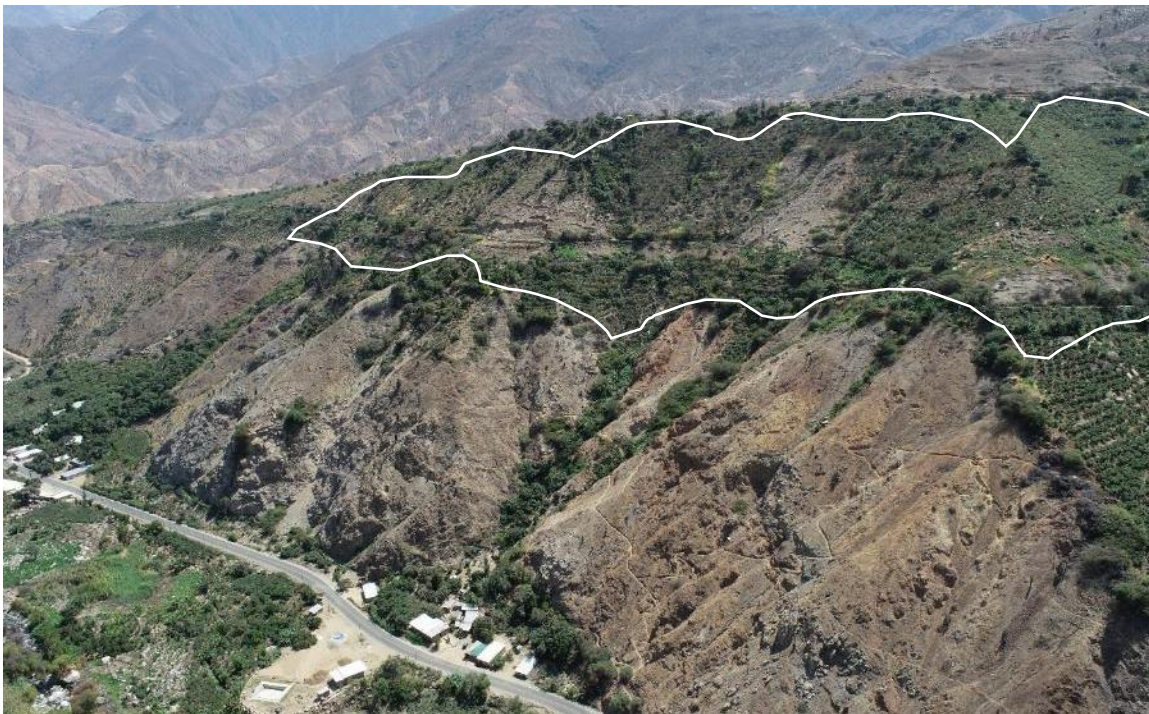
Figura 7. Piedemonte coluvio-deluvial con pendientes muy fuertes a escarpadas.
