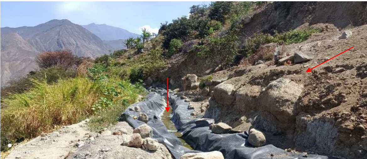
Figura 21. Tramo de 93 m de largo del canal de riego.
