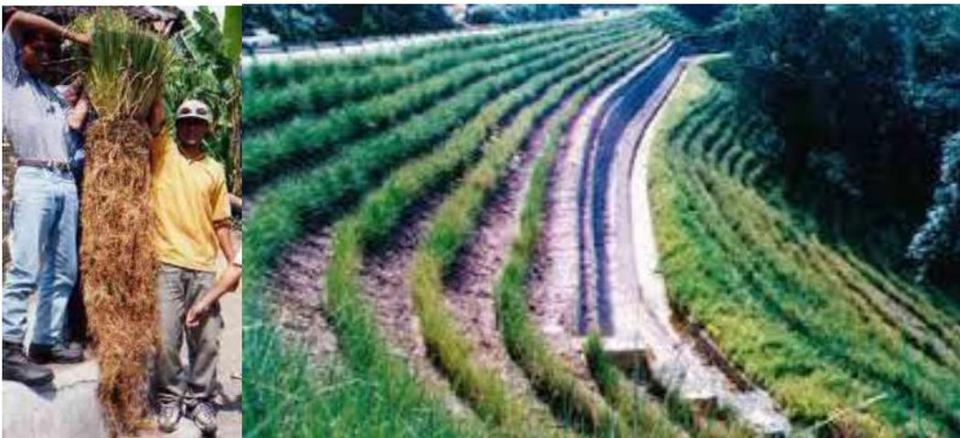
**Fotografía 8.** Ejemplo de bioingeniería con arbusto (vetiver) en taludes de materiales sueltos.
