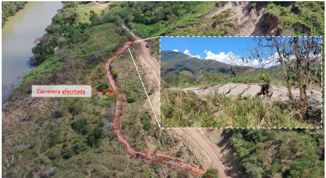
Figura 11. Vía afectada por el deslizamiento (líneas rojas discontinuas).
