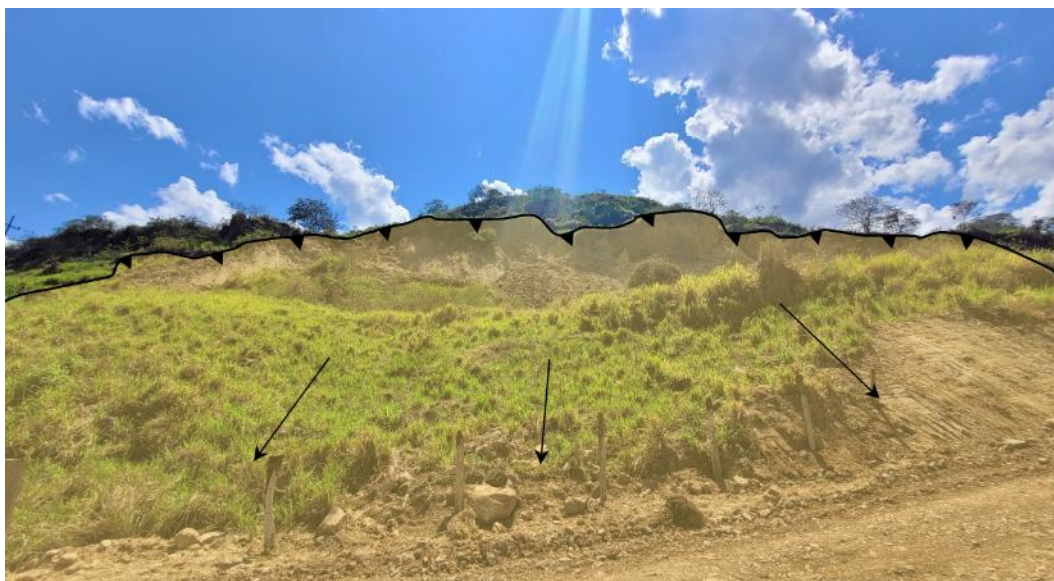
Figura 8. Vista del escarpe de deslizamiento, forma irregular.
