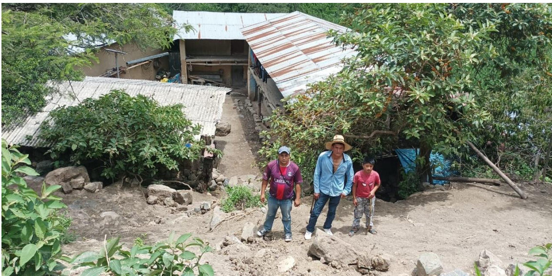
Fotografía 5. Vista de las viviendas en peligro, ubicadas en la parte baja del deslizamiento.
