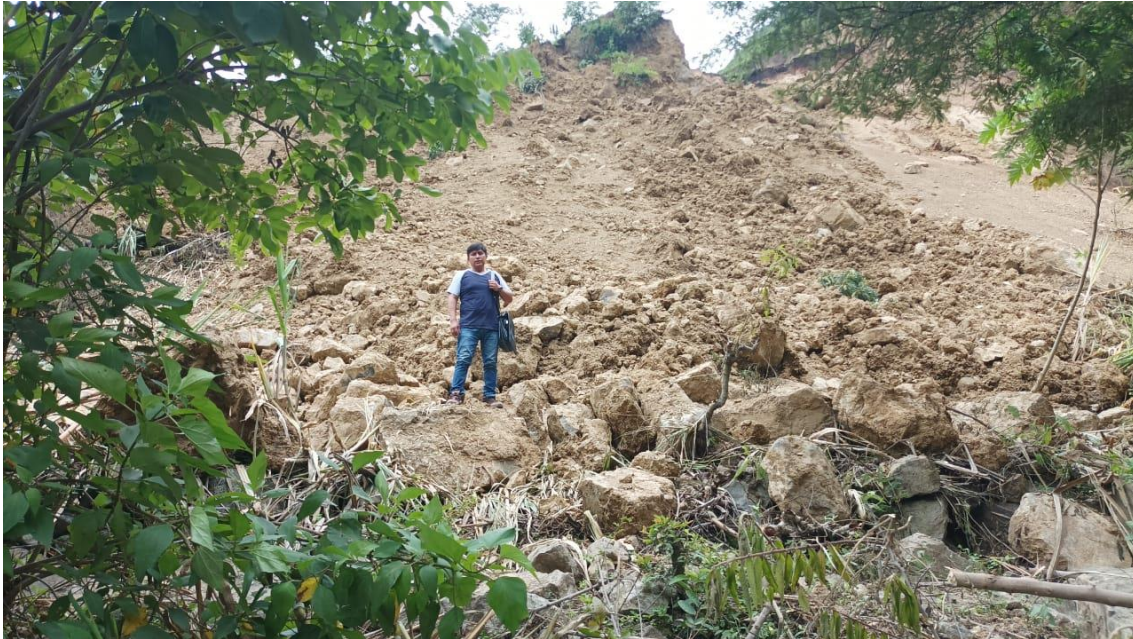
Fotografía 3. Suelos coluvio deluviales originados por el deslizamiento rotacional activo.
