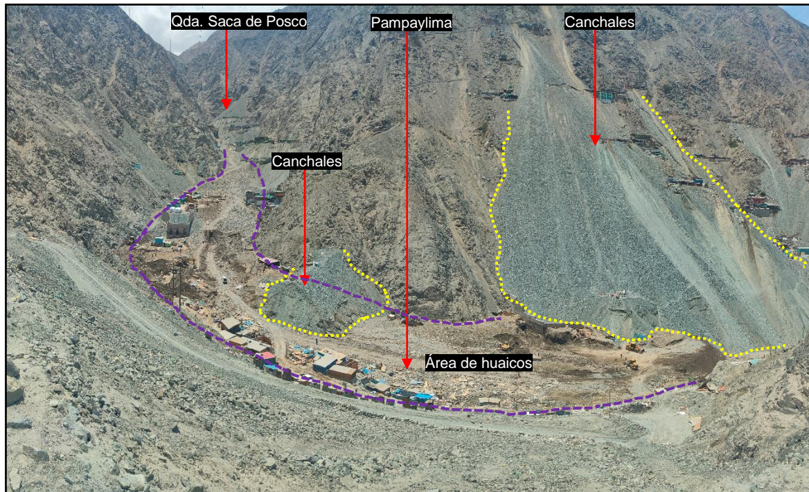
Figura 18. Muestra el área inundable por huaicos (flujo de detritos), en el sector Pampaylima.
