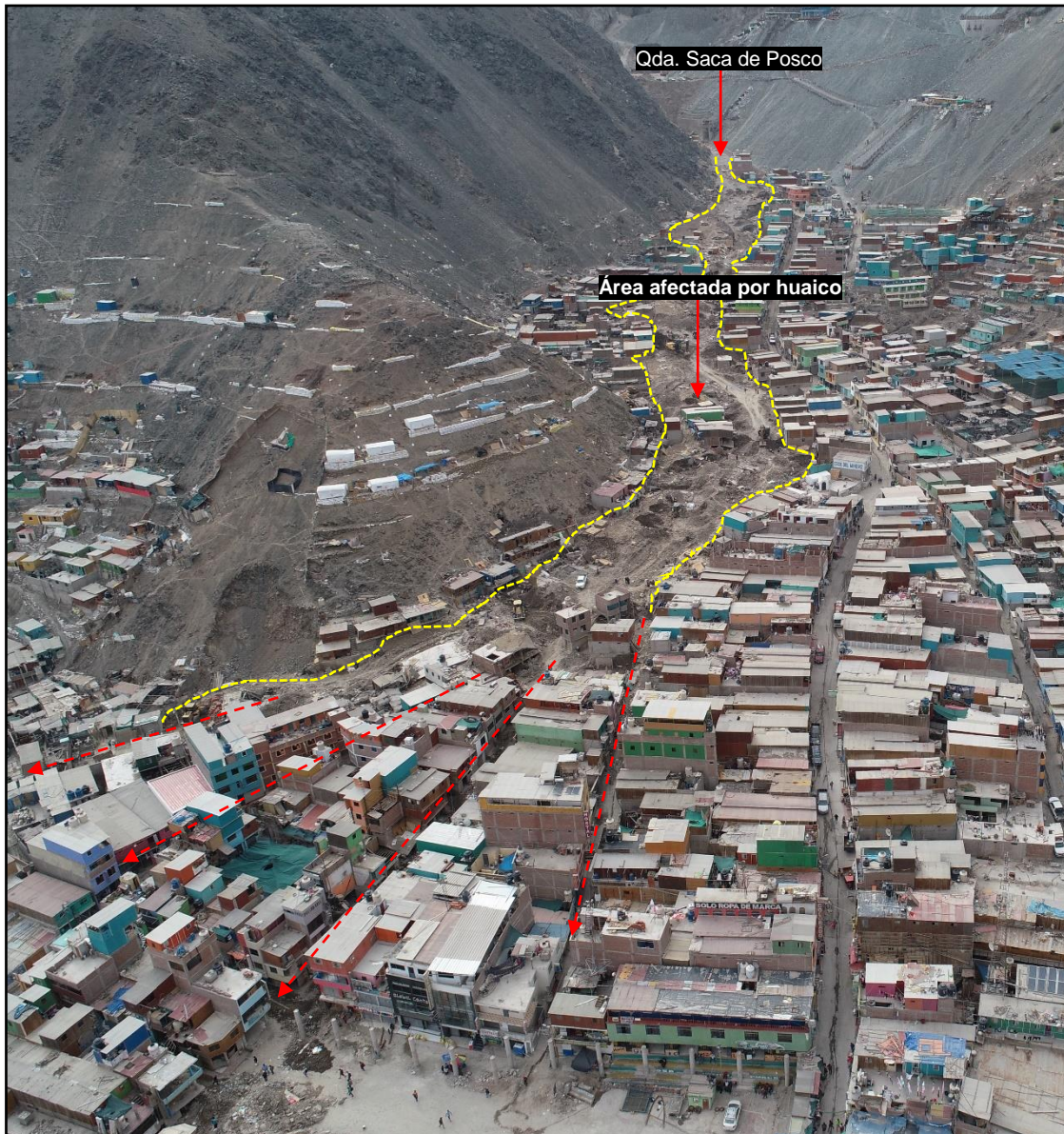
Figura 60. Huaico en la parte inicial del abanico sector Secocha, muestras las calles por las que descendió el flujo.
