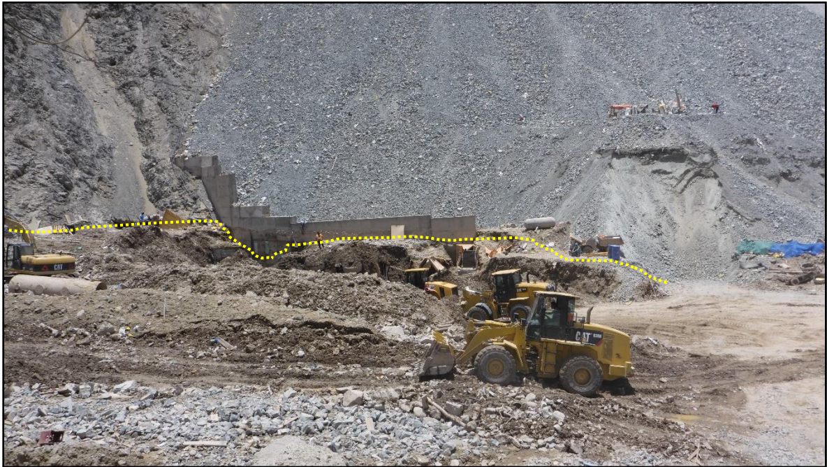
Figura 56. El huaico afecto algunas labores mineras, (coordenadas UTM WGS84: 694387E, 8232882N)
