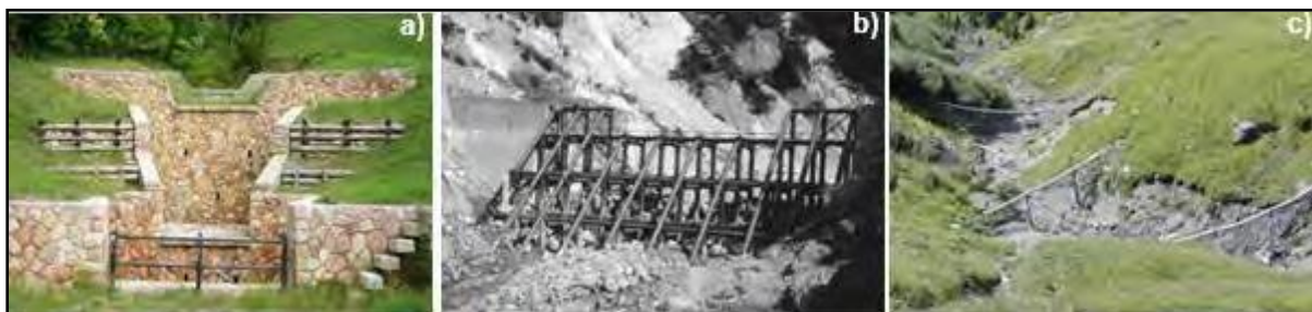
Figura 78. Presas tipo SABO de sedimentación escalonada para controlar la fuerza destructiva de los huacos, a) de control; b) tipo rejilla; c) barras flexibles, (Vilches, 2021)
