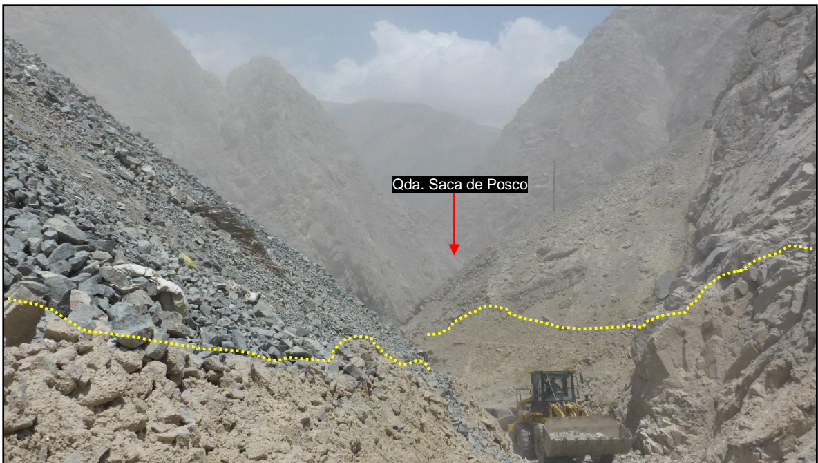
Figura 57. Huella del huaico del 5 de febrero, en la parte baja del sector Pampaylima, (coordenadas UTM WGS84: 694602E, 8232836N)
