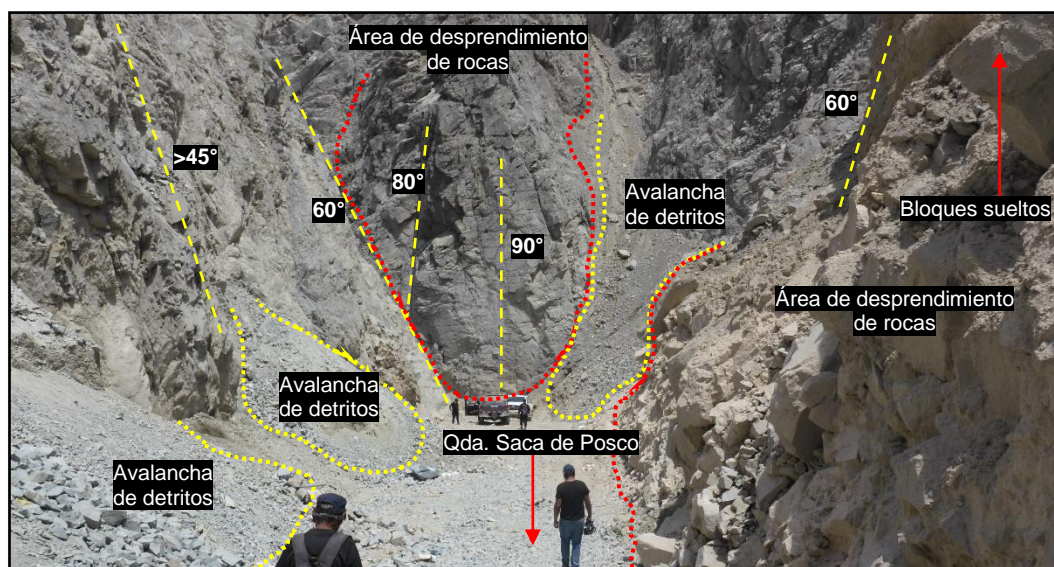
Figura 33. Caída de rocas y avalancha de detritos en el acceso al sector Pampaylima, (coordenadas UTM WGS84: 694636E, 8232809N)
