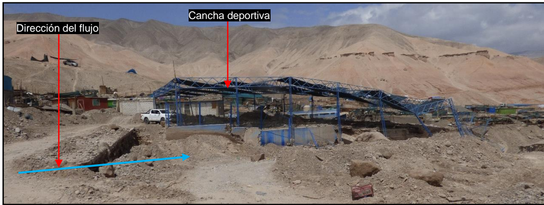
Figura 49. Cancha deportiva ubicada en el cauce de la quebrada, fue afectado por el huaico del 5 de febrero.
