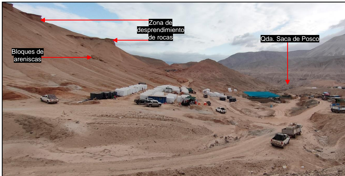
Figura 29. Bloques de areniscas en las laderas ubicadas en el ingreso al sector San Martín, (coordenadas UTM WGS84: 692829E, 8235125N)
