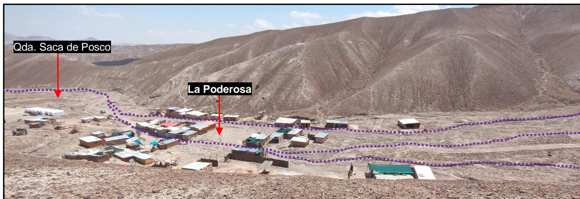
Figura 44. Ramales del huaico del 5 de febrero en el sector La Poderosa
