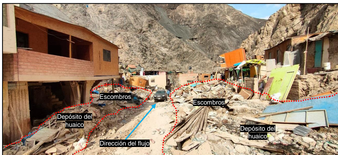
Figura 53. Viviendas afectadas por el huaico del 5 de febrero, sector Posco Misky. Se observa los depósitos de escombros (restos de viviendas arrastradas).
