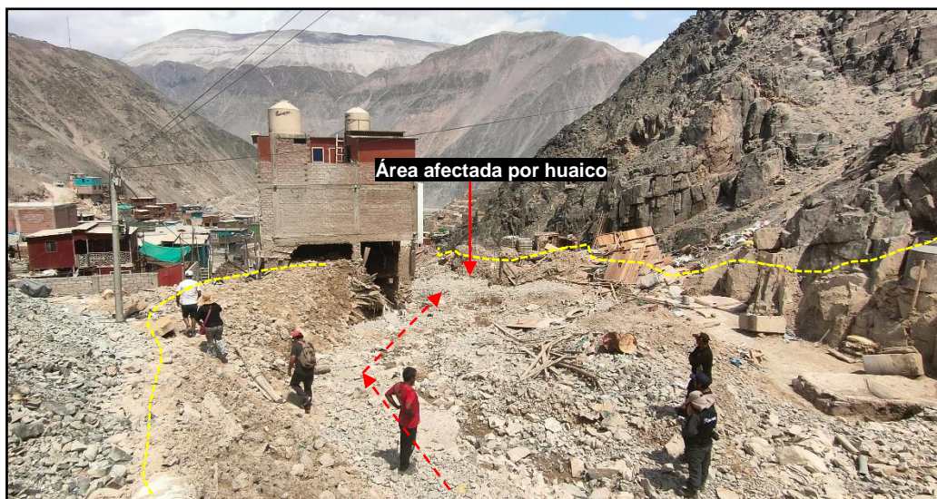
Figura 59. Huaico en la parte inicial del abanico, sector Secocha, (coordenadas UTM WGS84: 695121E, 8232667N)
