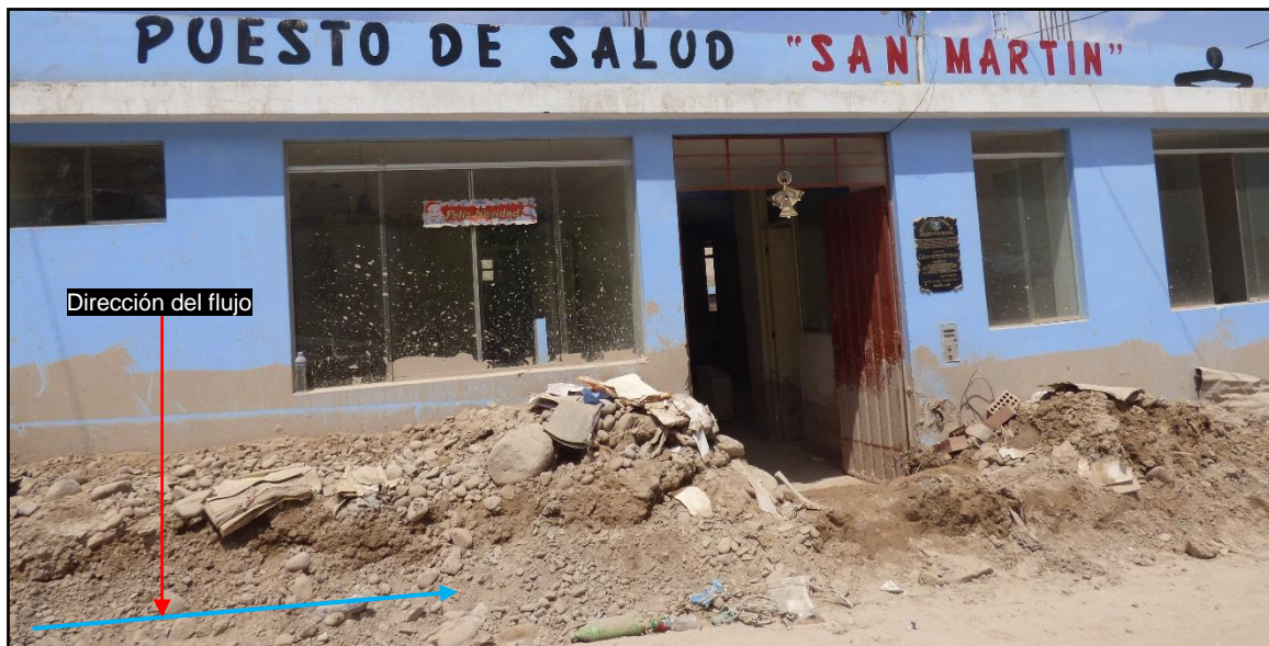
Figura 51. Puesto de salud San Martín ubicado en el cauce de la quebrada, fue afectado por el huaico del 5 de febrero.
