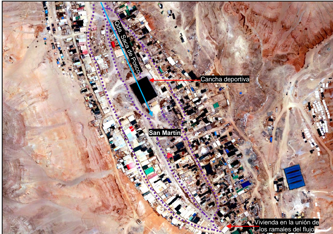
Figura 47. Vista en planta de los ramales del huaico en el sector San Martín
