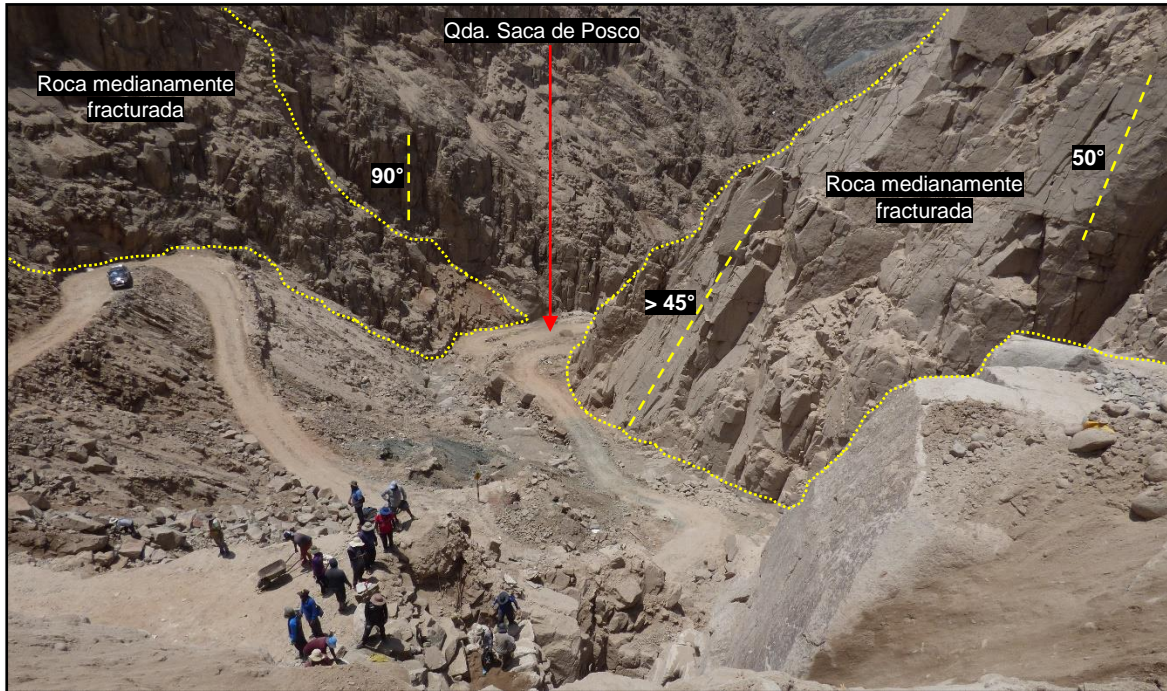
Figura 30. Caída de rocas en el sector Catarata en la entrada al sector Posco Misky, (coordenadas UTM WGS84: 692643E, 8234507N)
