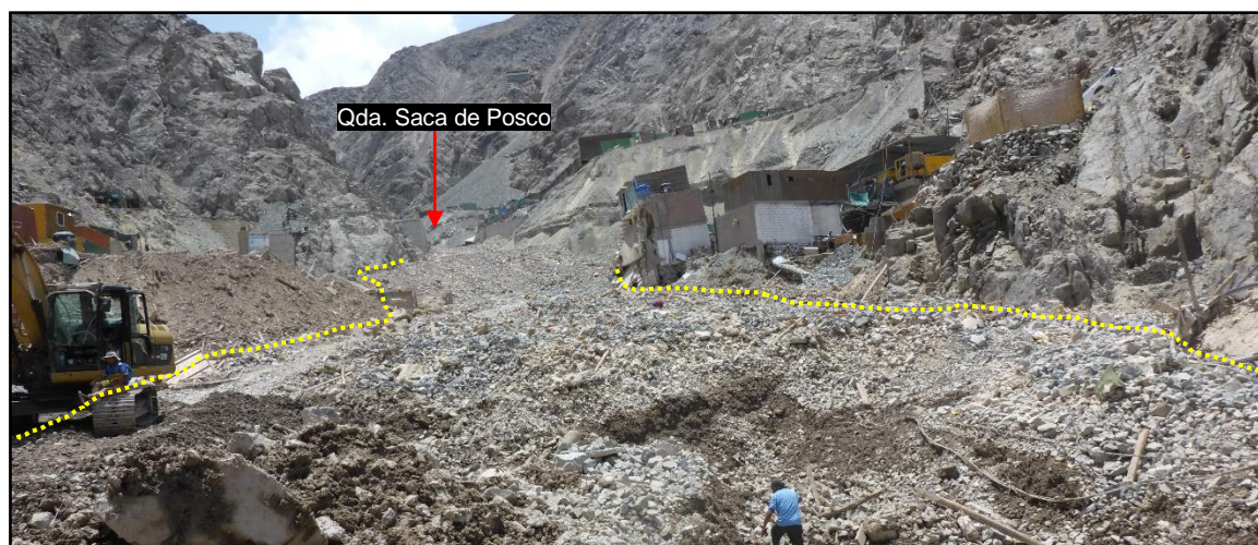
Figura 55. Depósito de huaicos recientes en el sector Pampaylima.
