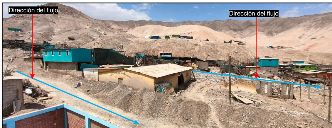
Figura 50. Viviendas afectadas por el huaico del 5 de febrero.
