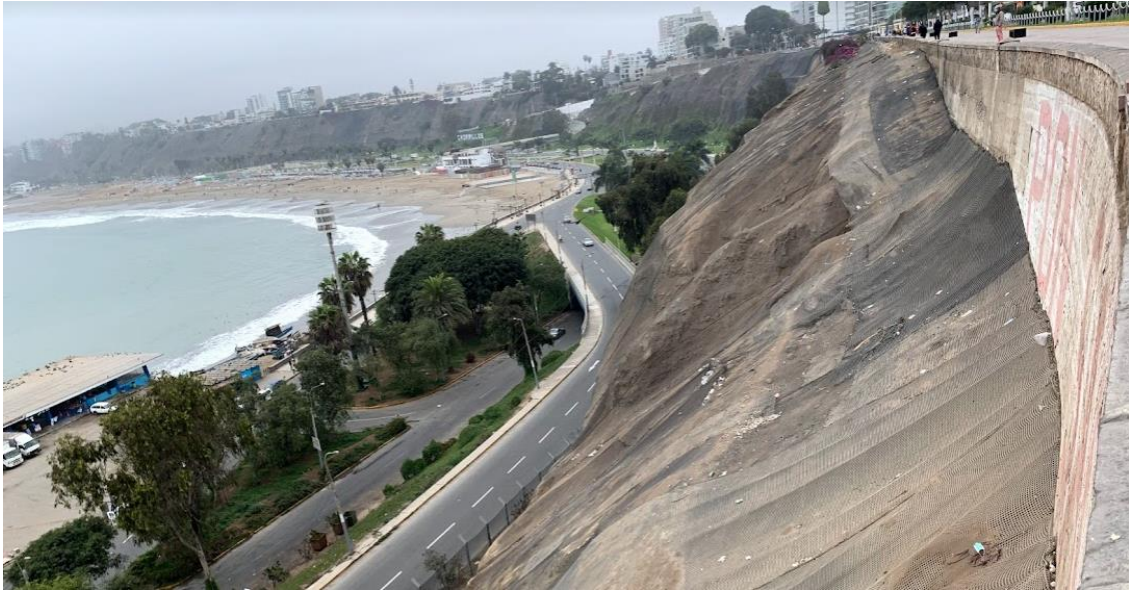
Figura 369. Rellenos antrópicos recientes cubiertos por geomalla.
