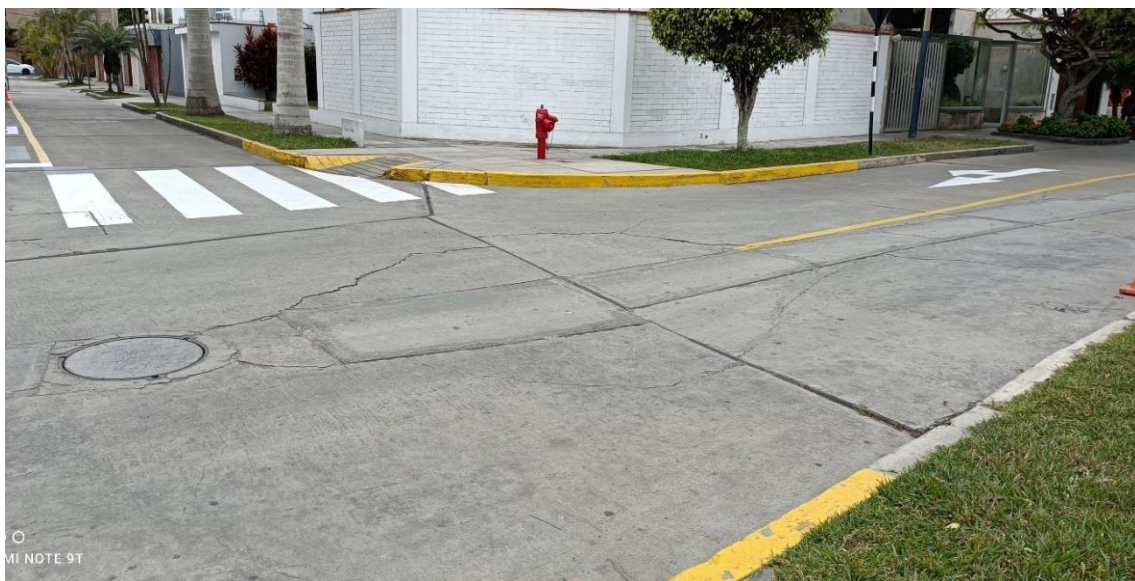
Figura 309. Las grietas tienen forma circular y elongada desplazando pisos, veredas y sardineles.
