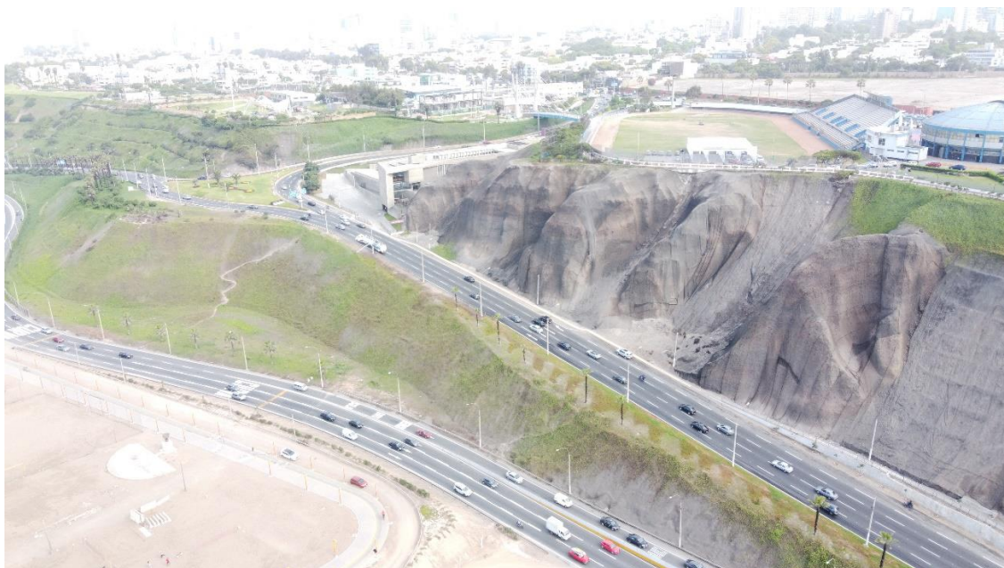
Figura 164. Bajada hacia playa Los Delfines, terraplén realizado por corte y relleno del acantilado de la Costa Verde en el distrito de Miraflores.
