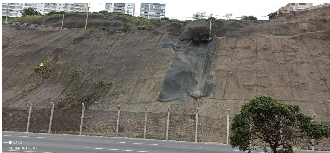
Figura 131. Vista hacia la Bajada Brasil donde se identificaron cárcavas cubiertas por geomalla.
