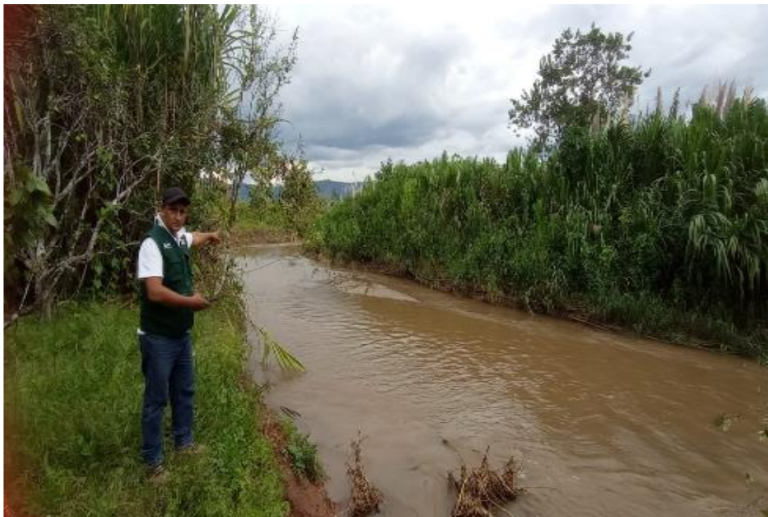
FIGURA N°01: TRAMO CRÍTICO EN EL RIO ANDÁ , EN LA LOCALIDAD DE SANTO DOMINGO DE ANDA, DISTRITO SANTO DOMINGO DE ANDA - PROVINCIA DE LEONCIO PRADO - HUÁNUCO
