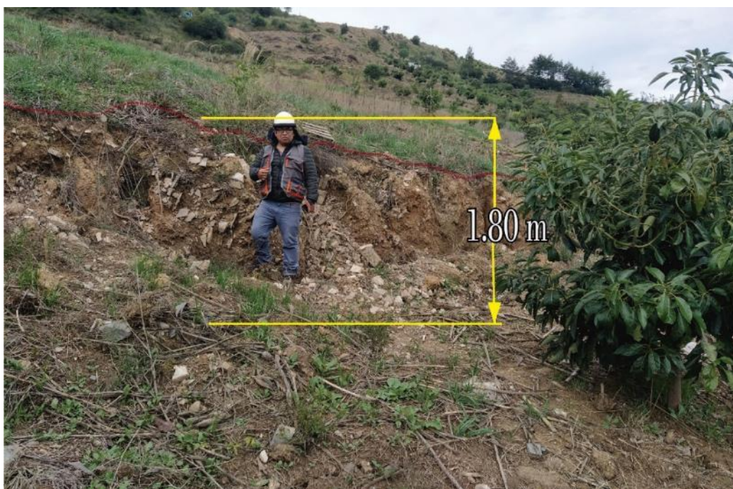
Figura 14. Salto de escarpe principal de 1.8 m.
