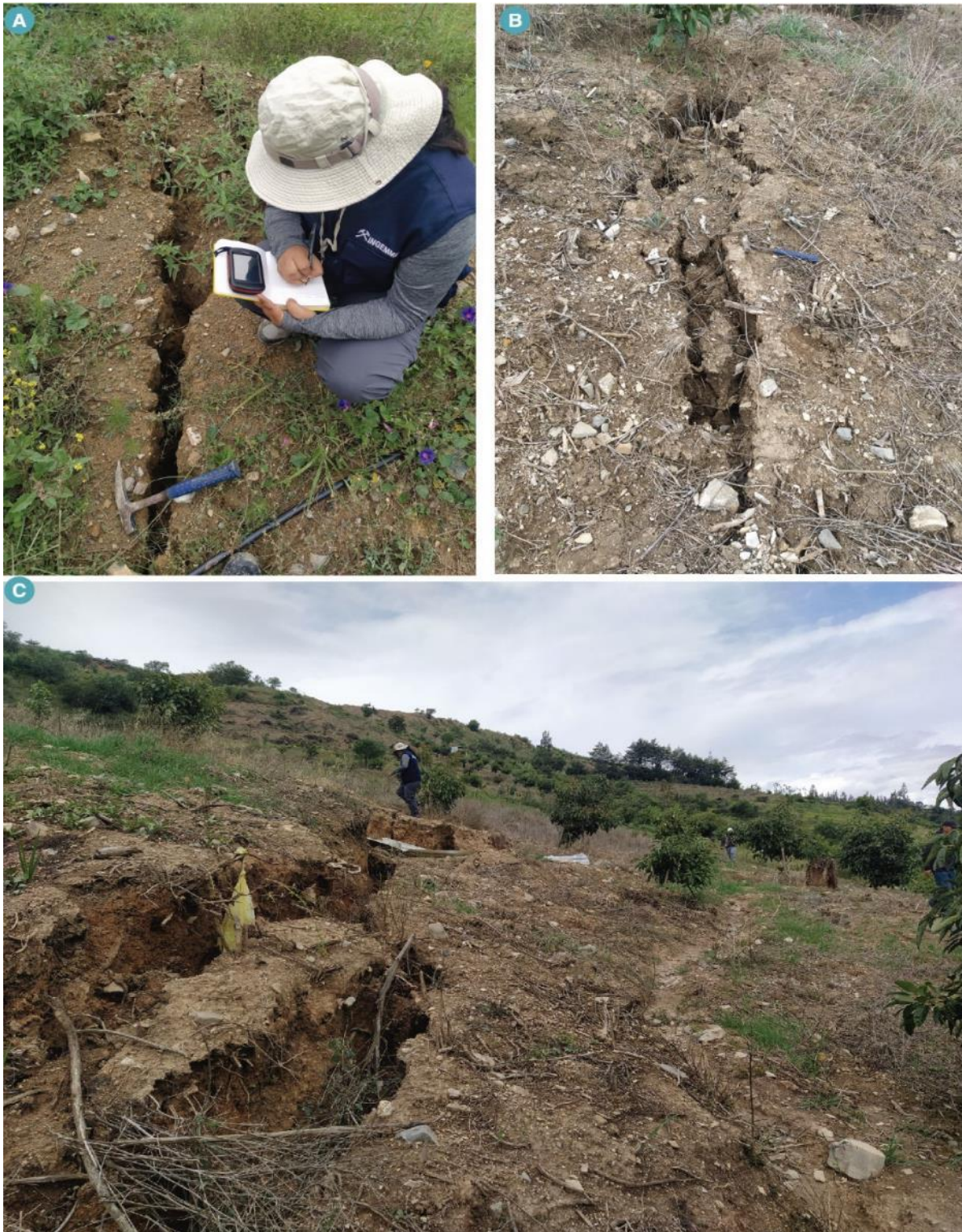
Figura 20. A, muestra agrietamientos relacionados al deslizamiento 02, B y C, muestran agrietamientos del deslizamiento 01.
