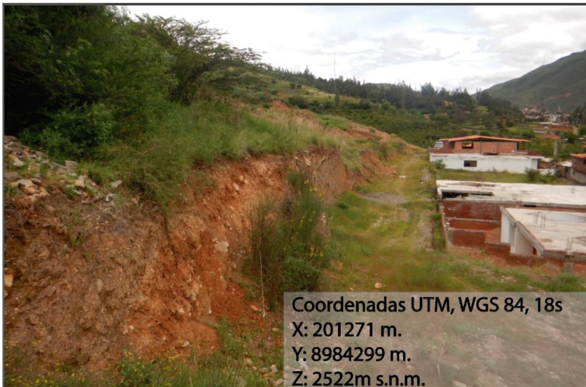
Figura 9. Depósitos coluvio-deluviales ubicados en la coordenada UTM WGS 84, 18s Este: 201271 y Norte: 8984299. Por encima de las casas con agrietamientos.
