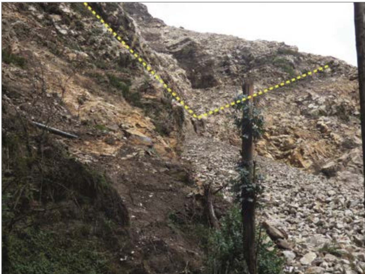
Figura 6: Vista de rotura tipo cuña en la ladera del cerro Cruz de Shallapa.
