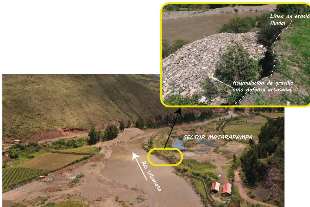
Figura 19. Acumulación de grava artesanal para protección de socavamiento
