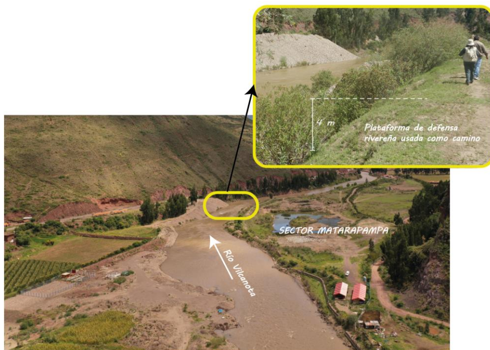
Figura 17. Defensas ribereñas a 4m del cauce del río, en temporada seca.
