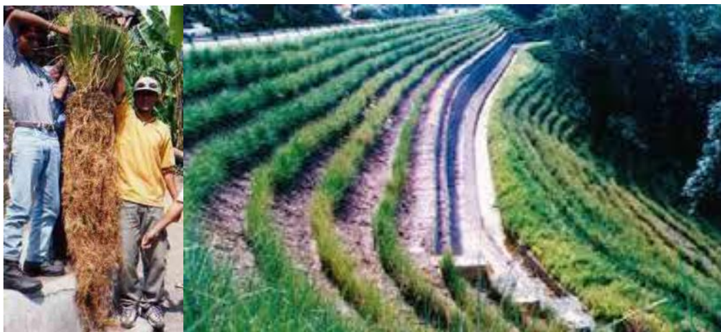
Fotografía 6. Ejemplo de bioingeniería con arbusto (vetiver) en taludes de materiales sueltos.
