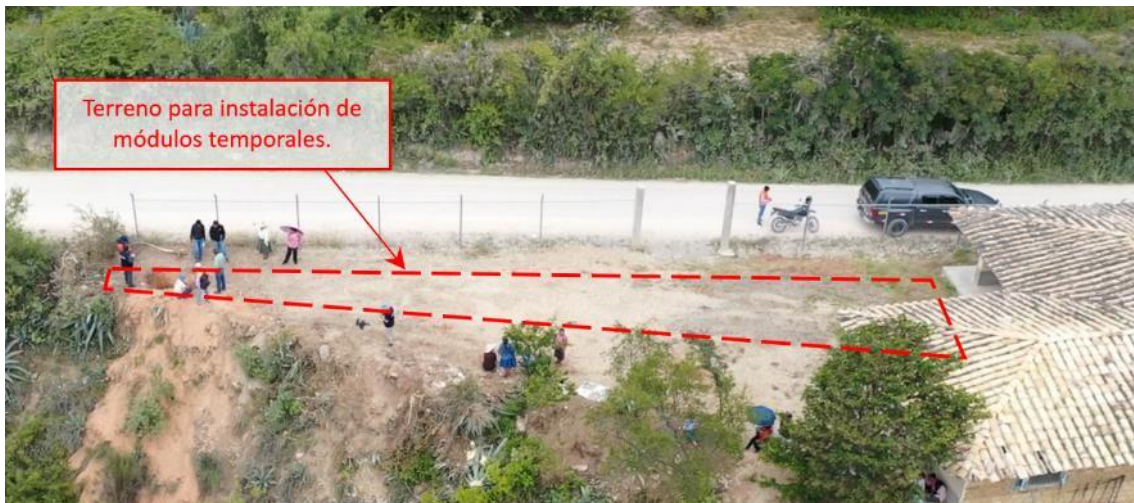
Figura 7. Se observa el terreno inclinado con pendiente suave ( 1^\circ - 5^\circ ), (líneas rojas discontinuas), apto para la instalación de módulos temporales.
