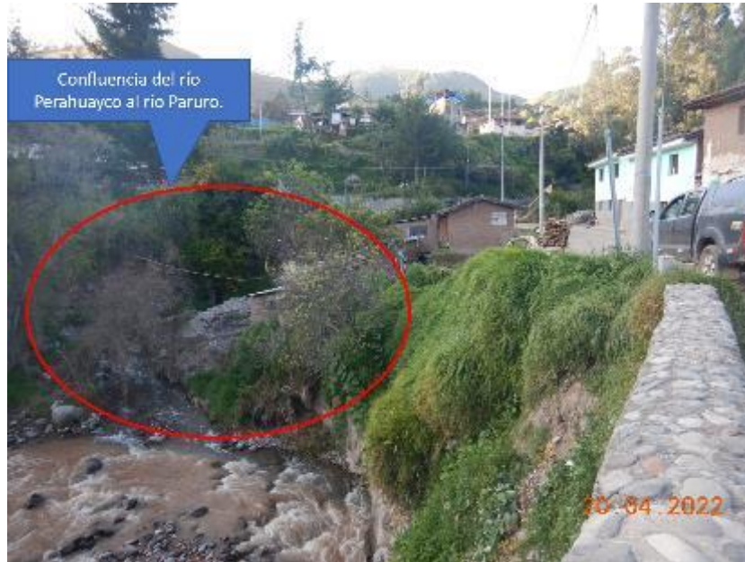
Figura 9: Confluencia del riachuelo Perahuayco al río Paruro, en la orilla izquierda del río Perahuayco se aprecia una vivienda que ya fue afectada anteriormente con crecidas de este río.
