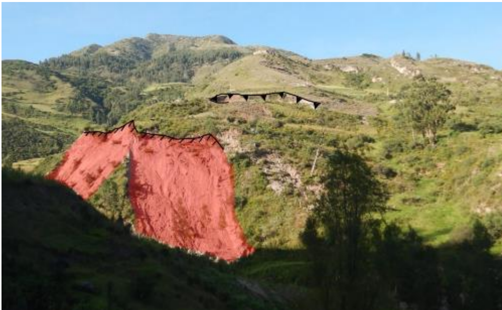
Figura 5: Se aprecia los derrumbes y la escarpa de deslizamiento en el sector Retamachayoc.
