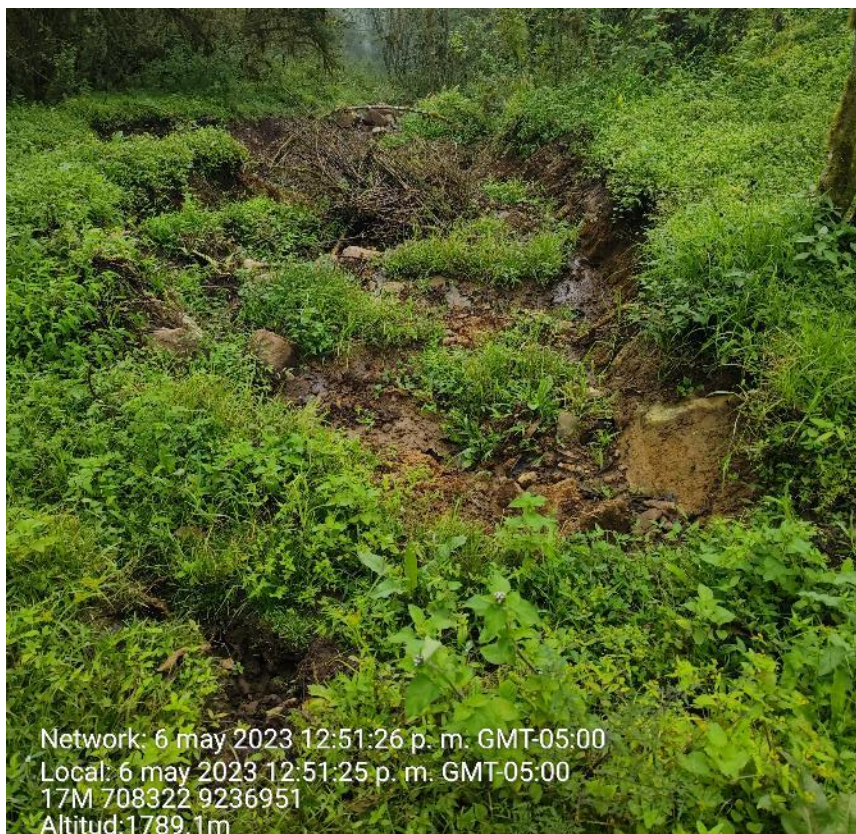
Fotografía 6. Parte baja del deslizamiento DRA2 con abundante agua superficial.
