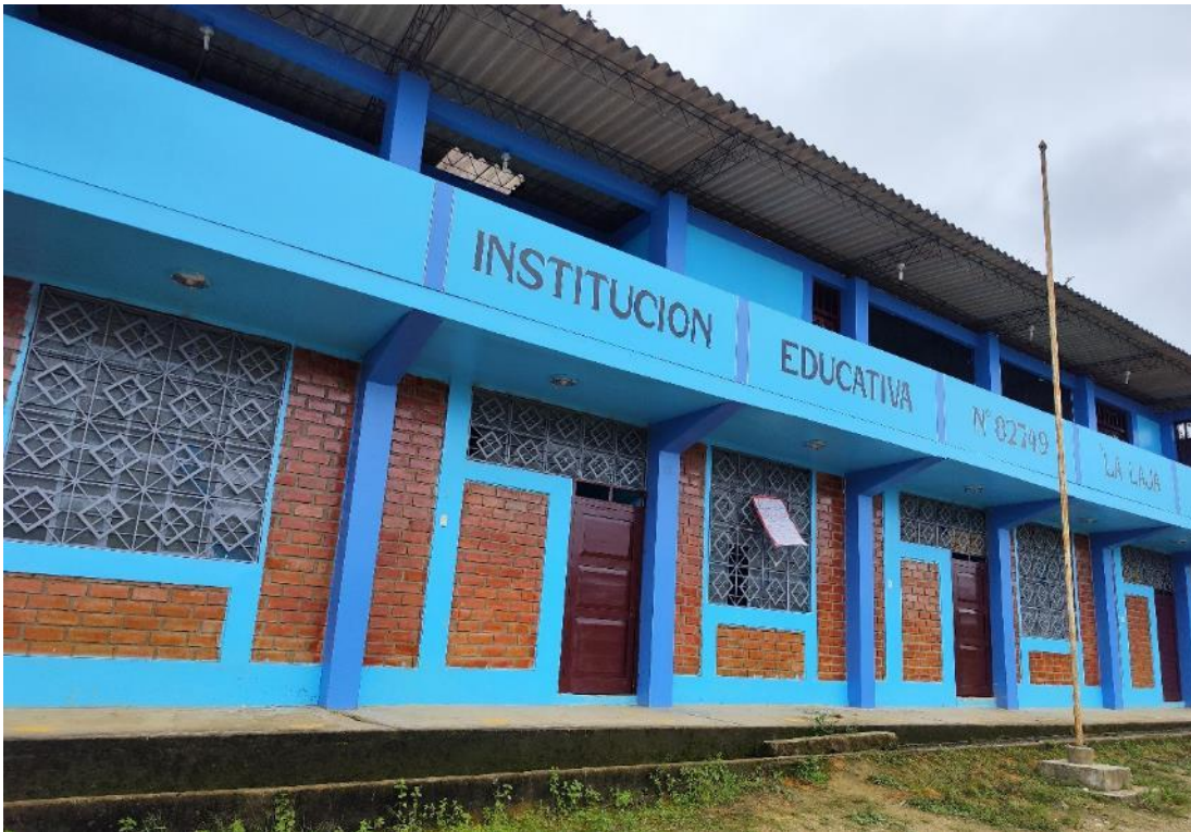
Fotografía 9. Institución educativa N° 82749, ubicada en la parte baja de los deslizamientos activos, en el centro poblado La Laja.
