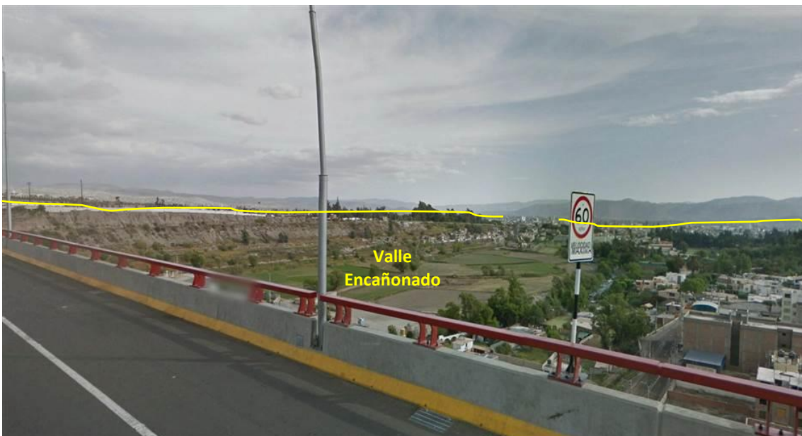
Figura 11. Vista de sur a norte del del valle encañonado desde el puente Chilina.
