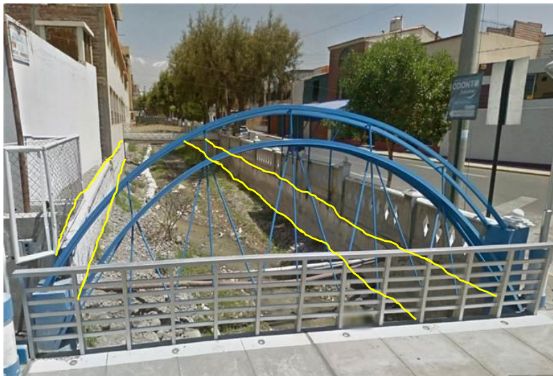
Figura 12. Muros improvisados que encauzan la quebrada Chullo.
