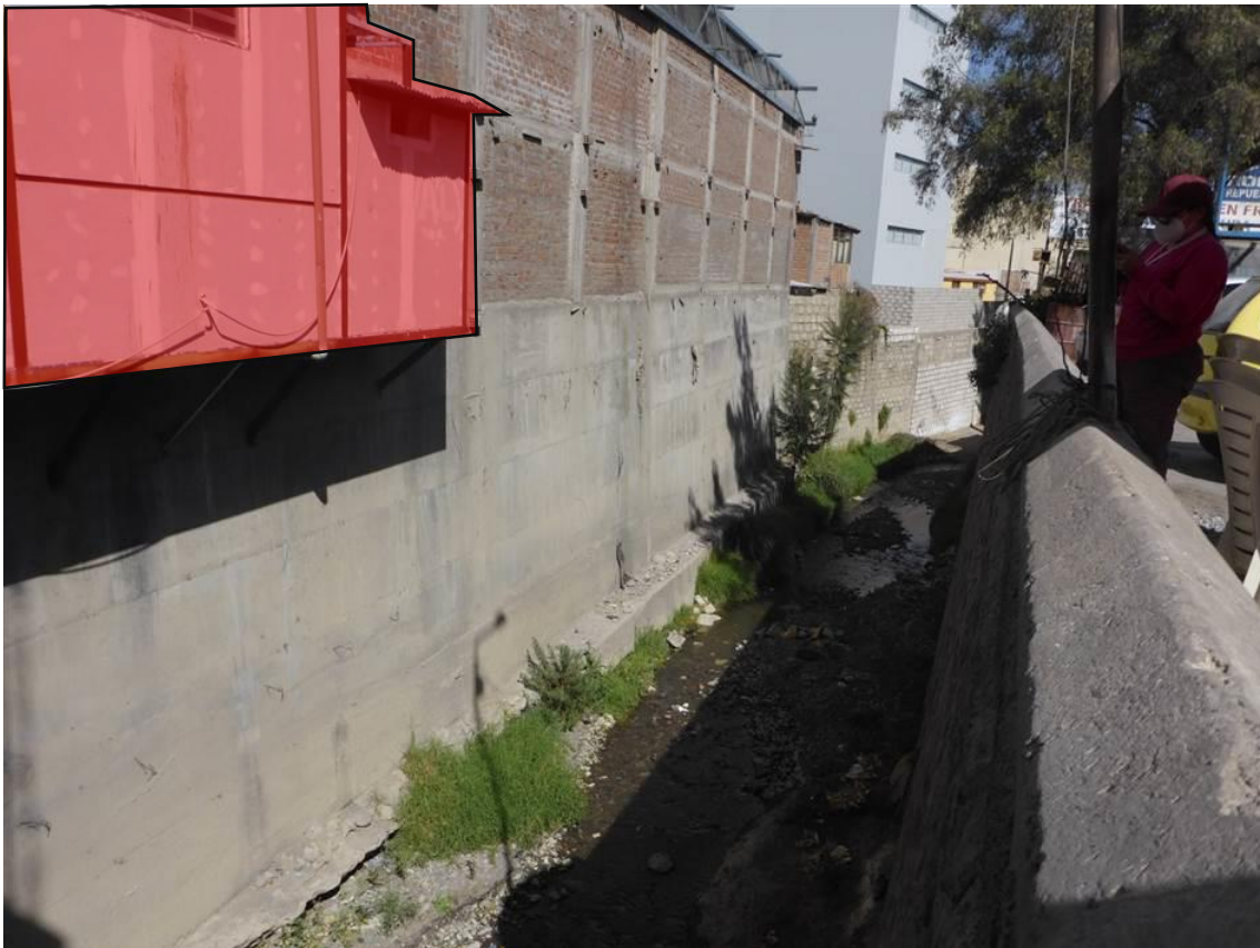
Figura 20. Viviendas sobrepasando el muro en la Qda. Chullo. Coord. UTM: 227551.5 E, 8185249.5 N.
